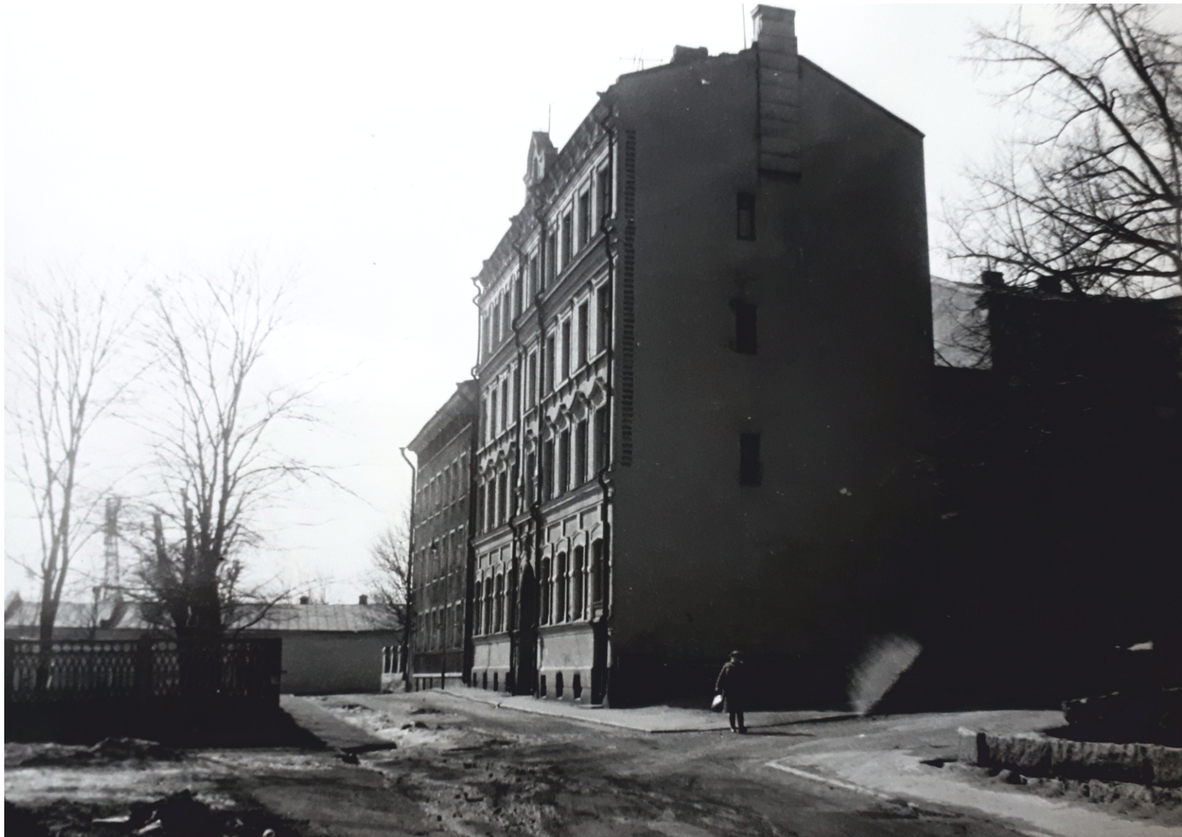
Илл. 10. Ул. Титова в сторону перекрестка с Выборгской ул. « Проект зон охраны. г. Выборг. Предпроектные исследования. Р.Іа, т.І. Анкеты обследования застройки». кн.2. ЛФИ СПР. 1982 г. Архив ККЛО, № 282-49
