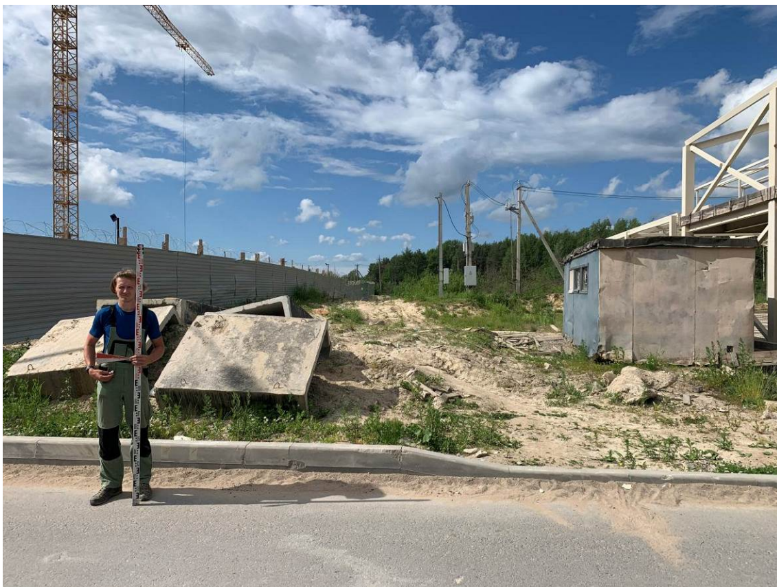
Илл. 29. Ленинградская обл., Всеволожский р-н, Муринское городское поселение. Общий вид участка обследования. Точка съемки 8. Вид с ЮЮВ.
