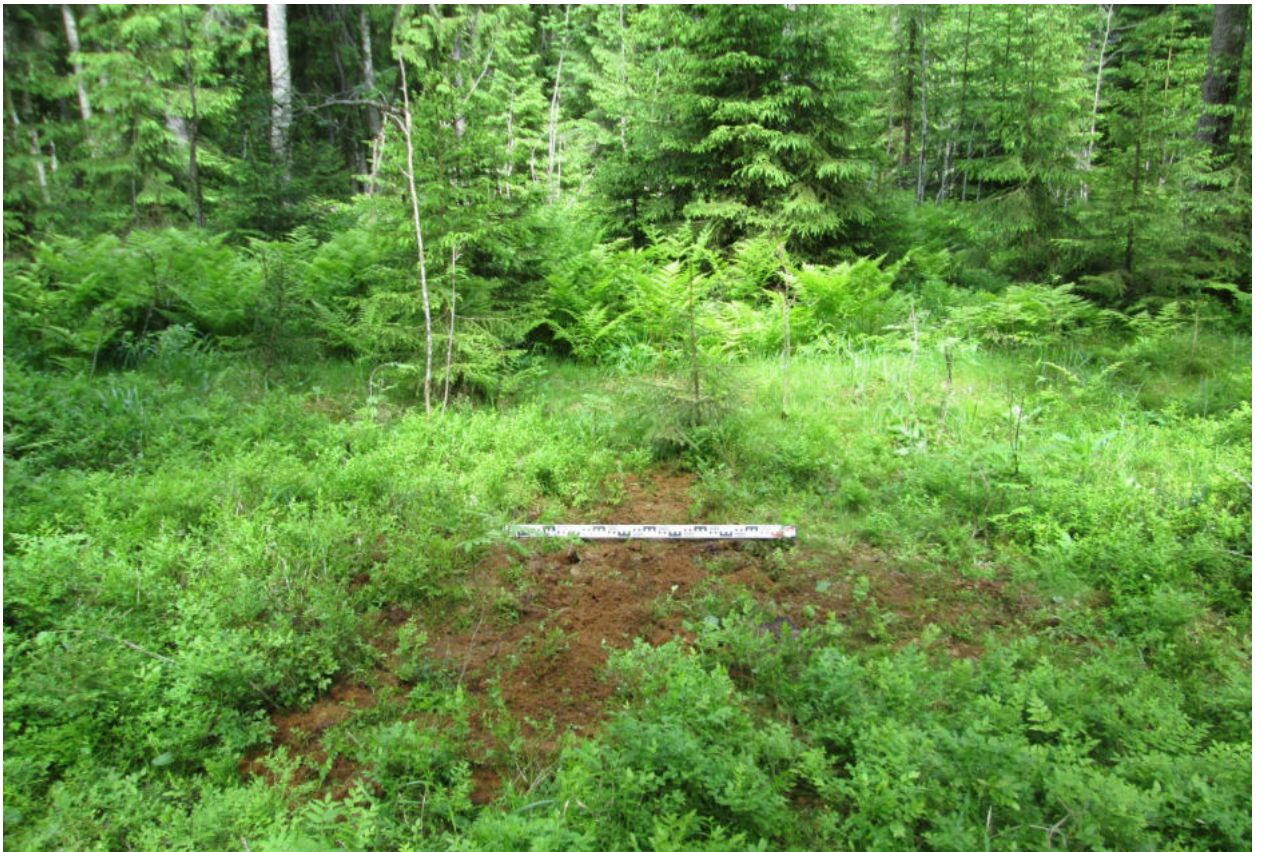
Илл. 155. Ленинградская область, Всеволожский район. Трасса проектируемой реконструкции автомобильной дороги А-181. Шурф 11 после засыпки. Вид с юга. Для масштаба использована нивелировочная рейка длиной 1 м.
