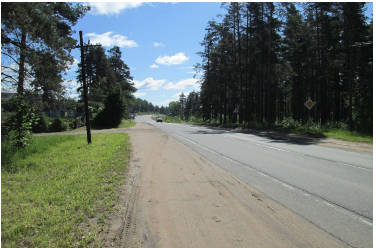
Илл. 114. Ленинградская область, Всеволожский район. Трасса проектируемой реконструкции автомобильной дороги А-181. Точка фотофиксации Ф8. Общий вид с запада.
