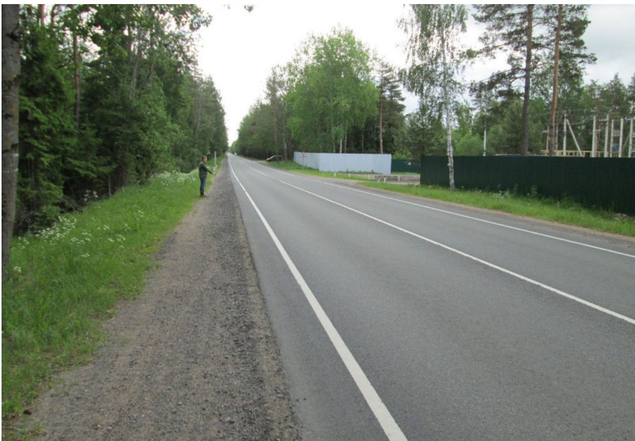
Илл. 34. Ленинградская область, Всеволожский район. Трасса проектируемой реконструкции автомобильной дороги А-181. Точка фотофиксации Ф4. Общий вид с северо-запада.
