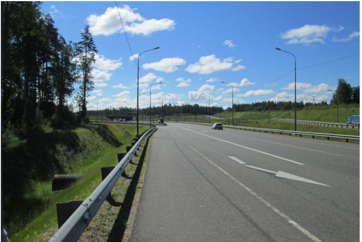
Илл. 111. Ленинградская область, Всеволожский район. Трасса проектируемой реконструкции автомобильной дороги А-181. Точка фотофиксации Ф27. Общий вид с северо-запада.
