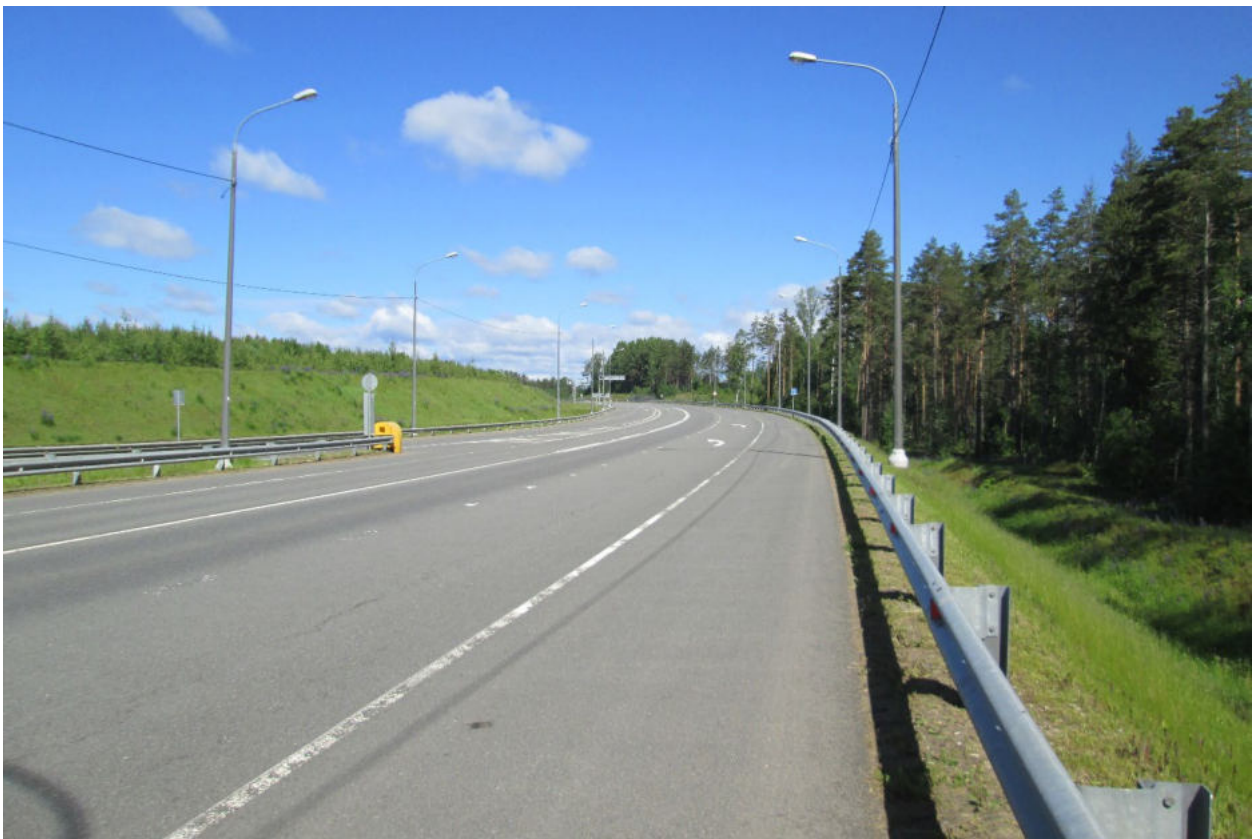
Илл. 112. Ленинградская область, Всеволожский район. Трасса проектируемой реконструкции автомобильной дороги А-181. Точка фотофиксации Ф27. Общий вид с юго-востока.
