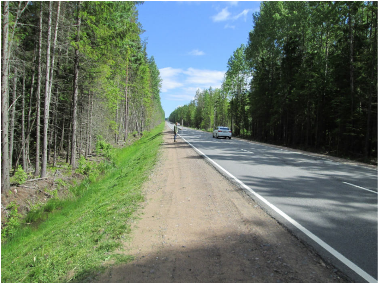
Илл. 163. Ленинградская область, Всеволожский район. Трасса проектируемой реконструкции автомобильной дороги А-181. Точка фотофиксации Ф38. Вид с запада. Для масштаба использована нивелировочная рейка длиной 2 м.
