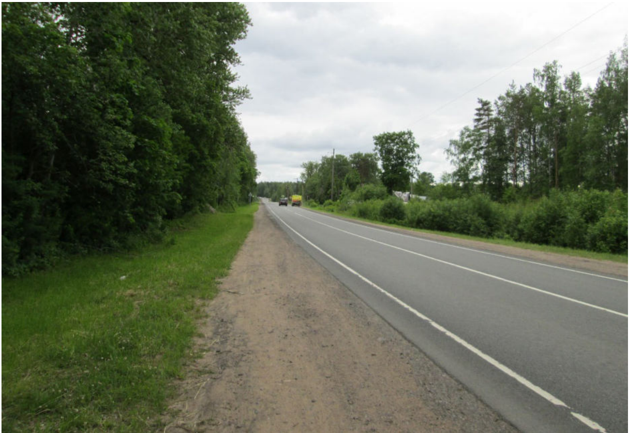
Илл. 99. Ленинградская область, Всеволожский район. Трасса проектируемой реконструкции автомобильной дороги А-181. Точка фотофиксации Ф22. Общий вид с северо-запада.
