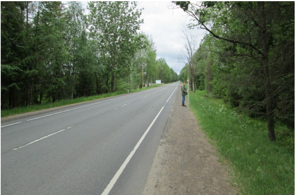
Илл. 26. Ленинградская область, Всеволожский район. Трасса проектируемой реконструкции автомобильной дороги А-181. Точка фотофиксации Ф3. Вид с юго-востока. Для масштаба использована нивелировочная рейка длиной 2 м.
