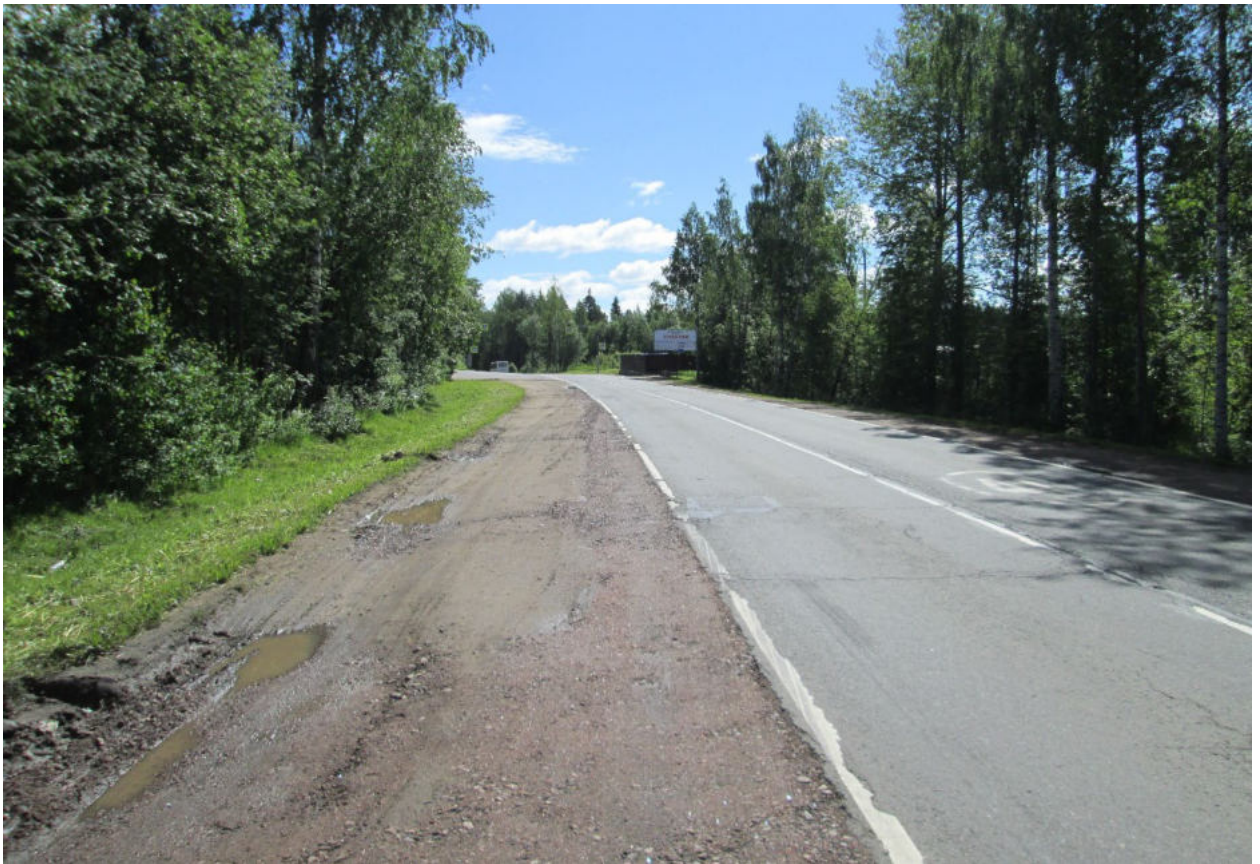
Илл. 121. Ленинградская область, Всеволожский район. Трасса проектируемой реконструкции автомобильной дороги А-181. Точка фотофиксации Ф32. Общий вид с северо-запада.
