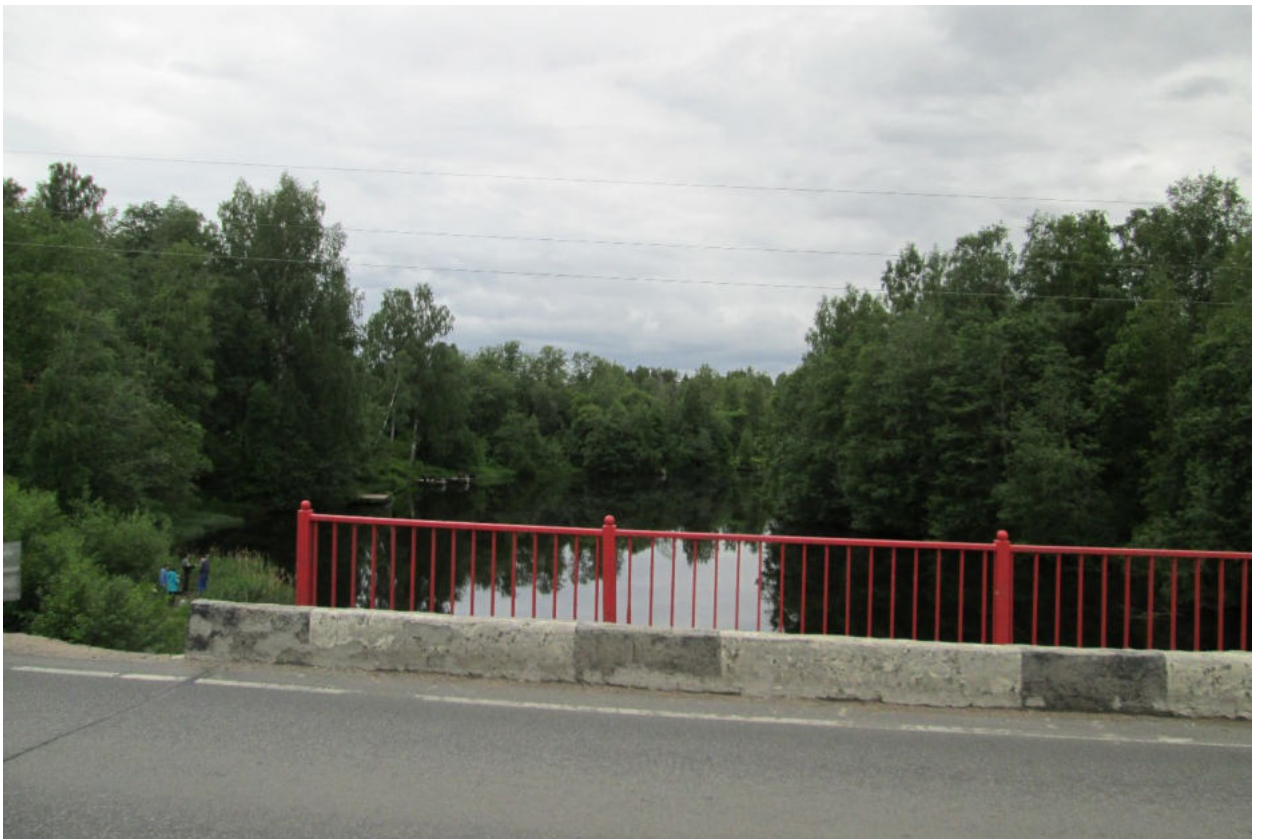
Илл. 98. Ленинградская область, Всеволожский район. Трасса проектируемой реконструкции автомобильной дороги А-181. Точка фотофиксации Ф21. Общий вид с востока.
