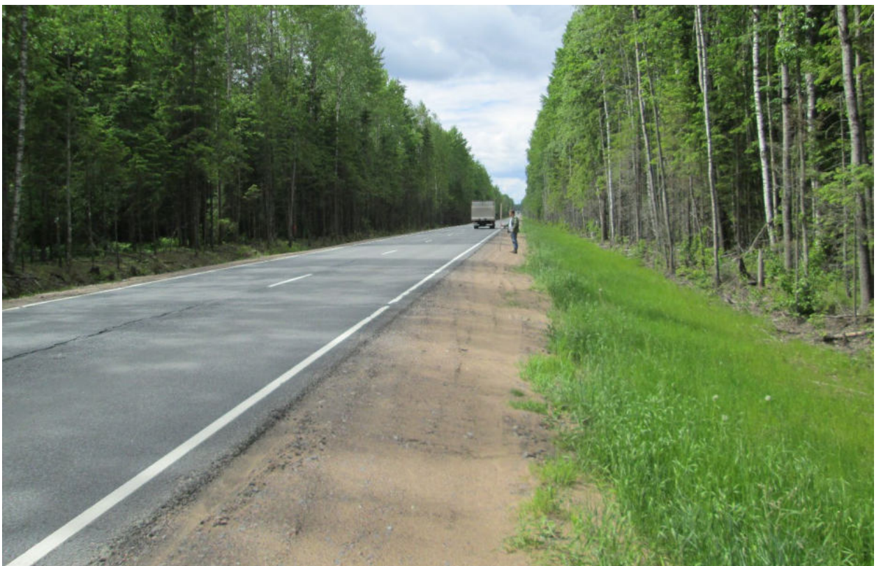
Илл. 156. Ленинградская область, Всеволожский район. Трасса проектируемой реконструкции автомобильной дороги А-181. Точка фотофиксации Ф37. Вид с востока. Для масштаба использована нивелировочная рейка длиной 2 м.
