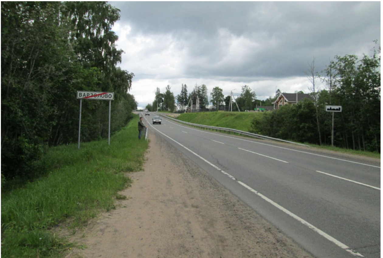
Илл. 61. Ленинградская область, Всеволожский район. Трасса проектируемой реконструкции автомобильной дороги А-181. Точка фотофиксации Ф15. Вид с северо-запада. Для масштаба использована нивелировочная рейка длиной 2 м.
