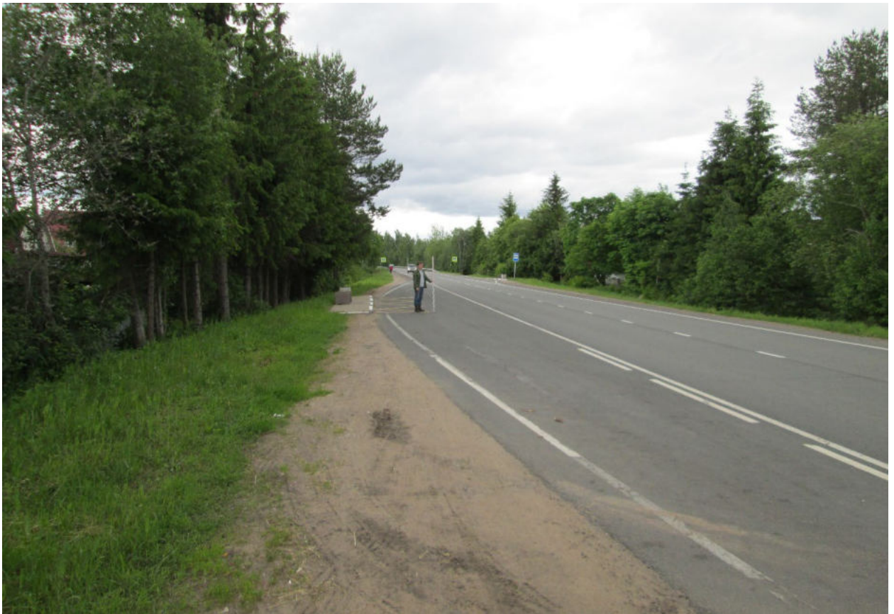
Илл. 65. Ленинградская область, Всеволожский район. Трасса проектируемой реконструкции автомобильной дороги А-181. Точка фотофиксации Ф17. Вид с северо-запада. Для масштаба использована нивелировочная рейка длиной 2 м.
