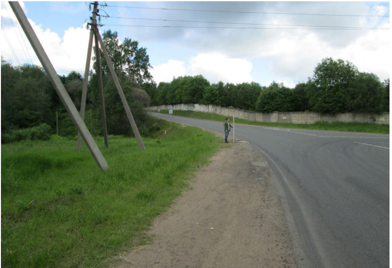
Илл. 58. Ленинградская область, Всеволожский район. Трасса проектируемой реконструкции автомобильной дороги А-181. Точка фотофиксации Ф13. Вид с юго-востока. Для масштаба использована нивелировочная рейка длиной 2 м.
