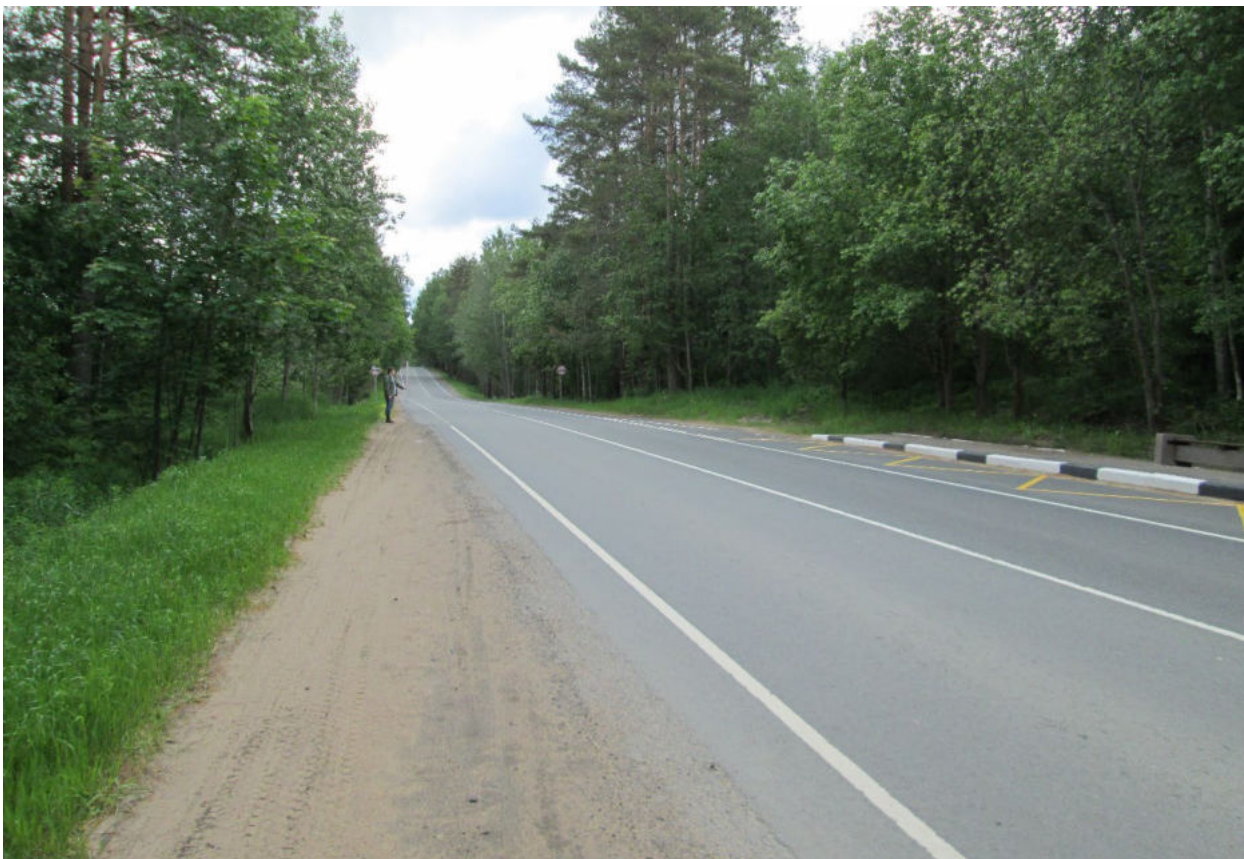
Илл. 49. Ленинградская область, Всеволожский район. Трасса проектируемой реконструкции автомобильной дороги А-181. Точка фотофиксации Ф9. Вид с северо-запада.
