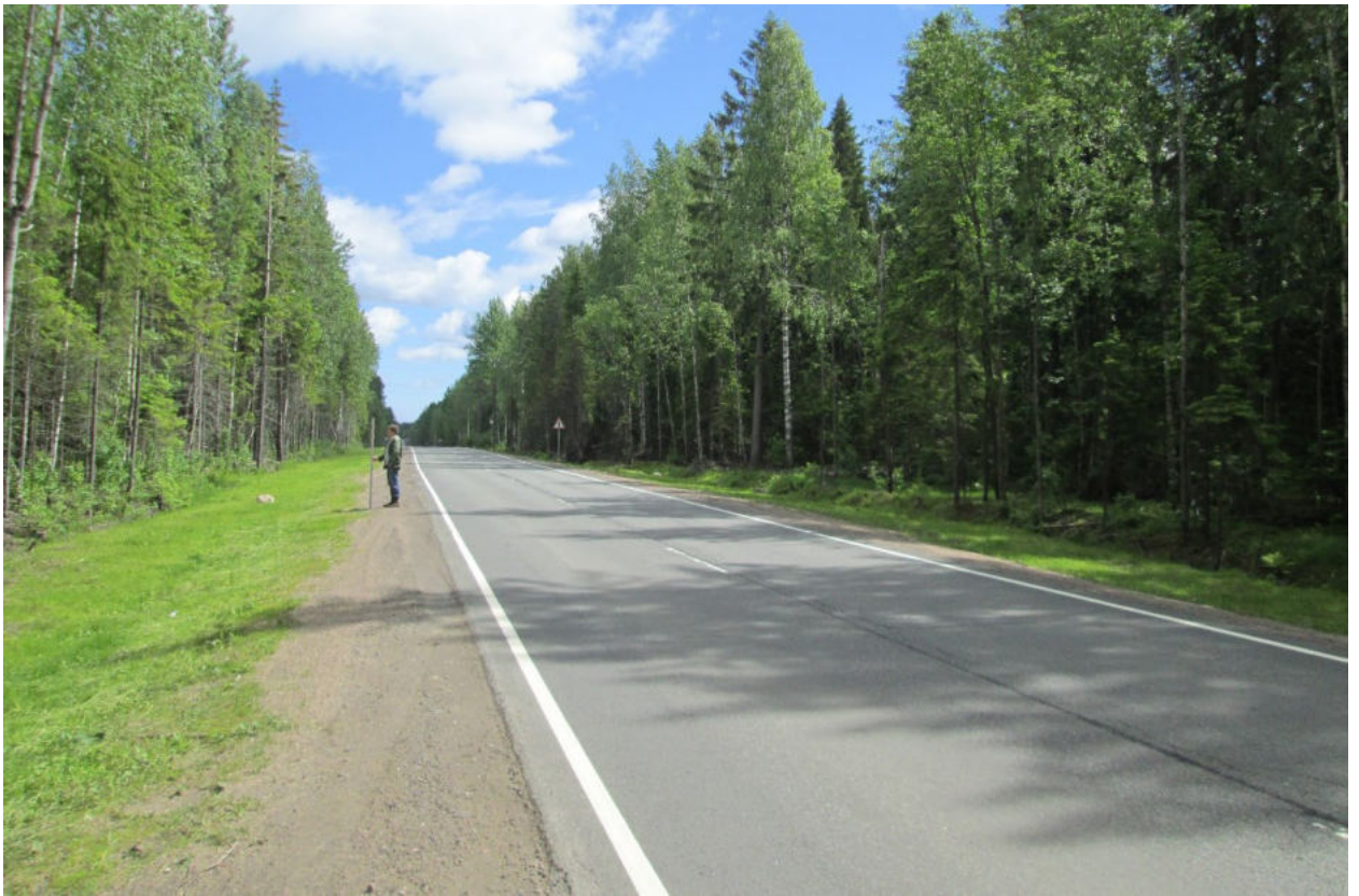
Илл. 143. Ленинградская область, Всеволожский район. Трасса проектируемой реконструкции автомобильной дороги А-181. Точка фотофиксации Ф35. Вид с запада. Для масштаба использована нивелировочная рейка длиной 2 м.
