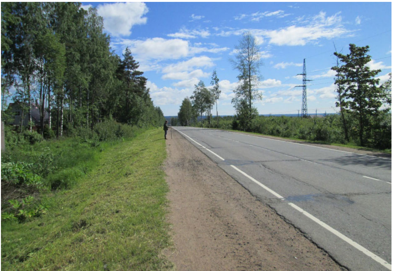
Илл. 120. Ленинградская область, Всеволожский район. Трасса проектируемой реконструкции автомобильной дороги А-181. Точка фотофиксации Ф31. Вид с юго-запада. Для масштаба использована нивелировочная рейка длиной 2 м.
