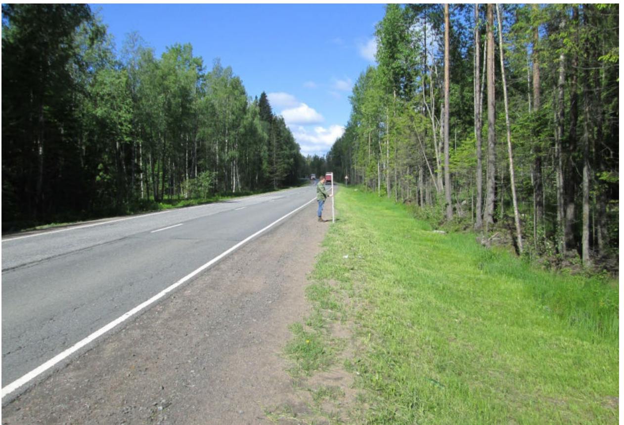
Илл. 128. Ленинградская область, Всеволожский район. Трасса проектируемой реконструкции автомобильной дороги А-181. Точка фотофиксации Ф33. Вид с востока. Для масштаба использована нивелировочная рейка длиной 2 м.
