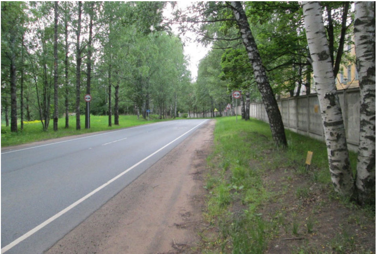
Илл. 55. Ленинградская область, Всеволожский район. Трасса проектируемой реконструкции автомобильной дороги А-181. Точка фотофиксации Ф12. Общий вид с востока.
