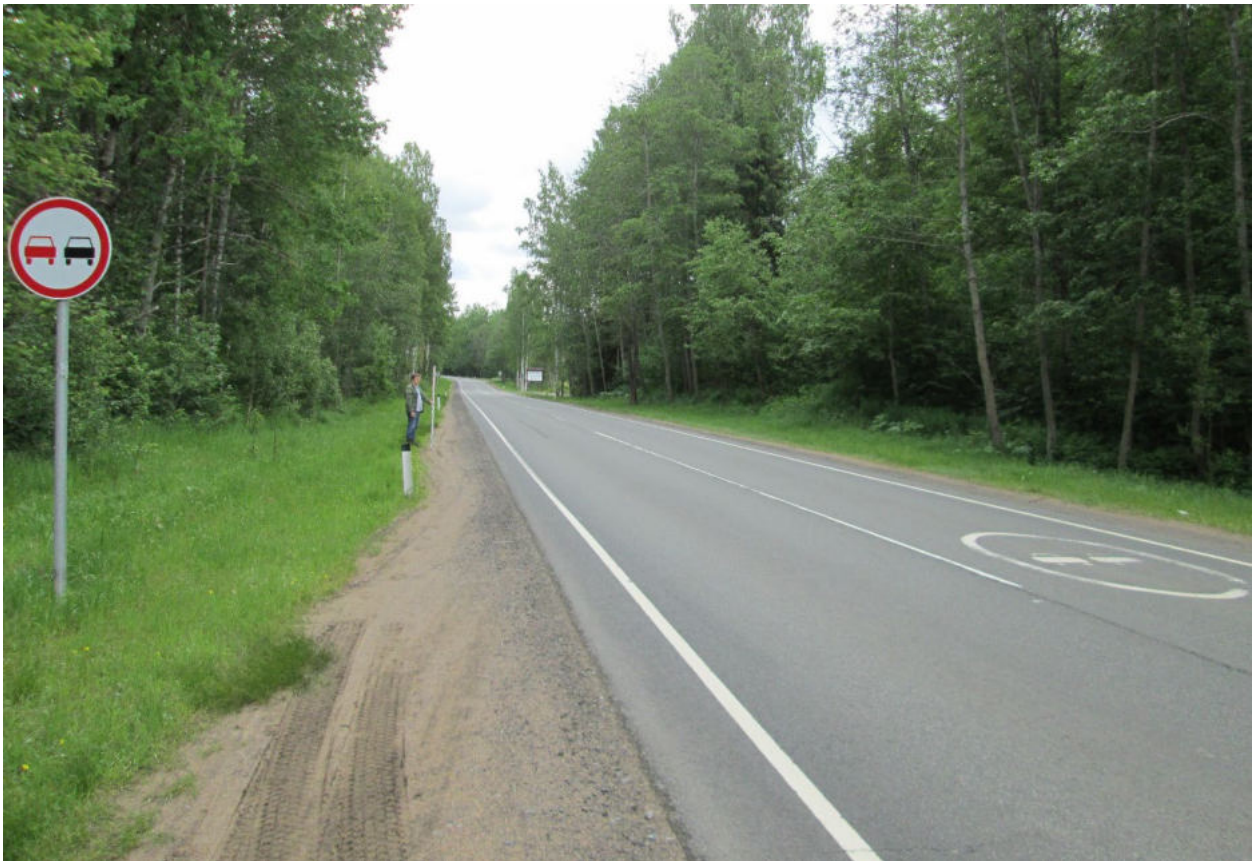
Илл. 41. Ленинградская область, Всеволожский район. Трасса проектируемой реконструкции автомобильной дороги А-181. Точка фотофиксации Ф5. Для масштаба использована нивелировочная рейка длиной 2 м.
