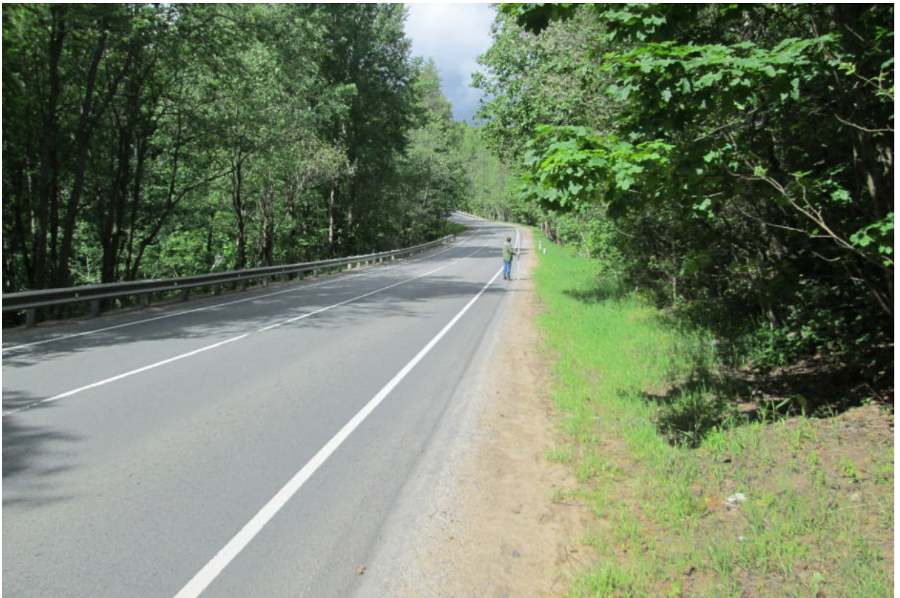
Илл. 51. Ленинградская область, Всеволожский район. Трасса проектируемой реконструкции автомобильной дороги А-181. Точка фотофиксации Ф10. Вид с востока. Для масштаба использована нивелировочная рейка длиной 2 м.
