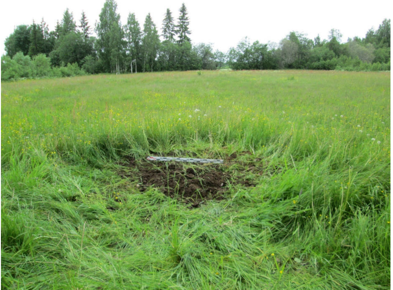
Илл. 22. Ленинградская область, Всеволожский район. Трасса проектируемой реконструкции автомобильной дороги А-181. Шурф 1 после засыпки. Вид с юга. Для масштаба использована нивелировочная рейка длиной 1 м.
