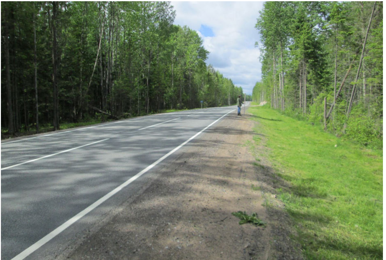
Илл. 135. Ленинградская область, Всеволожский район. Трасса проектируемой реконструкции автомобильной дороги А-181. Точка фотофиксации Ф34. Вид с востока. Для масштаба использована нивелировочная рейка длиной 2 м.
