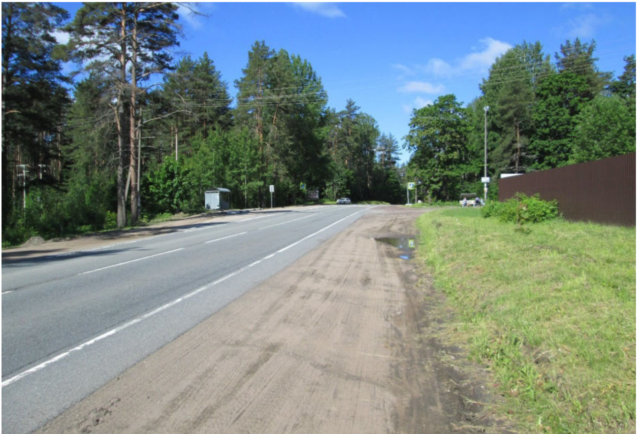
Илл. 113. Ленинградская область, Всеволожский район. Трасса проектируемой реконструкции автомобильной дороги А-181. Точка фотофиксации Ф28. Общий вид с востока.
