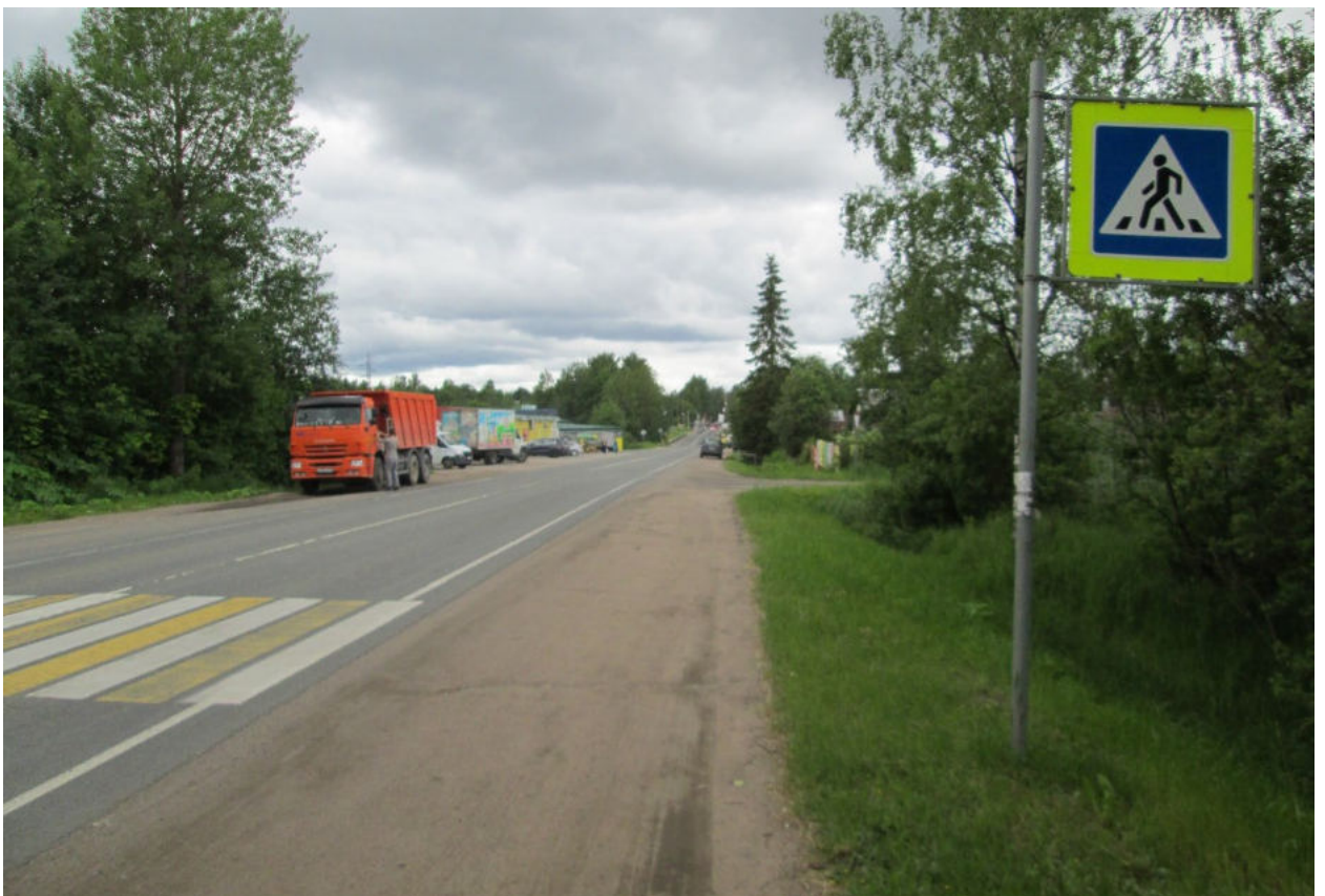
Илл. 64. Ленинградская область, Всеволожский район. Трасса проектируемой реконструкции автомобильной дороги А-181. Точка фотофиксации Ф16. Общий вид с юго-запада.
