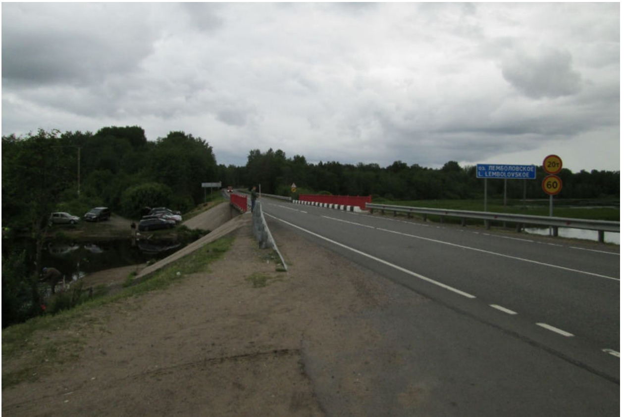
Илл. 105. Ленинградская область, Всеволожский район. Трасса проектируемой реконструкции автомобильной дороги А-181. Точка фотофиксации Ф25. Вид с северо-востока. Для масштаба использована нивелировочная рейка длиной 2 м.
