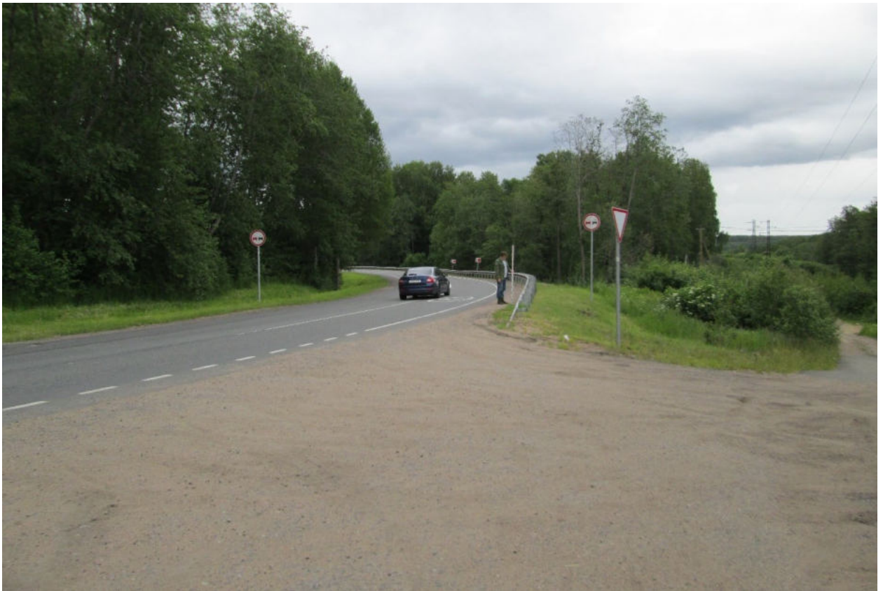
Илл. 109. Ленинградская область, Всеволожский район. Трасса проектируемой реконструкции автомобильной дороги А-181. Точка фотофиксации Ф26. Вид с северо-запада. Для масштаба использована нивелировочная рейка длиной 2 м.
