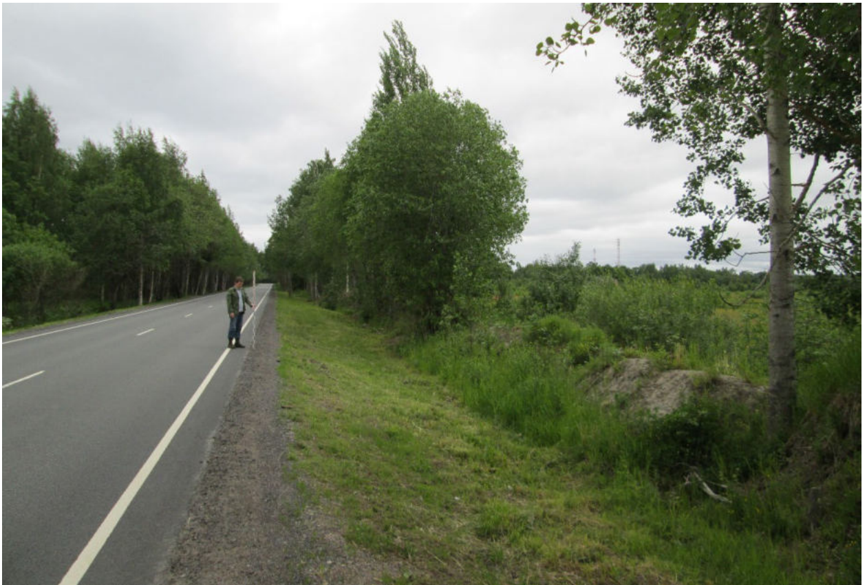
Илл. 17. Ленинградская область, Всеволожский район. Трасса проектируемой реконструкции автомобильной дороги А-181. Точка фотофиксации Ф1. Вид с востока. Для масштаба использована рейка длиной 2 м.
