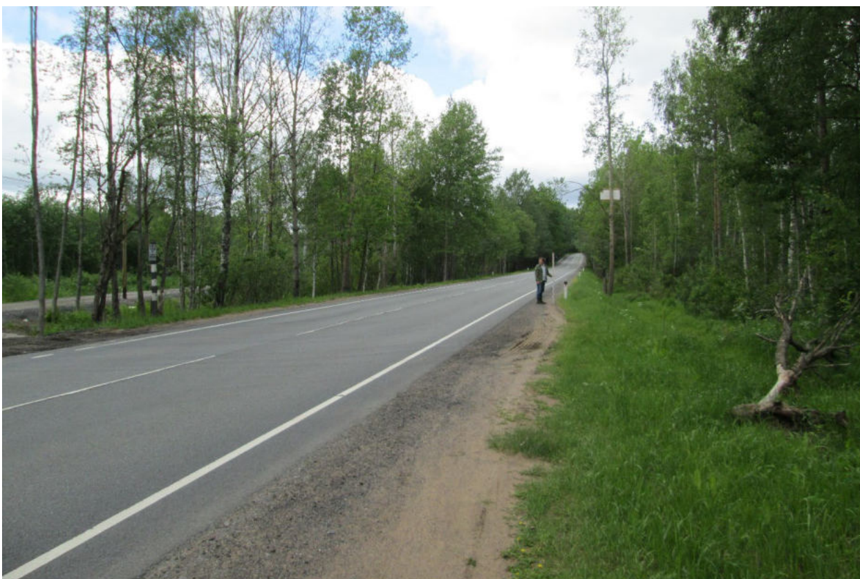
Илл. 40. Ленинградская область, Всеволожский район. Трасса проектируемой реконструкции автомобильной дороги А-181. Точка фотофиксации Ф5. Для масштаба использована нивелировочная рейка длиной 2 м.
