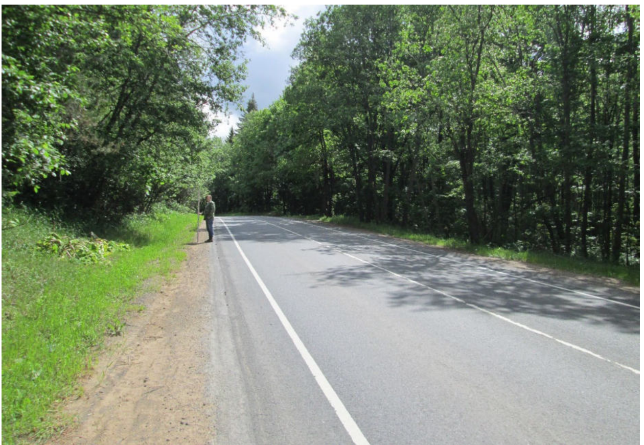
Илл. 52. Ленинградская область, Всеволожский район. Трасса проектируемой реконструкции автомобильной дороги А-181. Точка фотофиксации Ф10. Вид с северо-запада. Для масштаба использована нивелировочная рейка длиной 2 м.
