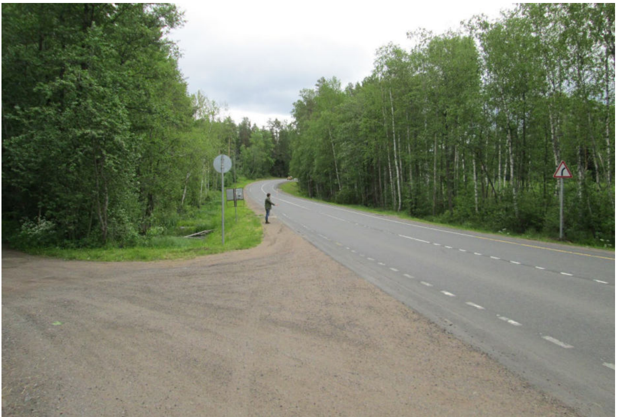
Илл. 104. Ленинградская область, Всеволожский район. Трасса проектируемой реконструкции автомобильной дороги А-181. Точка фотофиксации Ф24. Вид с юго-запада. Для масштаба использована нивелировочная рейка длиной 2 м.
