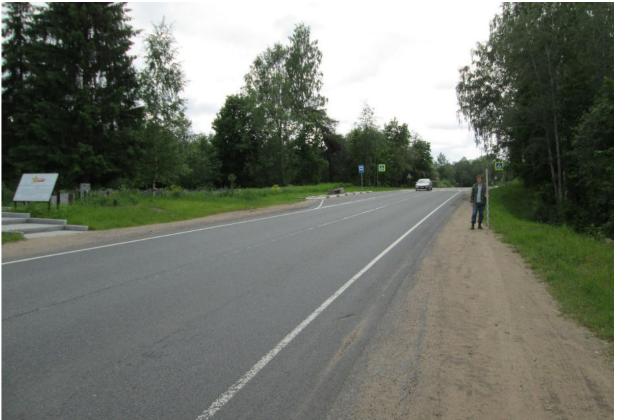
Илл. 57. Ленинградская область, Всеволожский район. Трасса проектируемой реконструкции автомобильной дороги А-181. Точка фотофиксации Ф13. Вид с северо-запада. Для масштаба использована нивелировочная рейка длиной 2 м.
