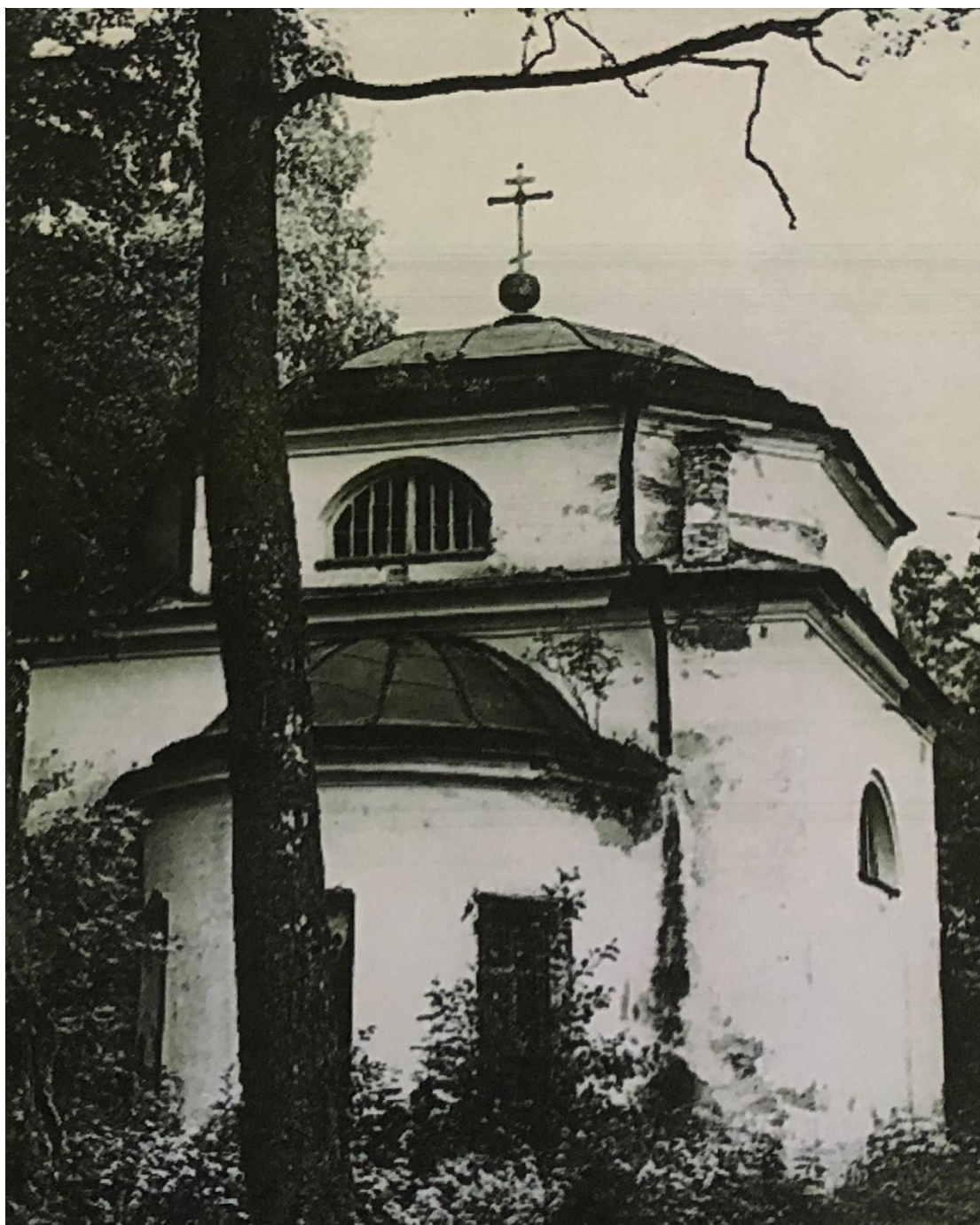
39. Восточный фасад церкви Вознесения Господня. Вид на северо-северо-восток. 1950-е гг. Инвентаризация объекта культурного наследия федерального значения «Церковь Вознесения», 1781 г., расположенного по адресу: Ленинградская область, Гатчинский муниципальный район, Рождественское сельское поселение, с. Рождествено, Большой пр., д. 118 а. Шифр: ИНВ-25-2019.
