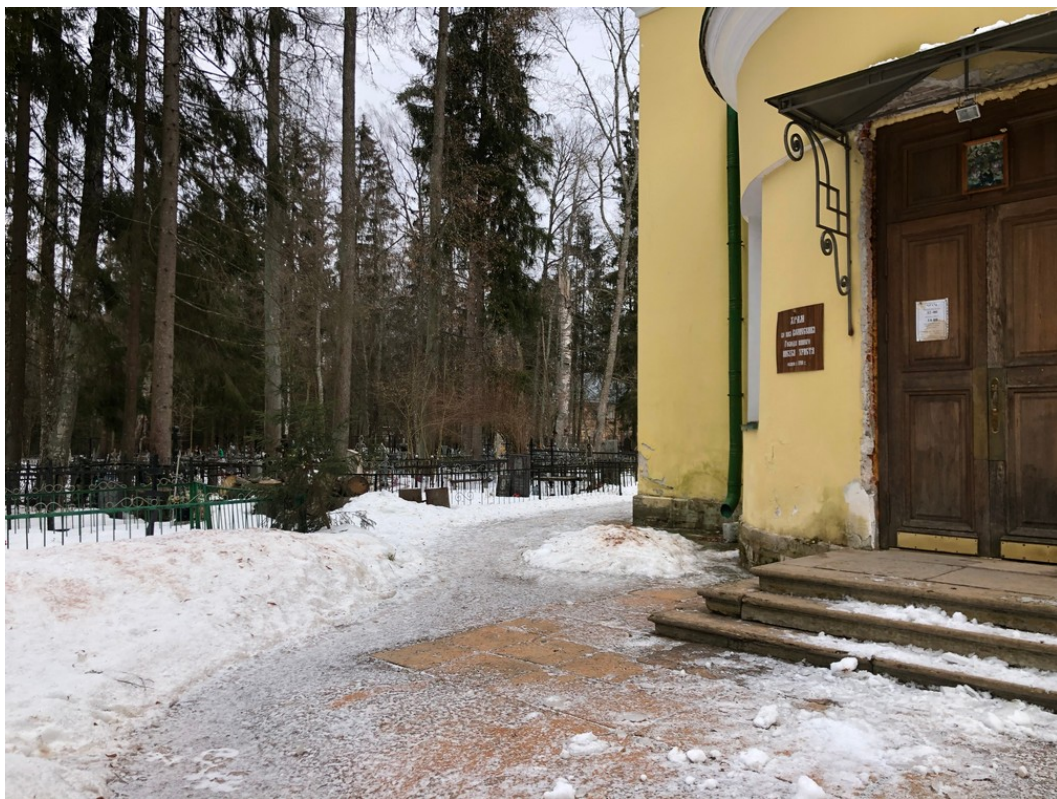
26. Село Рождествено. Вид на церковь Вознесения Господня в сторону северо-востока. Фрагмент. 15.03.2021. Фото:Петухова Н.М.
