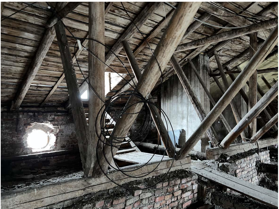
Фото 19. Чердак. Помещение в юго-восточной половине здания. Крепление электропроводки к деревянным конструкциям стропильной системы. Дата съемки: 11.04.2022 г. Автор: Куваева Ю.П.
