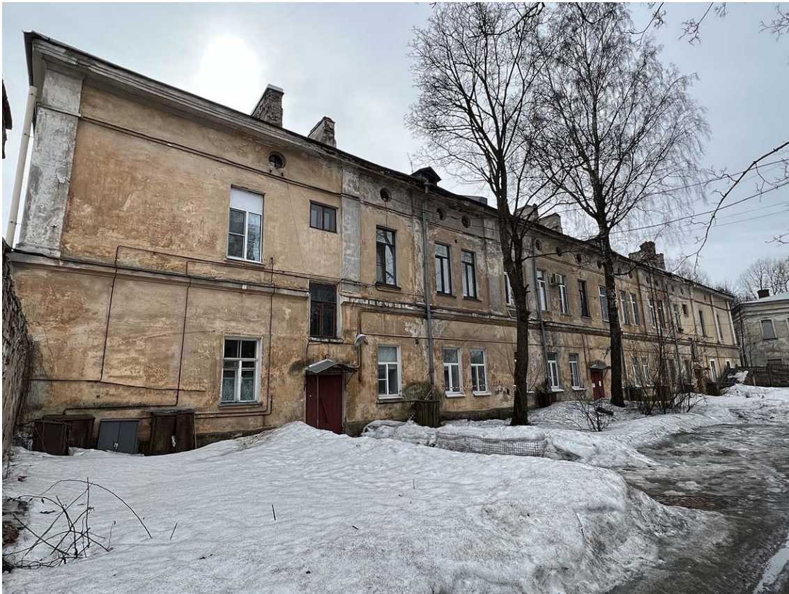
Фото 3. Общий вид дворовых фасадов с северо-востока. Дата съемки: 11.04.2022 г. Автор: Куваева Ю.П.
