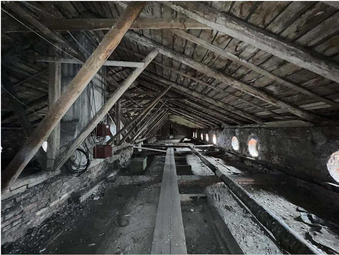
Фото 18. Чердак. Общий вид помещения в юго-восточной половине здания. Фото с северо-запада. Дата съемки: 11.04.2022 г. Автор: Куваева Ю.П.
