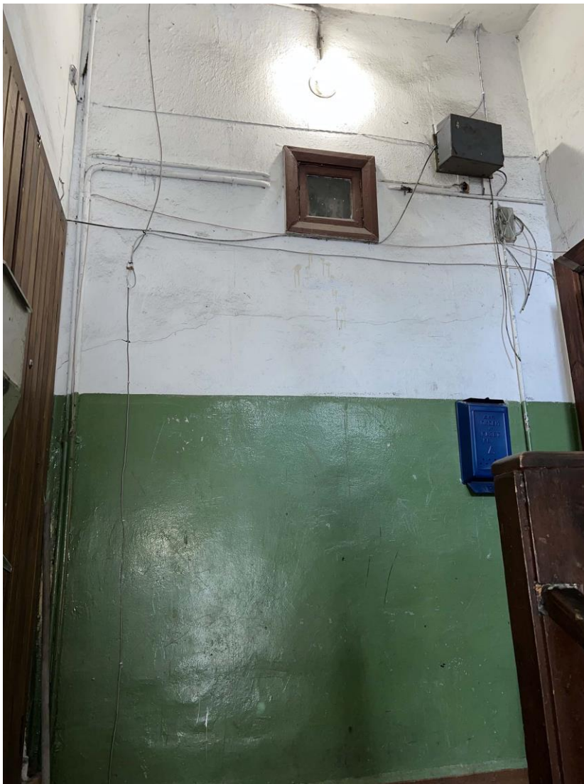
Фото 8. Лестничная клетка. 1-ый подъезд. Крепление электропроводки к стене 2-го этажа. Дата съемки: 11.04.2022 г. Автор: Куваева Ю.П.
