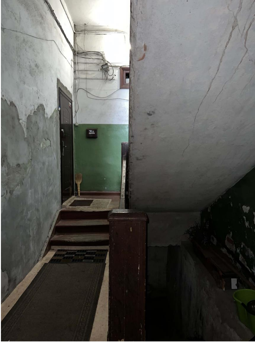
Фото 4. Лестничная клетка. 1-ый подъезд. Общий вид помещения 1-го этажа. Дата съемки: 11.04.2022 г. Автор: Куваева Ю.П.
