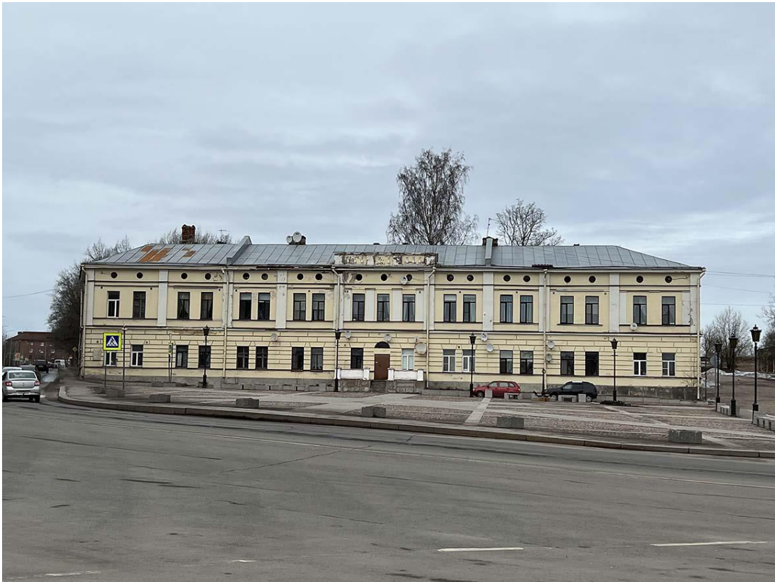
Фото 1. Общий вид здания с юга. Дата съемки: 11.04.2022 г. Автор: Куваева Ю.П.
