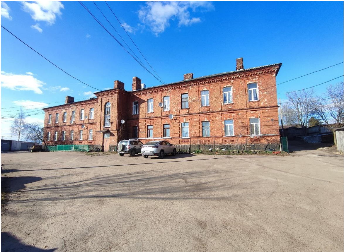
Фото 1. Общий вид здания с юга. Дата съемки: 11.04.2022 г. Автор: Глинская Н.Б.
