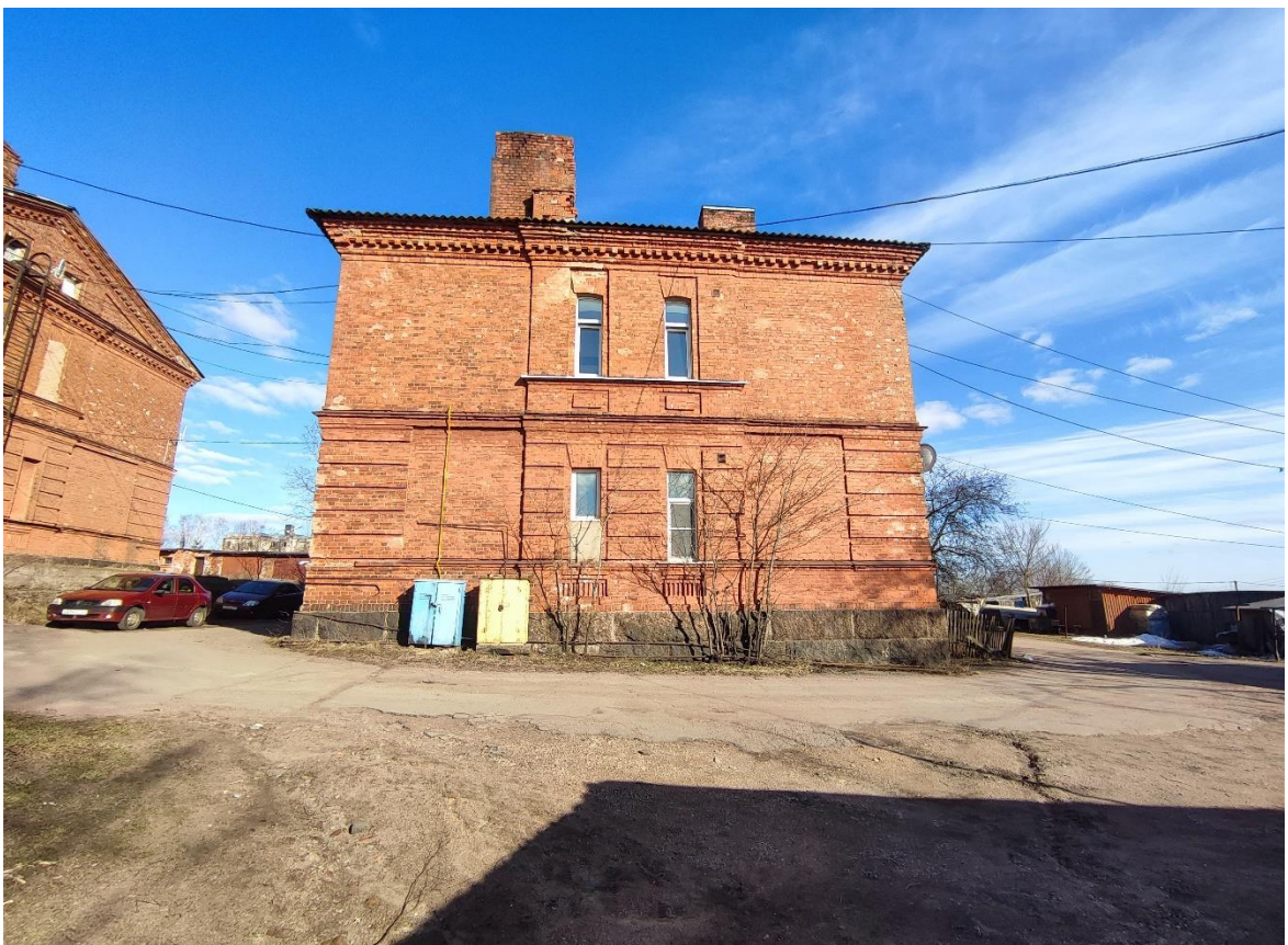
Фото 2. Общий вид здания с северо-запада. Дата съемки: 11.04.2022 г. Автор: Глинская Н.Б.
