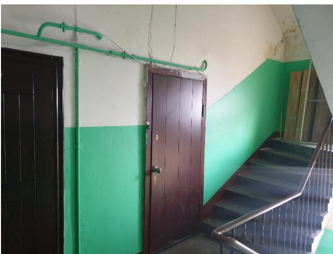
14. «Жилой дом М. Шушина», Ленинградская область, Выборгский район, г. Выборг, ул. Крепостная, д.12. Подъезд №2. Фрагмент. Фото 20.08.2022г.
