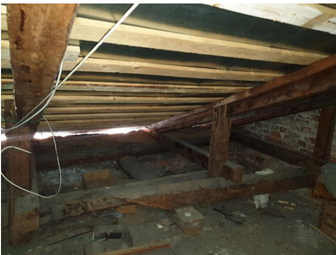
38. «Жилой дом М. Шушина», Ленинградская область, Выборгский район, г. Выборг, ул. Крепостная, д.12. Чердак. Общий вид. Фото 20.08.2022г.
