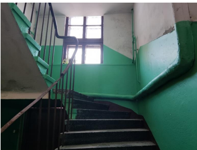
29. «Жилой дом М. Шушина», Ленинградская область, Выборгский район, г. Выборг, ул. Крепостная, д.12. Подъезд №6. Фрагмент. Фото 20.08.2022г.
