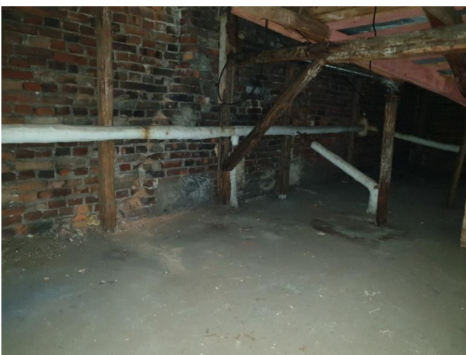
41. «Жилой дом М. Шушина», Ленинградская область, Выборгский район, г. Выборг, ул. Крепостная, д.12. Чердак. Общий вид. Фото 20.08.2022г.
