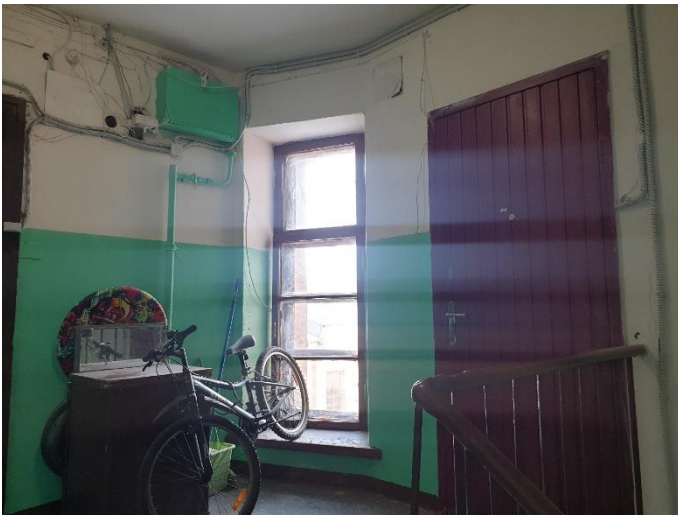
9. «Жилой дом М. Шушина», Ленинградская область, Выборгский район, г. Выборг, ул. Крепостная, д.12. Подъезд №1. Фрагмент. Фото 20.08.2022г.
