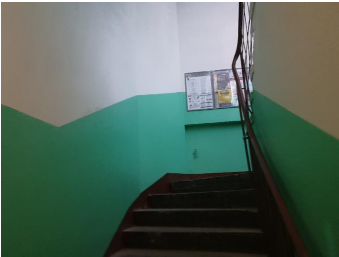
6. «Жилой дом М. Шушина», Ленинградская область, Выборгский район, г. Выборг, ул. Крепостная, д.12. Подъезд №1. Фрагмент. Фото 20.08.2022г.
