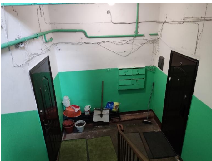
26. «Жилой дом М. Шушина», Ленинградская область, Выборгский район, г. Выборг, ул. Крепостная, д.12. Подъезд №5. Фрагмент. Фото 20.08.2022г.
