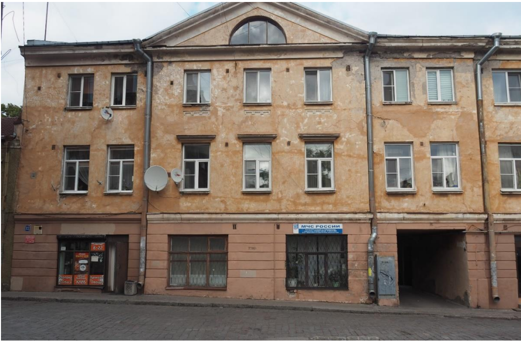
1. «Жилой дом М. Шушина», Ленинградская область, Выборгский район, г. Выборг, ул. Крепостная, д.12. Юго-западный фасад. Общий вид. Фото 20.08.2022г.
