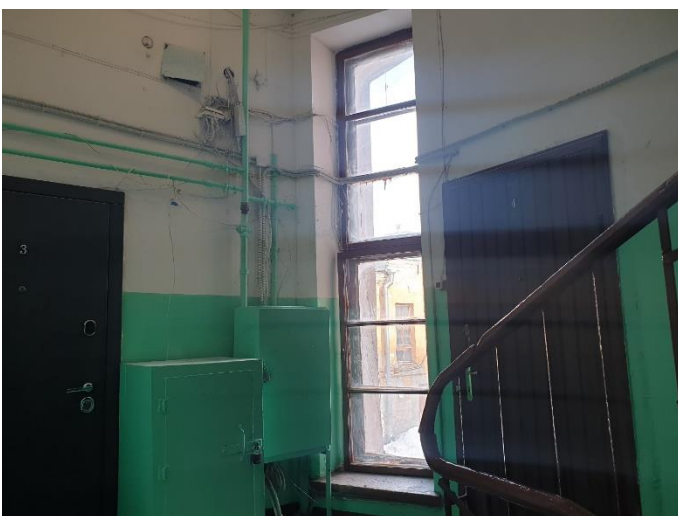
8. «Жилой дом М. Шушина», Ленинградская область, Выборгский район, г. Выборг, ул. Крепостная, д.12. Подъезд №1. Фрагмент. Фото 20.08.2022г.
