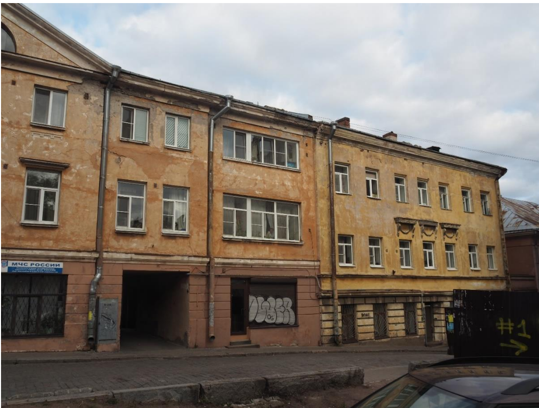
2. «Жилой дом М. Шушина», Ленинградская область, Выборгский район, г. Выборг, ул. Крепостная, д.12. Юго-западный фасад. Общий вид. Фото 20.08.2022г.
