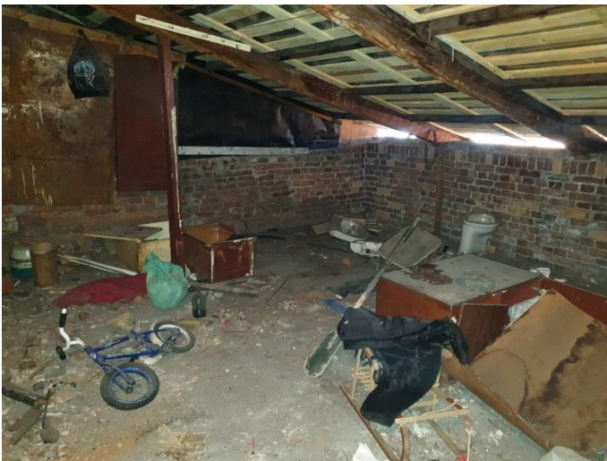
40. «Жилой дом М. Шушина», Ленинградская область, Выборгский район, г. Выборг, ул. Крепостная, д.12. Чердак. Общий вид. Фото 20.08.2022г.
