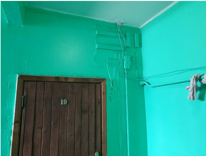
19. «Жилой дом М. Шушина», Ленинградская область, Выборгский район, г. Выборг, ул. Крепостная, д.12. Подъезд №3. Фрагмент. Фото 20.08.2022г.
