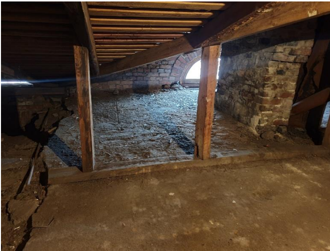
34. «Жилой дом М. Шушина», Ленинградская область, Выборгский район, г. Выборг, ул. Крепостная, д.12. Чердак. Общий вид. Фото 20.08.2022г.
