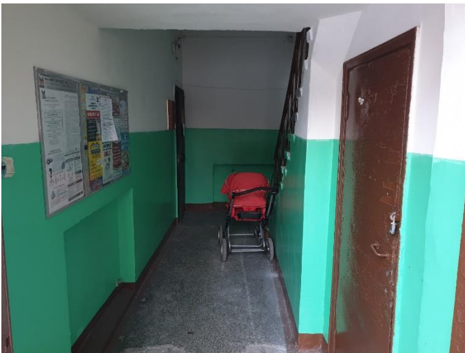
10. «Жилой дом М. Шушина», Ленинградская область, Выборгский район, г. Выборг, ул. Крепостная, д.12. Подъезд №2. Общий вид. Фото 20.08.2022г.
