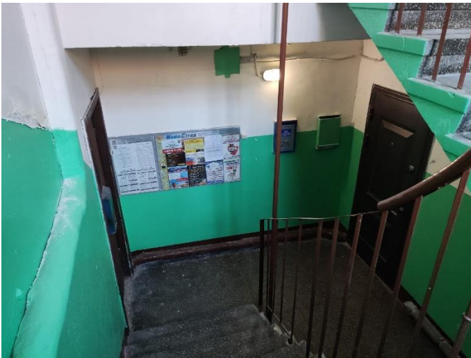
30. «Жилой дом М. Шушина», Ленинградская область, Выборгский район, г. Выборг, ул. Крепостная, д.12. Подъезд №6. Фрагмент. Фото 20.08.2022г.
