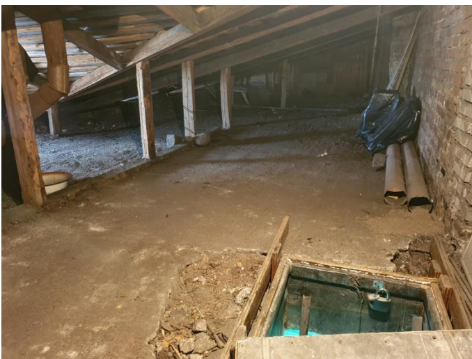
35. «Жилой дом М. Шушина», Ленинградская область, Выборгский район, г. Выборг, ул. Крепостная, д.12. Чердак. Общий вид. Фото 20.08.2022г.
