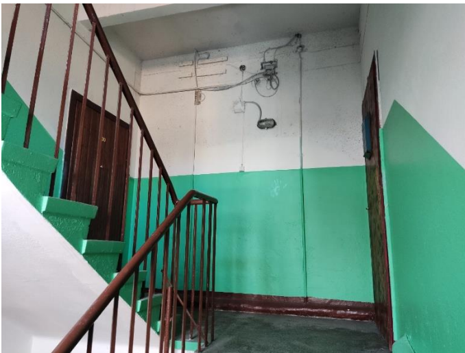
31. «Жилой дом М. Шушина», Ленинградская область, Выборгский район, г. Выборг, ул. Крепостная, д.12. Подъезд №6. Фрагмент. Фото 20.08.2022г.
