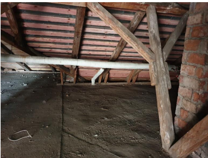
44. «Жилой дом М. Шушина», Ленинградская область, Выборгский район, г. Выборг, ул. Крепостная, д.12. Чердак. Общий вид. Фото 20.08.2022г.
