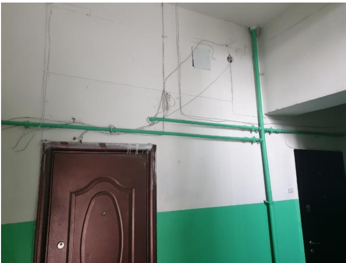
13. «Жилой дом М. Шушина», Ленинградская область, Выборгский район, г. Выборг, ул. Крепостная, д.12. Подъезд №2. Фрагмент. Фото 20.08.2022г.
