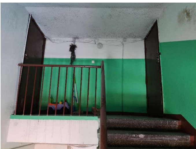
32. «Жилой дом М. Шушина», Ленинградская область, Выборгский район, г. Выборг, ул. Крепостная, д.12. Подъезд №6. Фрагмент. Фото 20.08.2022г.
