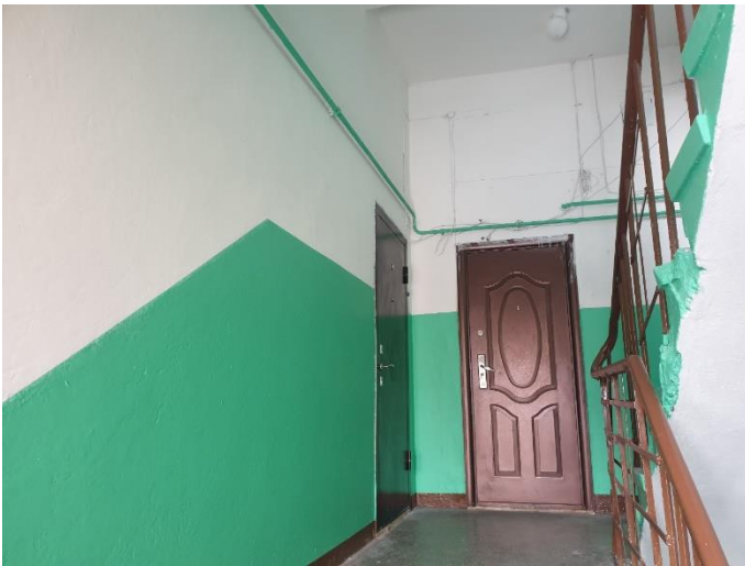
12. «Жилой дом М. Шушина», Ленинградская область, Выборгский район, г. Выборг, ул. Крепостная, д.12. Подъезд №2. Фрагмент. Фото 20.08.2022г.
