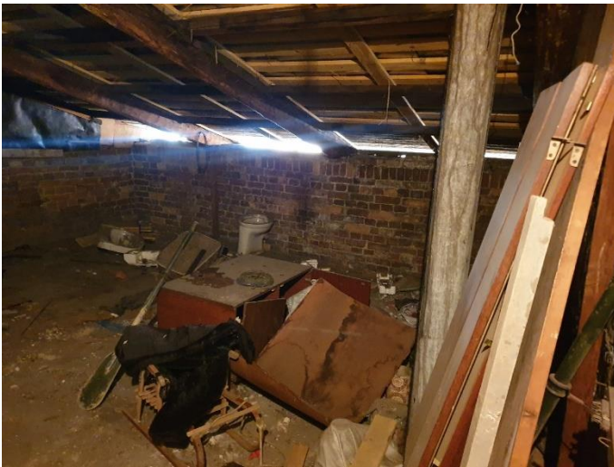
39. «Жилой дом М. Шушина», Ленинградская область, Выборгский район, г. Выборг, ул. Крепостная, д.12. Чердак. Общий вид. Фото 20.08.2022г.
