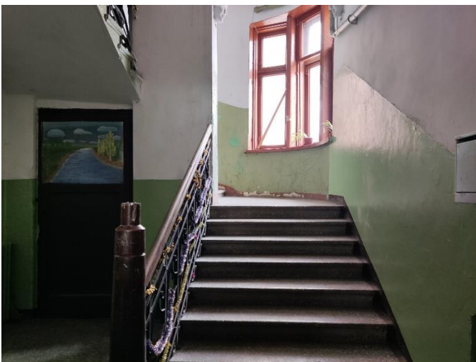
5. «Жилой дом с флигелем», Ленинградская область, Выборгский район, г. Выборг, ул. Садовая д.3,3а. Подъезд №1. Фрагмент. Фото 20.08.2022г.
