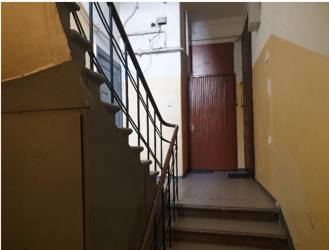
13. «Жилой дом с флигелем», Ленинградская область, Выборгский район, г. Выборг, ул. Садовая д.3,3а. Подъезд №2. Фрагмент. Фото 20.08.2022г.
