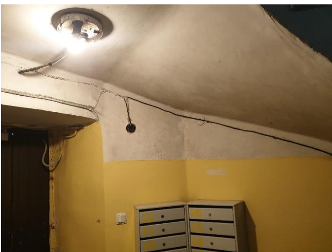
14. «Жилой дом с флигелем», Ленинградская область, Выборгский район, г. Выборг, ул. Садовая д.3,3а. Подъезд №2. Фрагмент. Фото 20.08.2022г.
