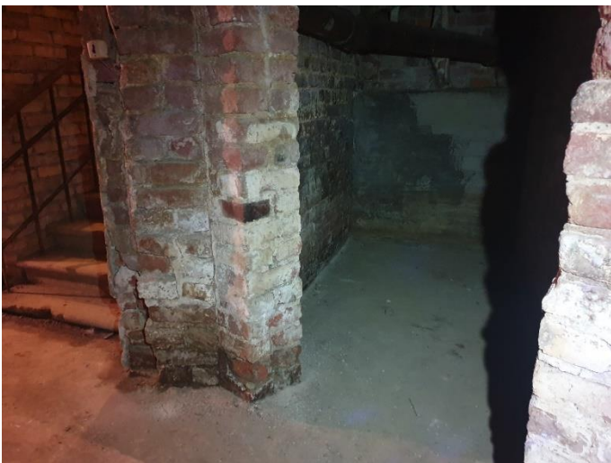
30. «Жилой дом с флигелем», Ленинградская область, Выборгский район, г. Выборг, ул. Садовая д.3,3а. Подвал. Фрагмент. Фото 20.08.2022г.
