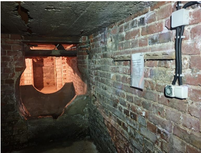
28. «Жилой дом с флигелем», Ленинградская область, Выборгский район, г. Выборг, ул. Садовая д.3,3а. Подвал. Фрагмент. Фото 20.08.2022г.
