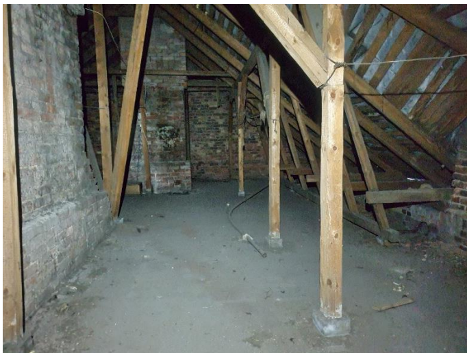
42. «Жилой дом с флигелем», Ленинградская область, Выборгский район, г. Выборг, ул. Садовая д.3,3а. Чердак. Фрагмент. Фото 20.08.2022г.
