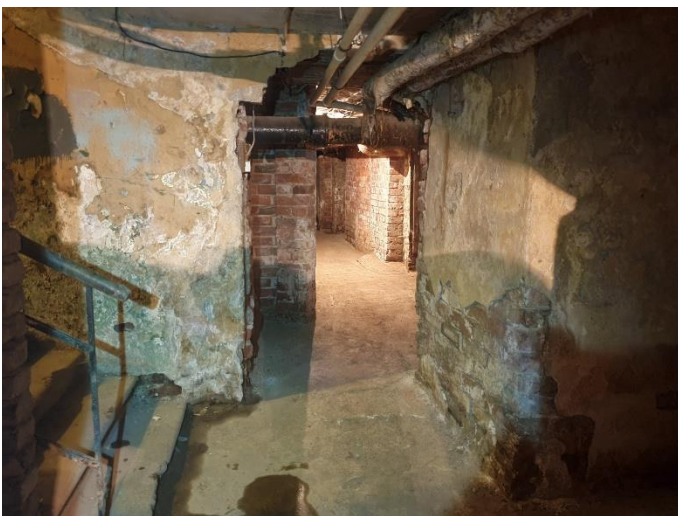
29. «Жилой дом с флигелем», Ленинградская область, Выборгский район, г. Выборг, ул. Садовая д.3,3а. Подвал. Фрагмент. Фото 20.08.2022г.
