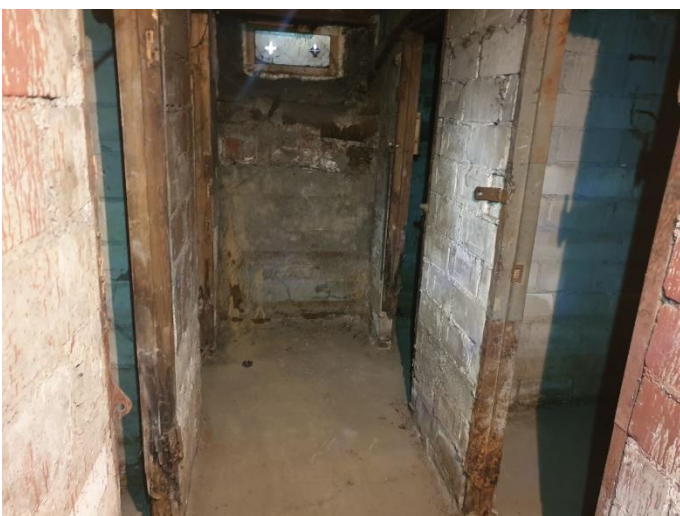
32. «Жилой дом с флигелем», Ленинградская область, Выборгский район, г. Выборг, ул. Садовая д.3,3а. Подвал. Фрагмент. Фото 20.08.2022г.
