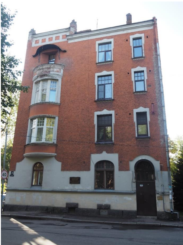
2. «Жилой дом с флигелем», Ленинградская область, Выборгский район, г. Выборг, ул. Садовая д.3,3а. Северо-восточный фасад. Общий вид. Фото 20.08.2022г.
