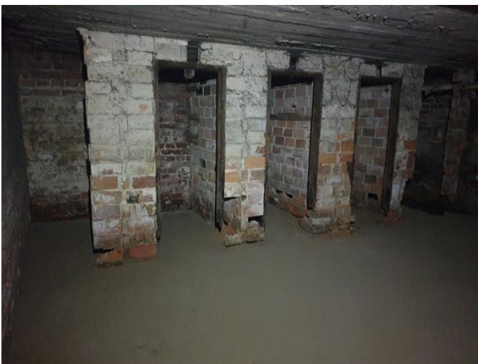
38. «Жилой дом с флигелем», Ленинградская область, Выборгский район, г. Выборг, ул. Садовая д.3,3а. Подвал. Фрагмент. Фото 20.08.2022г.
