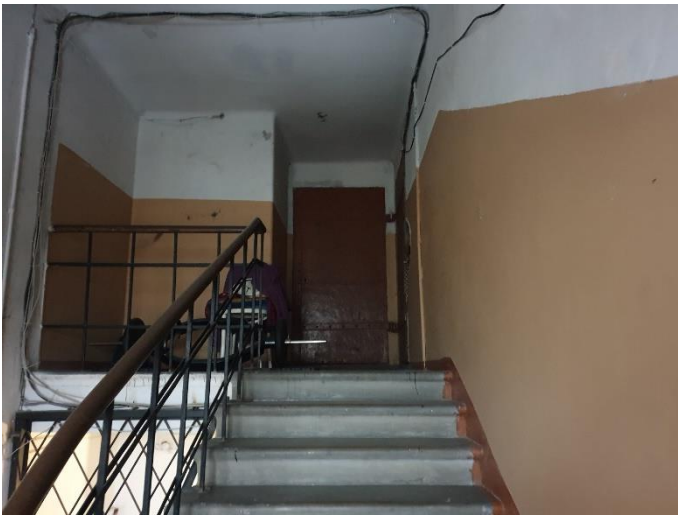
19. «Жилой дом с флигелем», Ленинградская область, Выборгский район, г. Выборг, ул. Садовая д.3,3а. Подъезд №2. Фрагмент. Фото 20.08.2022г.
