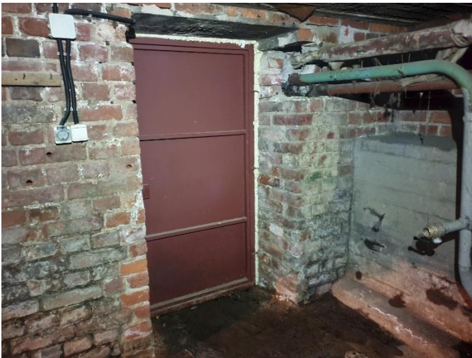
27. «Жилой дом с флигелем», Ленинградская область, Выборгский район, г. Выборг, ул. Садовая д.3,3а. Подвал. Фрагмент. Фото 20.08.2022г.
