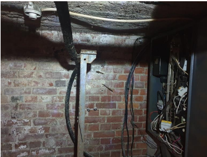
33. «Жилой дом с флигелем», Ленинградская область, Выборгский район, г. Выборг, ул. Садовая д.3,3а. Подвал. Фрагмент. Фото 20.08.2022г.
