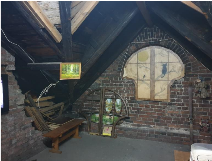
49. «Жилой дом с флигелем», Ленинградская область, Выборгский район, г. Выборг, ул. Садовая д.3,3а. Чердак. Фрагмент. Фото 20.08.2022г.
