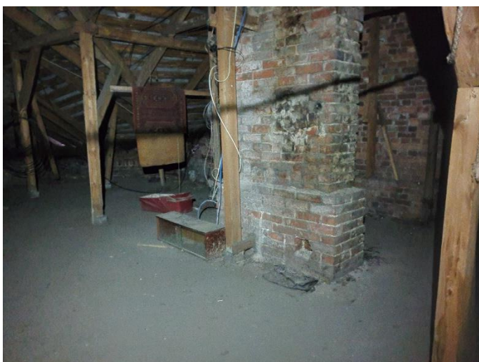
43. «Жилой дом с флигелем», Ленинградская область, Выборгский район, г. Выборг, ул. Садовая д.3,3а. Чердак. Общий вид. Фото 20.08.2022г.
