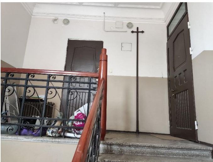
11. «Жилой дом с флигелем», Ленинградская область, Выборгский район, г. Выборг, ул. Садовая д.3,3а. Подъезд №1. Фрагмент. Фото 20.08.2022г.
