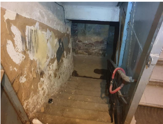
20. «Жилой дом с флигелем», Ленинградская область, Выборгский район, г. Выборг, ул. Садовая д.3,3а. Подвал. Фрагмент. Фото 20.08.2022г.
