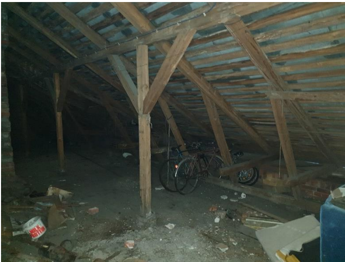
40. «Жилой дом с флигелем», Ленинградская область, Выборгский район, г. Выборг, ул. Садовая д.3,3а. Чердак. Общий вид. Фото 20.08.2022г.
