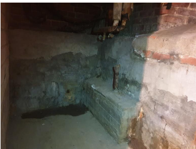
23. «Жилой дом с флигелем», Ленинградская область, Выборгский район, г. Выборг, ул. Садовая д.3,3а. Подвал. Фрагмент. Фото 20.08.2022г.
