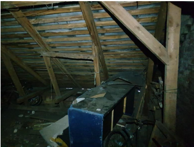
39. «Жилой дом с флигелем», Ленинградская область, Выборгский район, г. Выборг, ул. Садовая д.3,3а. Чердак. Фрагмент. Фото 20.08.2022г.
