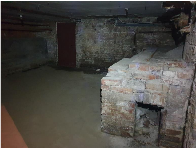
34. «Жилой дом с флигелем», Ленинградская область, Выборгский район, г. Выборг, ул. Садовая д.3,3а. Подвал. Общий вид. Фото 20.08.2022г.
