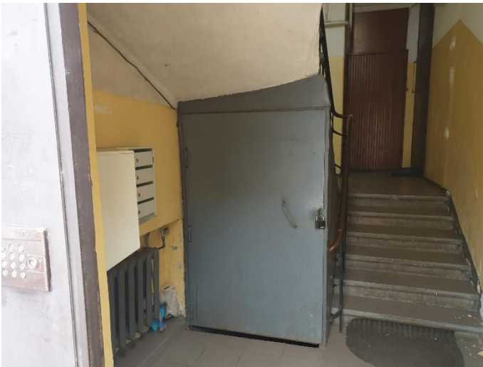
12. «Жилой дом с флигелем», Ленинградская область, Выборгский район, г. Выборг, ул. Садовая д.3,3а. Подъезд №2. Общий вид. Фото 20.08.2022г.
