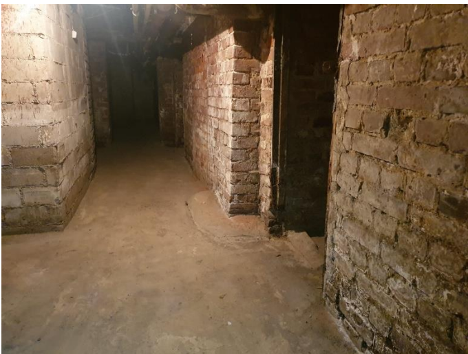
31. «Жилой дом с флигелем», Ленинградская область, Выборгский район, г. Выборг, ул. Садовая д.3,3а. Подвал. Фрагмент. Фото 20.08.2022г.
