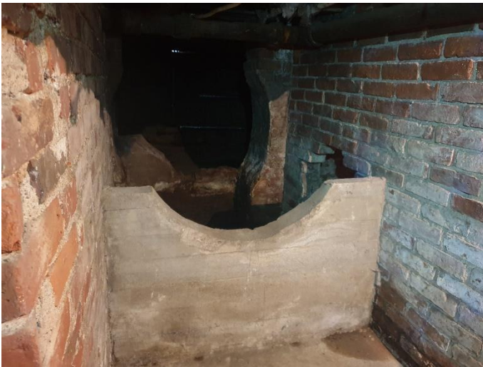
22. «Жилой дом с флигелем», Ленинградская область, Выборгский район, г. Выборг, ул. Садовая д.3,3а. Подвал. Фрагмент. Фото 20.08.2022г.
