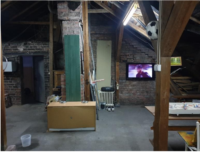
48. «Жилой дом с флигелем», Ленинградская область, Выборгский район, г. Выборг, ул. Садовая д.3,3а. Чердак. Общий вид. Фото 20.08.2022г.
