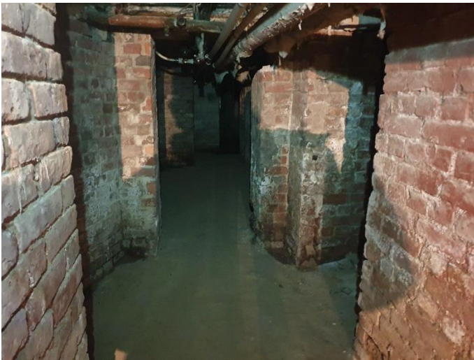
37. «Жилой дом с флигелем», Ленинградская область, Выборгский район, г. Выборг, ул. Садовая д.3,3а. Подвал. Фрагмент. Фото 20.08.2022г.
