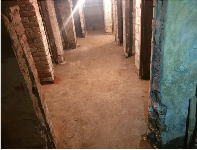
21. «Жилой дом с флигелем», Ленинградская область, Выборгский район, г. Выборг, ул. Садовая д.3,3а. Подвал. Фрагмент. Фото 20.08.2022г.
