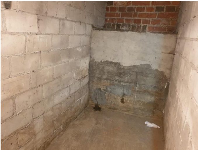
24. «Жилой дом с флигелем», Ленинградская область, Выборгский район, г. Выборг, ул. Садовая д.3,3а. Подвал. Фрагмент. Фото 20.08.2022г.
