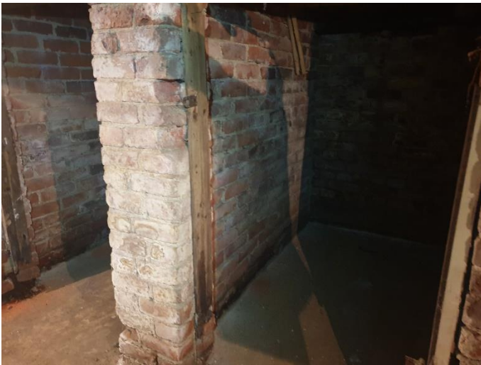
25. «Жилой дом с флигелем», Ленинградская область, Выборгский район, г. Выборг, ул. Садовая д.3,3а. Подвал. Фрагмент. Фото 20.08.2022г.
