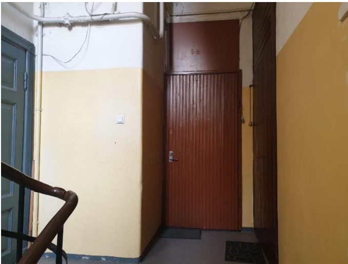
15. «Жилой дом с флигелем», Ленинградская область, Выборгский район, г. Выборг, ул. Садовая д.3,3а. Подъезд №2. Фрагмент. Фото 20.08.2022г.
