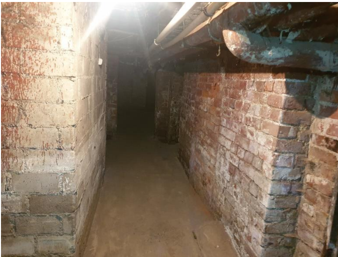
36. «Жилой дом с флигелем», Ленинградская область, Выборгский район, г. Выборг, ул. Садовая д.3,3а. Подвал. Фрагмент. Фото 20.08.2022г.
