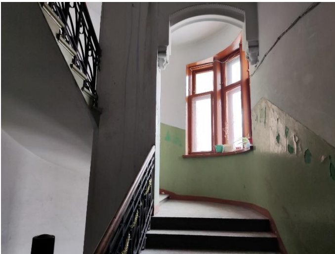
7. «Жилой дом с флигелем», Ленинградская область, Выборгский район, г. Выборг, ул. Садовая д.3,3а. Подъезд №1. Фрагмент. Фото 20.08.2022г.
