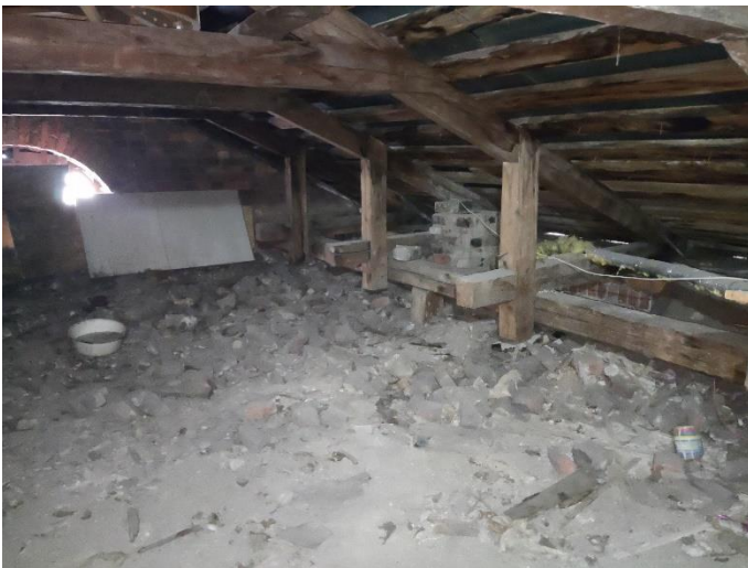
40. «Жилой дом», Ленинградская область, Выборгский район, г. Выборг, ул. Прогонная, д.1. Чердак. Фрагмент. Фото 20.08.2022г.
