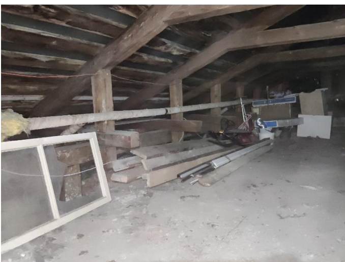
41. «Жилой дом», Ленинградская область, Выборгский район, г. Выборг, ул. Прогонная, д.1. Чердак. Фрагмент. Фото 20.08.2022г.
