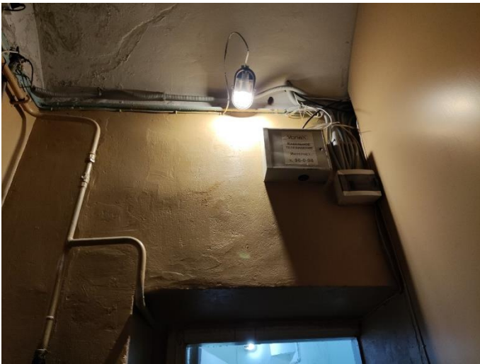
21. «Жилой дом», Ленинградская область, Выборгский район, г. Выборг, ул. Прогонная, д.1. Подъезд №4. Фрагмент. Фото 20.08.2022г.
