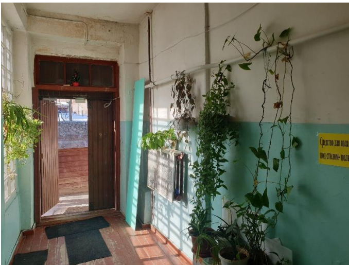
13. «Жилой дом», Ленинградская область, Выборгский район, г. Выборг, ул. Прогонная, д.1. Подъезд №3. Фрагмент. Фото 20.08.2022г.
