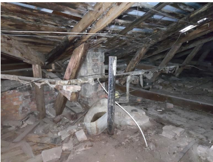
47. «Жилой дом», Ленинградская область, Выборгский район, г. Выборг, ул. Прогонная, д.1. Чердак. Фрагмент. Фото 20.08.2022г.
