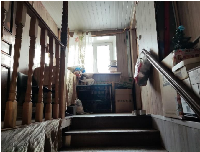
4. «Жилой дом», Ленинградская область, Выборгский район, г. Выборг, ул. Прогонная, д.1. Подъезд №1. Фрагмент. Фото 20.08.2022г.
