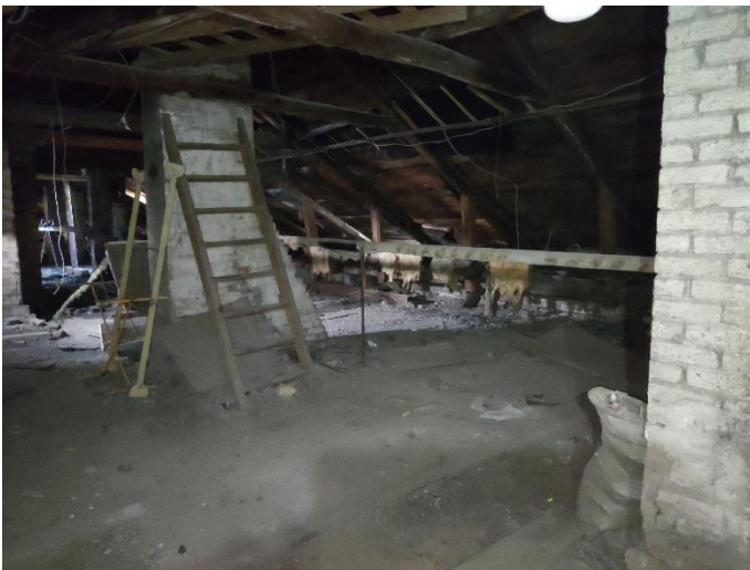
43. «Жилой дом», Ленинградская область, Выборгский район, г. Выборг, ул. Прогонная, д.1. Чердак. Фрагмент. Фото 20.08.2022г.
