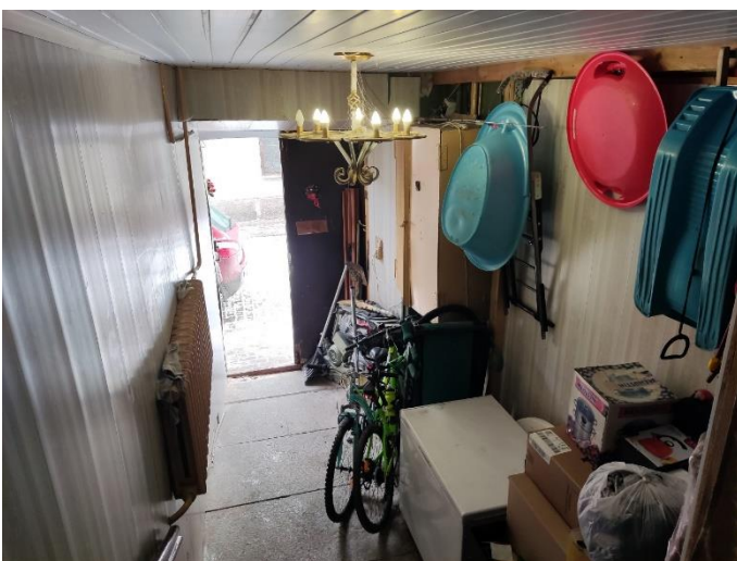
5. «Жилой дом», Ленинградская область, Выборгский район, г. Выборг, ул. Прогонная, д.1. Подъезд №1. Фрагмент. Фото 20.08.2022г.
