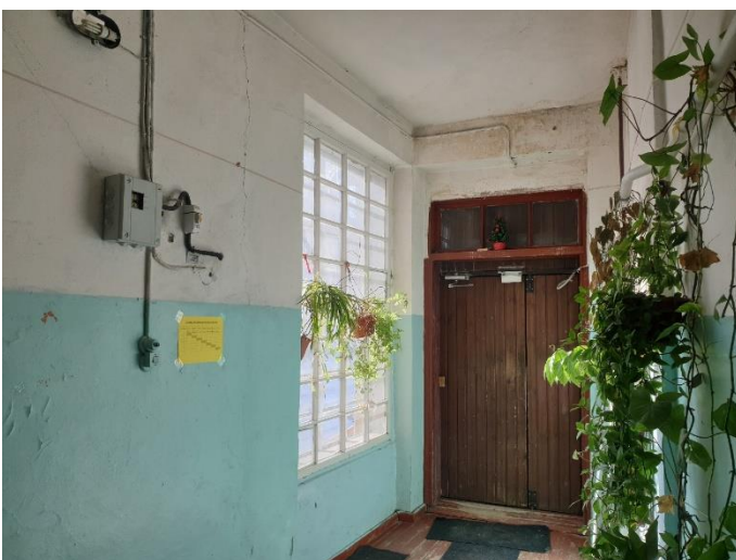
14. «Жилой дом», Ленинградская область, Выборгский район, г. Выборг, ул. Прогонная, д.1. Подъезд №3. Фрагмент. Фото 20.08.2022г.
