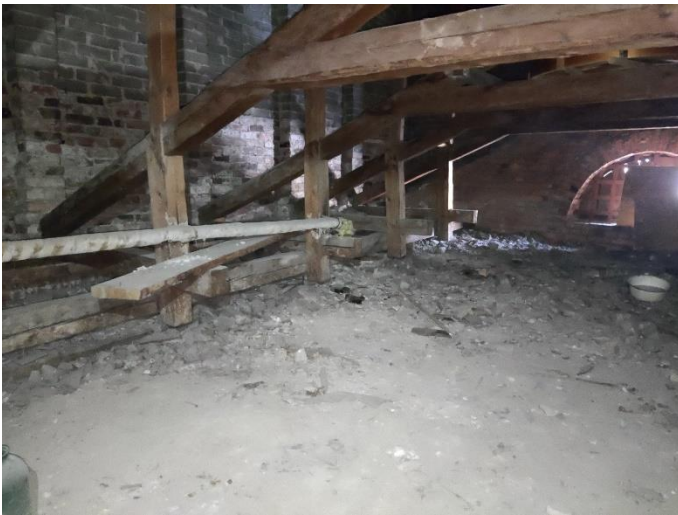
39. «Жилой дом», Ленинградская область, Выборгский район, г. Выборг, ул. Прогонная, д.1. Чердак. Фрагмент. Фото 20.08.2022г.
