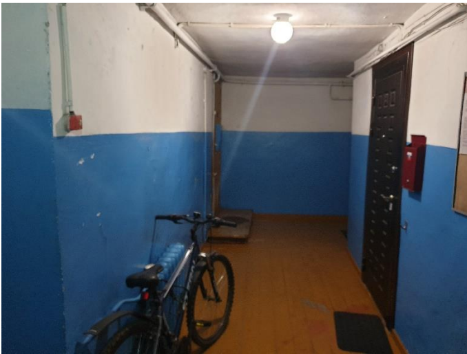
9. «Жилой дом», Ленинградская область, Выборгский район, г. Выборг, ул. Прогонная, д.1. Подъезд №2. Фрагмент. Фото 20.08.2022г.
