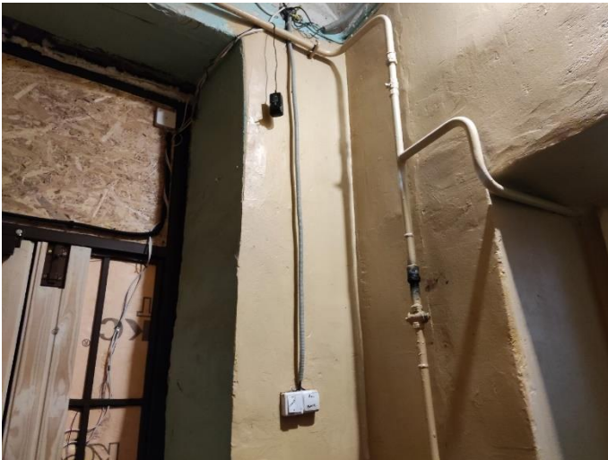
22. «Жилой дом», Ленинградская область, Выборгский район, г. Выборг, ул. Прогонная, д.1. Подъезд №4. Фрагмент. Фото 20.08.2022г.
