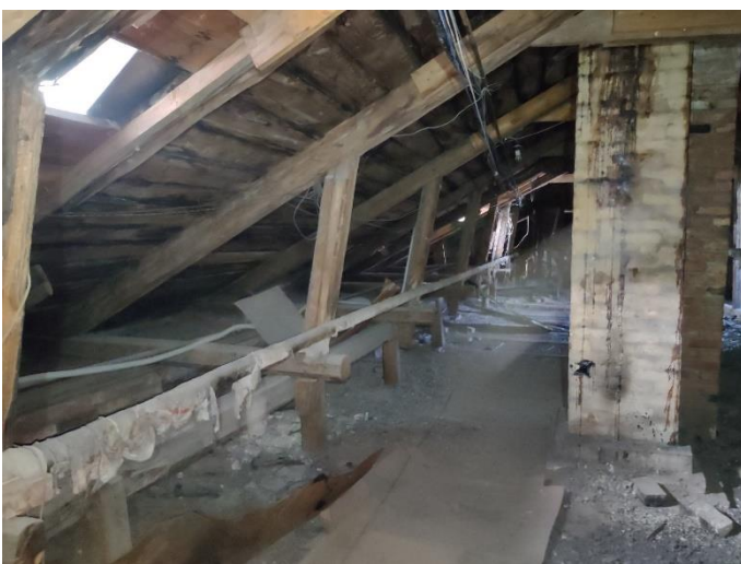
44. «Жилой дом», Ленинградская область, Выборгский район, г. Выборг, ул. Прогонная, д.1. Чердак. Фрагмент. Фото 20.08.2022г.
