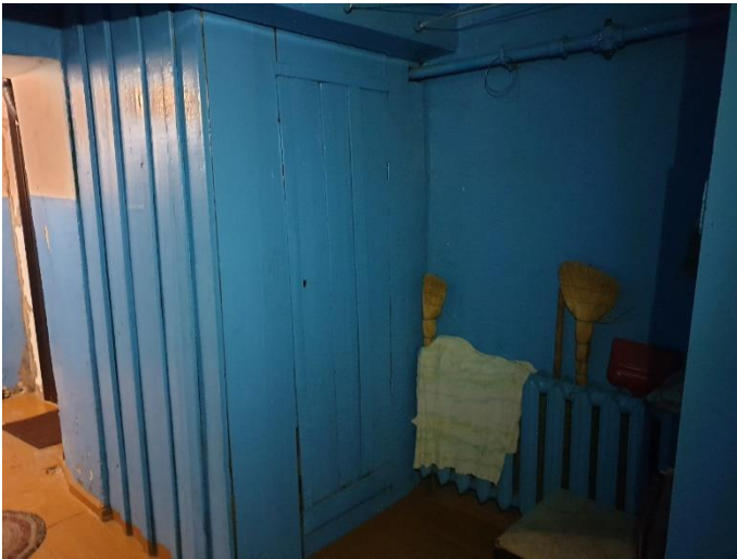
7. «Жилой дом», Ленинградская область, Выборгский район, г. Выборг, ул. Прогонная, д.1. Подъезд №2. Фрагмент. Фото 20.08.2022г.
