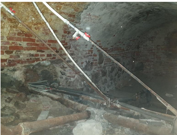
32. «Жилой дом», Ленинградская область, Выборгский район, г. Выборг, ул. Прогонная, д.1. Подвал. Фрагмент. Фото 20.08.2022г.
