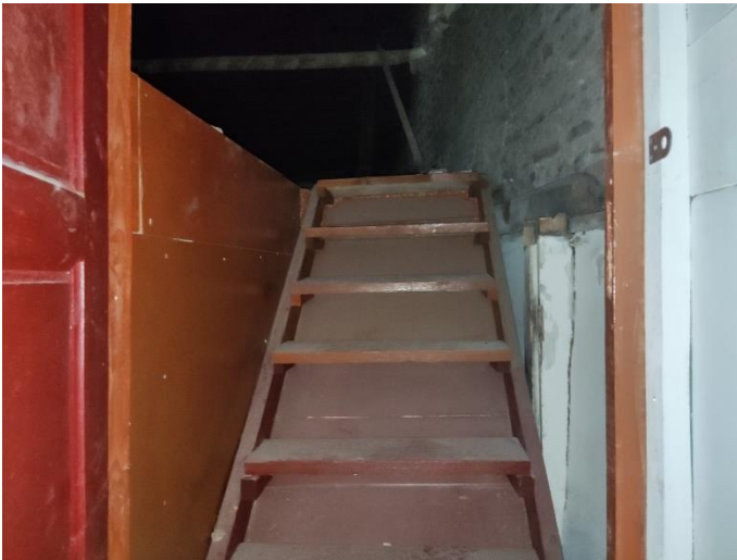
34. «Жилой дом», Ленинградская область, Выборгский район, г. Выборг, ул. Прогонная, д.1. Чердак. Фрагмент. Фото 20.08.2022г.
