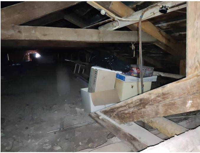
36. «Жилой дом», Ленинградская область, Выборгский район, г. Выборг, ул. Прогонная, д.1. Чердак. Фрагмент. Фото 20.08.2022г.
