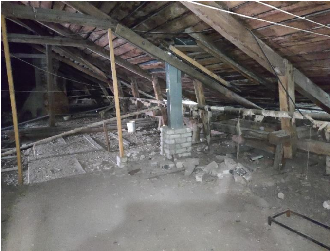
46. «Жилой дом», Ленинградская область, Выборгский район, г. Выборг, ул. Прогонная, д.1. Чердак. Фрагмент. Фото 20.08.2022г.
