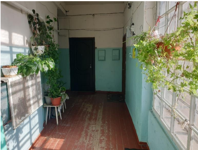
12. «Жилой дом», Ленинградская область, Выборгский район, г. Выборг, ул. Прогонная, д.1. Подъезд №3. Общий вид. Фото 20.08.2022г.
