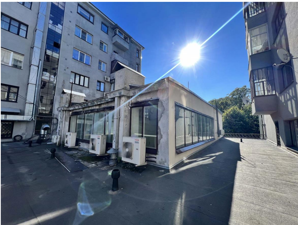
Фото 6. Общий вид светового фонаря Корпуса 3 с севера. Дата съемки: 08.09.2022 г. Автор съемки: Куваева Ю.П.
