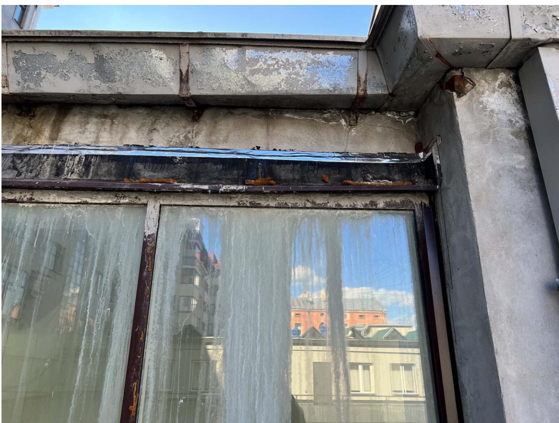
Фото 14. Фрагмент центральной части северо-восточного фасада светового фонаря. Дата съемки: 08.09.2022 г. Автор съемки: Куваева Ю.П.
