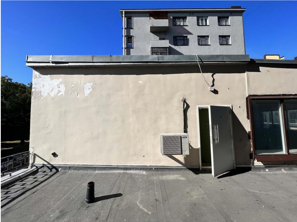
Фото 7. Фрагмент юго-восточного фасада светового фонаря. Левая часть. Дата съемки: 08.09.2022 г. Автор съемки: Куваева Ю.П.
