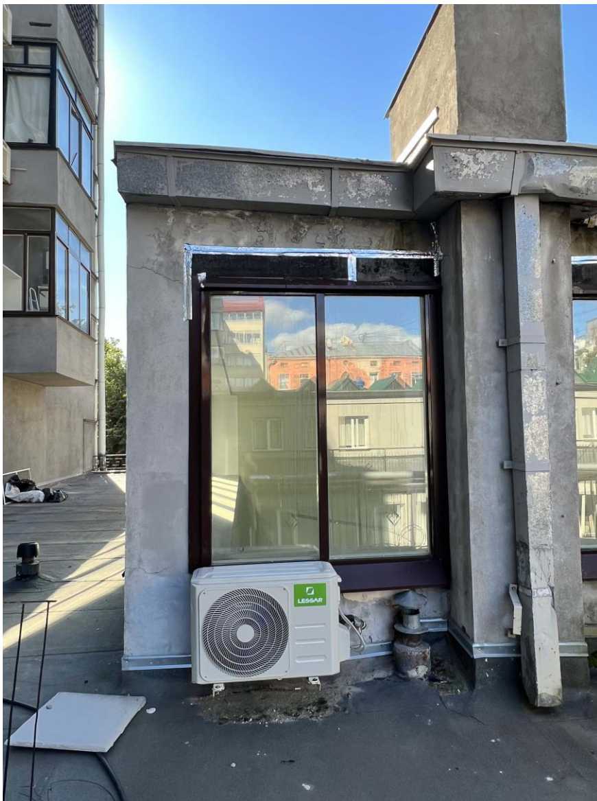
Фото 10. Фрагмент северо-восточного фасада светового фонаря. Дата съемки: 08.09.2022 г. Автор съемки: Куваева Ю.П.
