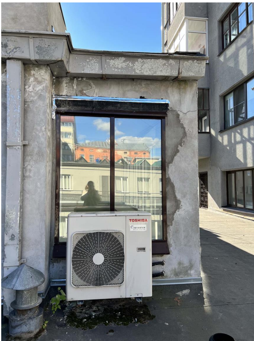
Фото 15. Фрагмент северо-восточного фасада светового фонаря. Дата съемки: 08.09.2022 г. Автор съемки: Куваева Ю.П.
