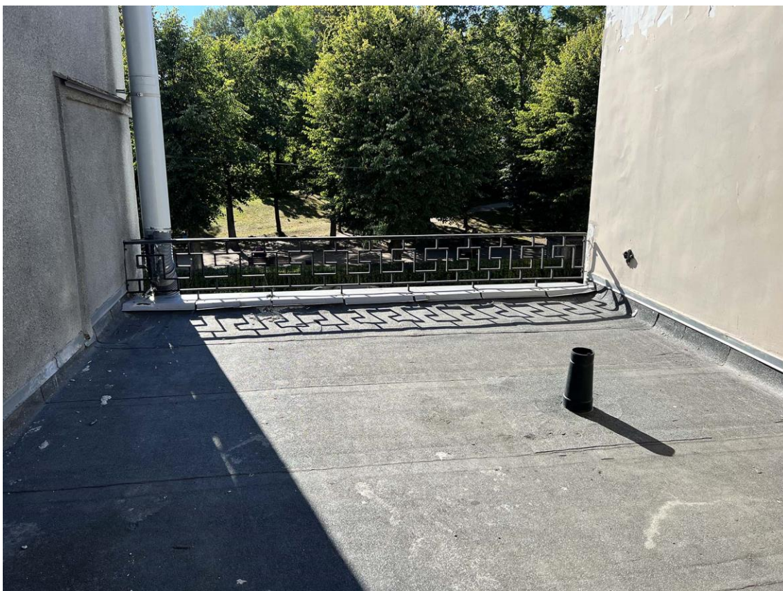
Фото 17. Фрагмент покрытия кровли-террасы в северо-западной части здания. Первоначальное металлическое ограждение уличного фасада. Дата съемки: 08.09.2022 г. Автор съемки: Куваева Ю.П.
