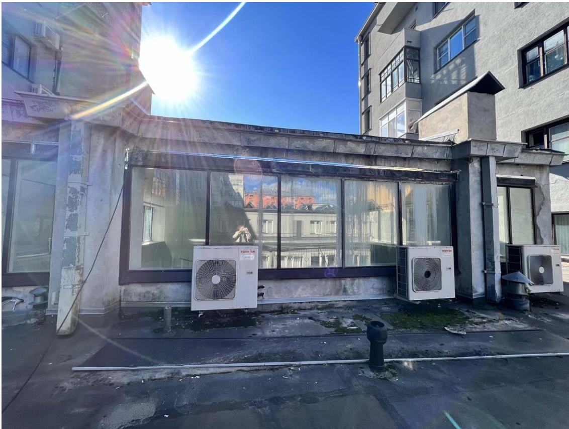
Фото 11. Фрагмент северо-восточного фасада светового фонаря. Дата съемки: 08.09.2022 г. Автор съемки: Куваева Ю.П.
