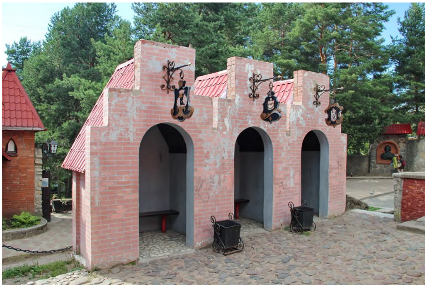
65 Выявленный ОКН «Детский игровой комплекс «Андерсенград», адрес: Ленинградская обл., г. Сосновый Бор, ул. Солнечная, д. 1. Торговые ряды «Три брата». Восточный фасад. Дата съемки: 19.07.2022 г.
