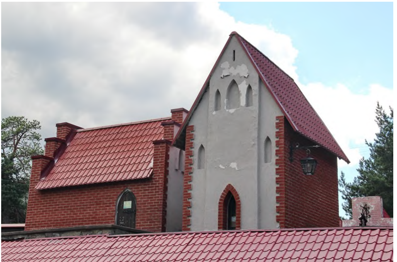
57 Выявленный ОКН «Детский игровой комплекс «Андерсенград», адрес: Ленинградская обл., г. Сосновый Бор, ул. Солнечная, д. 1. Домик Оле-Лукойе. Радиорубка. Восточный и северный фасады. Дата съемки: 19.07.2022 г.
