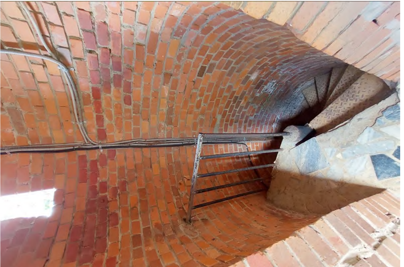
41 Выявленный ОКН «Детский игровой комплекс «Андерсенград», адрес: Ленинградская обл., г. Сосновый Бор, ул. Солнечная, д. 1. Рагуша. Лестница. Дата съемки: 19.07.2022 г.
