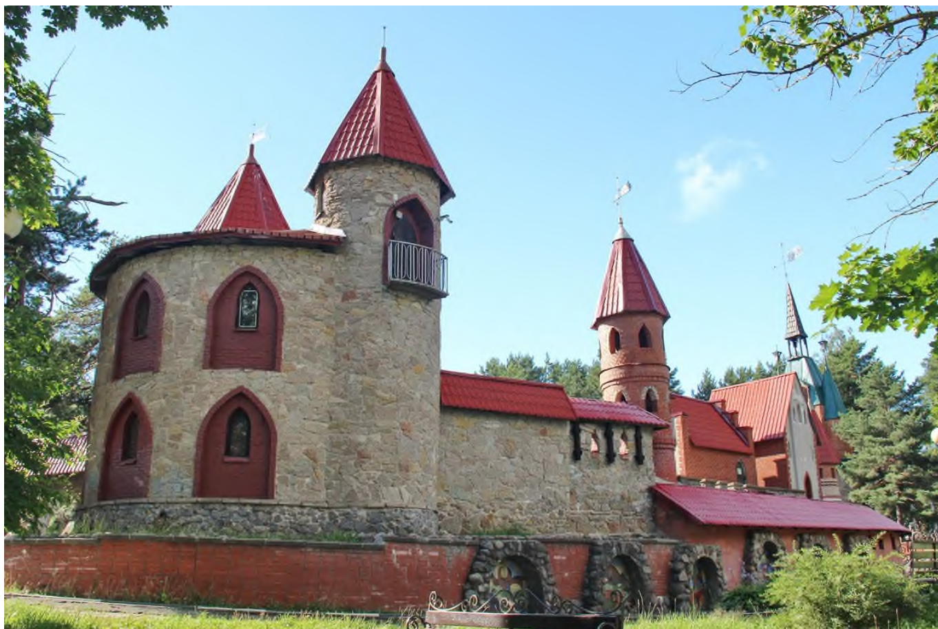
45 Выявленный ОКН «Детский игровой комплекс «Андерсенград», адрес: Ленинградская обл., г. Сосновый Бор, ул. Солнечная, д. 1. Амфитеатр «Дюймовочка». Южный и восточный фасады. Дата съемки: 19.07.2022 г.
