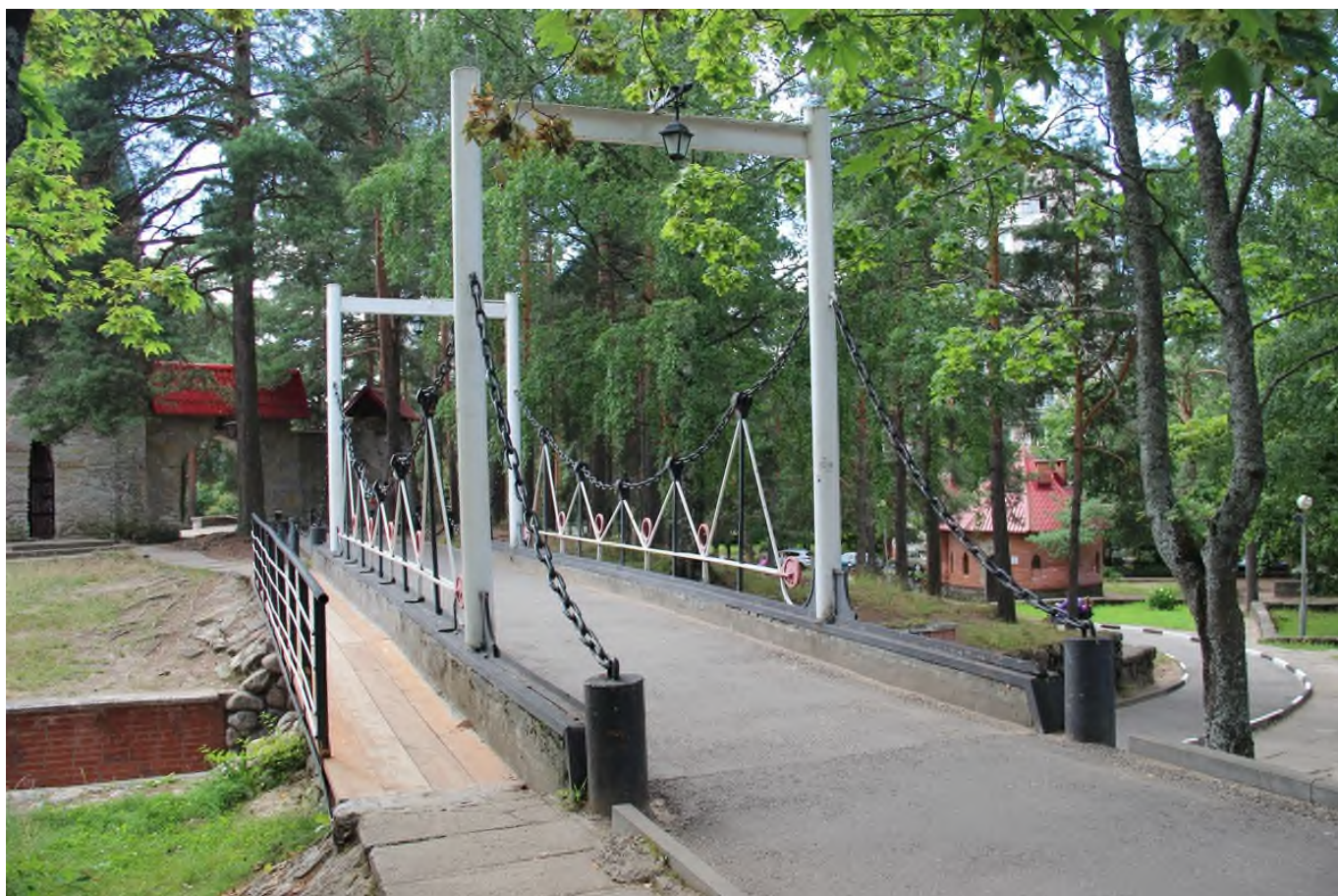
80 Выявленный ОКН «Детский игровой комплекс «Андерсенград», адрес: Ленинградская обл., г. Сосновый Бор, ул. Солнечная, д. 1. Мост. Вид с северо-востока. Дата съемки: 19.07.2022 г.
