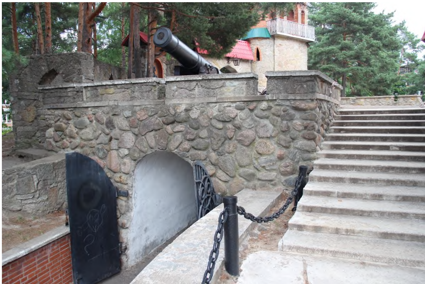
70 Выявленный ОКН «Детский игровой комплекс «Андерсенград», адрес: Ленинградская обл., г. Сосновый Бор, ул. Солнечная, д. 1. Форт. Вид с юга. Дата съемки: 19.07.2022 г.
