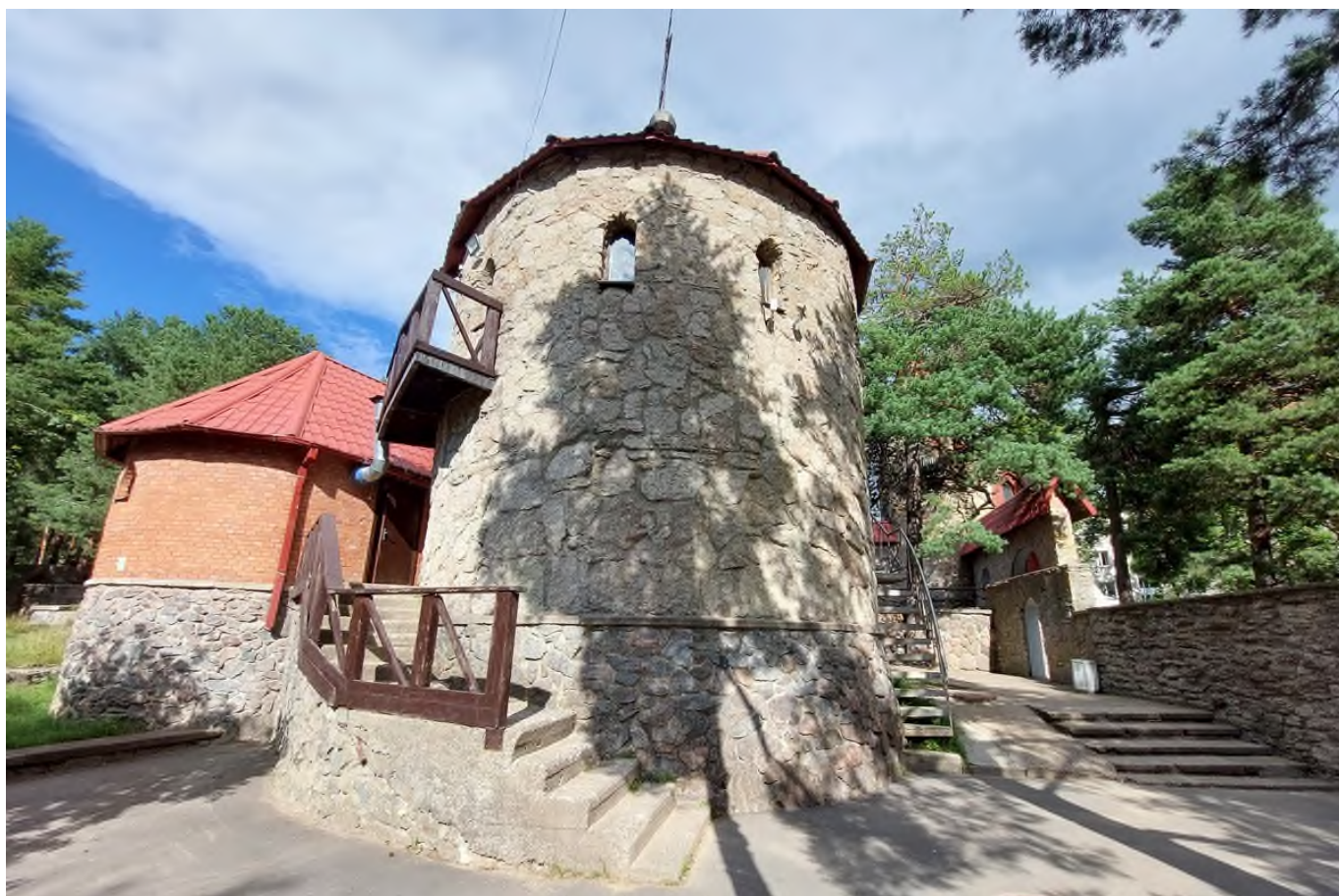
32 Выявленный ОКН «Детский игровой комплекс «Андерсенград», адрес: Ленинградская обл., г. Сосновый Бор, ул. Солнечная, д. 1. Кафе «Белоснежка и семь гномов». Западный и южный фасады. Дата съемки: 19.07.2022 г.
