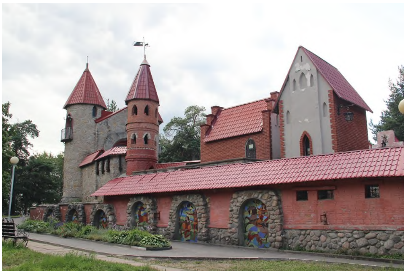
84 Выявленный ОКН «Детский игровой комплекс «Андерсенград», адрес: Ленинградская обл., г. Сосновый Бор, ул. Солнечная, д. 1. Мозаичные панно на восточной стене комплекса. Вид с северо-востока. Дата съемки: 19.07.2022 г.
