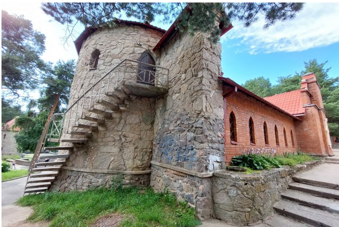
31 Выявленный ОКН «Детский игровой комплекс «Андерсенград», адрес: Ленинградская обл., г. Сосновый Бор, ул. Солнечная, д. 1. Кафе «Белоснежка и семь гномов». Южный и восточный фасады. Дата съемки: 19.07.2022 г.
