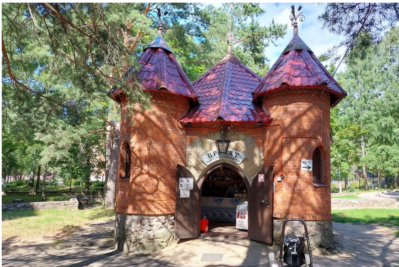
74 Выявленный ОКН «Детский игровой комплекс «Андерсенград», адрес: Ленинградская обл., г. Сосновый Бор, ул. Солнечная, д. 1. Гараж детских автомобилей, туалет. Юго-западный фасад. Дата съемки: 19.07.2022 г.
