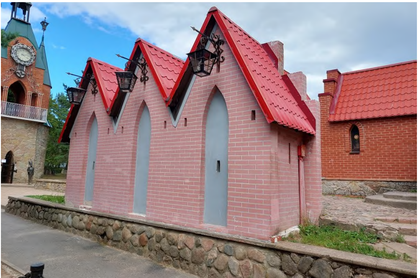
64 Выявленный ОКН «Детский игровой комплекс «Андерсенград», адрес: Ленинградская обл., г. Сосновый Бор, ул. Солнечная, д. 1. Торговые ряды «Три брата». Западный и южный фасады. Дата съемки: 19.07.2022 г.
