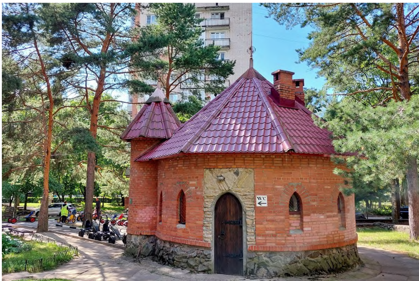
76 Выявленный ОКН «Детский игровой комплекс «Андерсенград», адрес: Ленинградская обл., г. Сосновый Бор, ул. Солнечная, д. 1. Гараж детских автомобилей, туалет. Восточный фасад. Дата съемки: 19.07.2022 г.
