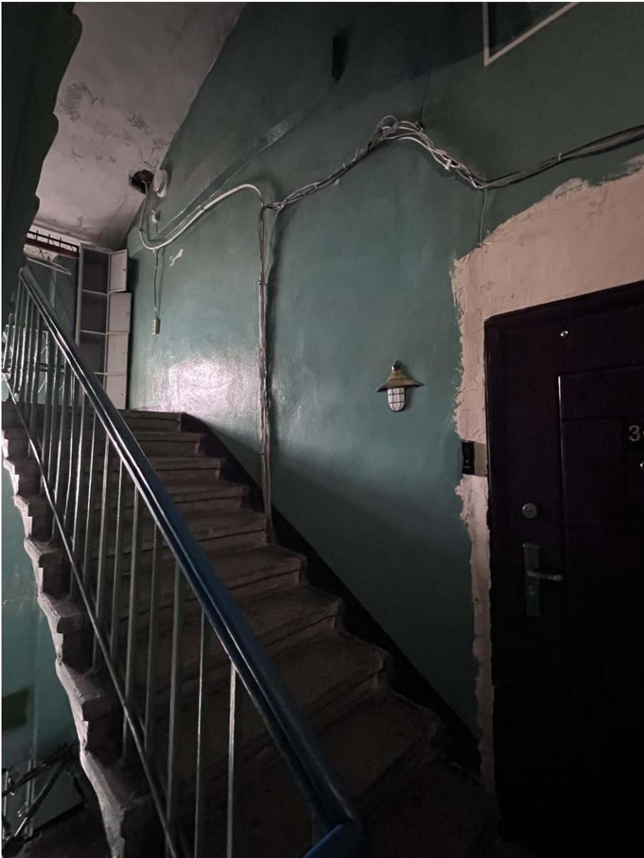
Фото 15. ЛК-2. Прокладка электрокабелей по стене между 3-им этажом и чердаком открытым способом. Дата съемки: 19.05.2022 г. Автор съемки: Куваева Ю.П.
