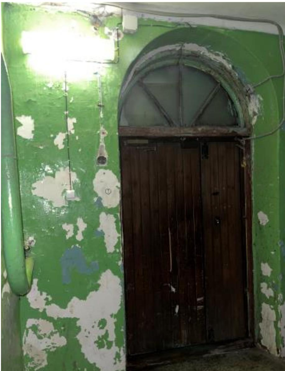
Фото 6. ЛК-1. Первый подъезд. Прокладка электрокабелей по наружной стене открытым способом. Дата съемки: 19.05.2022 г. Автор съемки: Куваева Ю.П.
