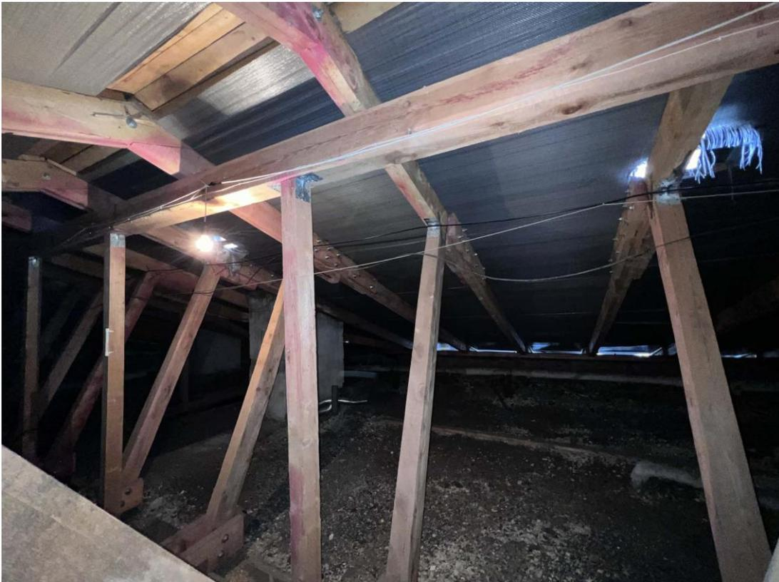
Фото 20. Помещение чердака. Прокладка электропроводов без защиты по деревянным конструкциям стропильной системы. Дата съемки: 19.05.2022 г.
