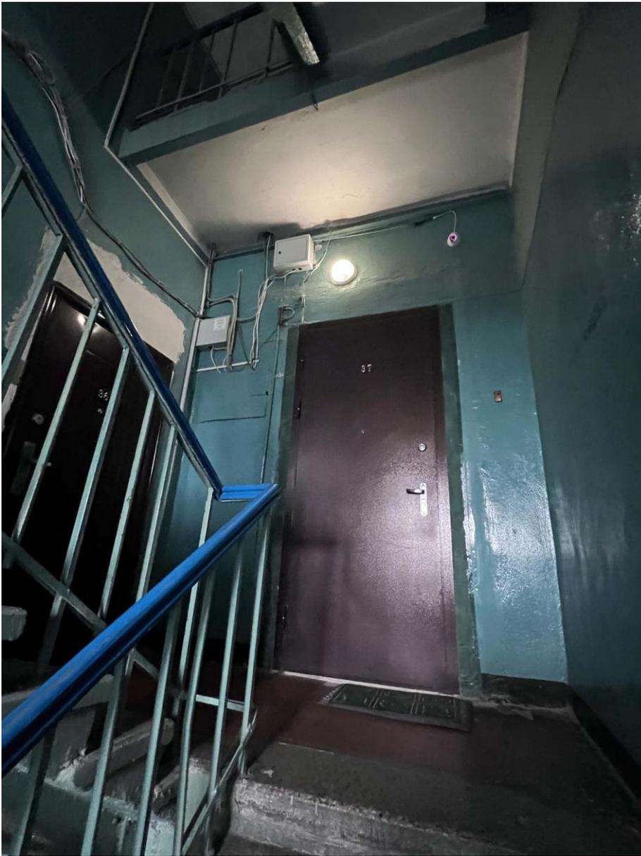
Фото 14. ЛК-2. 3-ий этаж. Прокладка электрокабелей по стенам и в плите лестничной площадки открытым способом. Дата съемки: 19.05.2022 г. Автор съемки: Куваева Ю.П.
