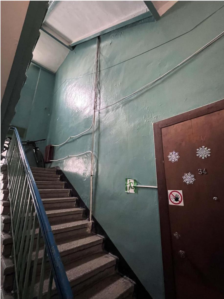
Фото 13. ЛК-2. Прокладка электрокабелей по стене между 2-ый и 3-им этажами открытым способом. Дата съемки: 19.05.2022 г. Автор съемки: Куваева Ю.П.
