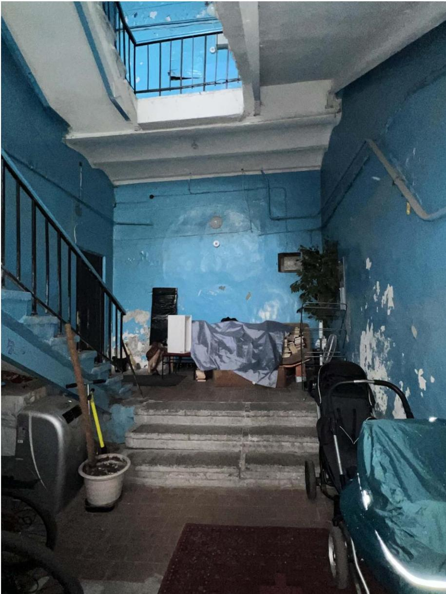
Фото 18. ЛК\_3. Прокладка электрокабелей открытым способом и в стальной трубе по стенам 1-го этажа. Дата съемки: 19.05.2022 г. Автор съемки: Куваева Ю.П.
