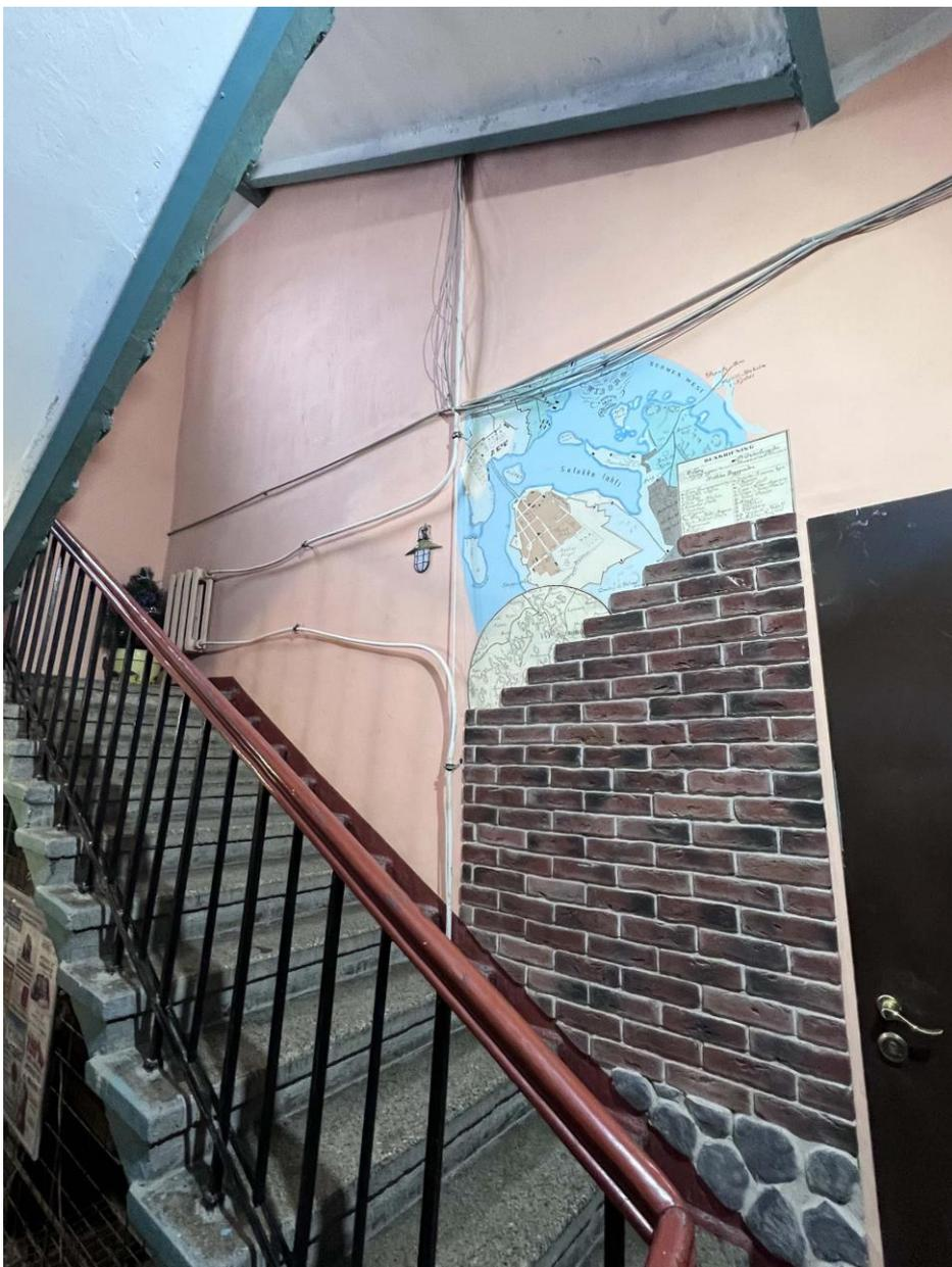
Фото 11. ЛК-2. Прокладка электрокабелей по стене между 1-ым и 2-ым этажами открытым способом. Дата съемки: 19.05.2022 г. Автор съемки: Куваева Ю.П.
