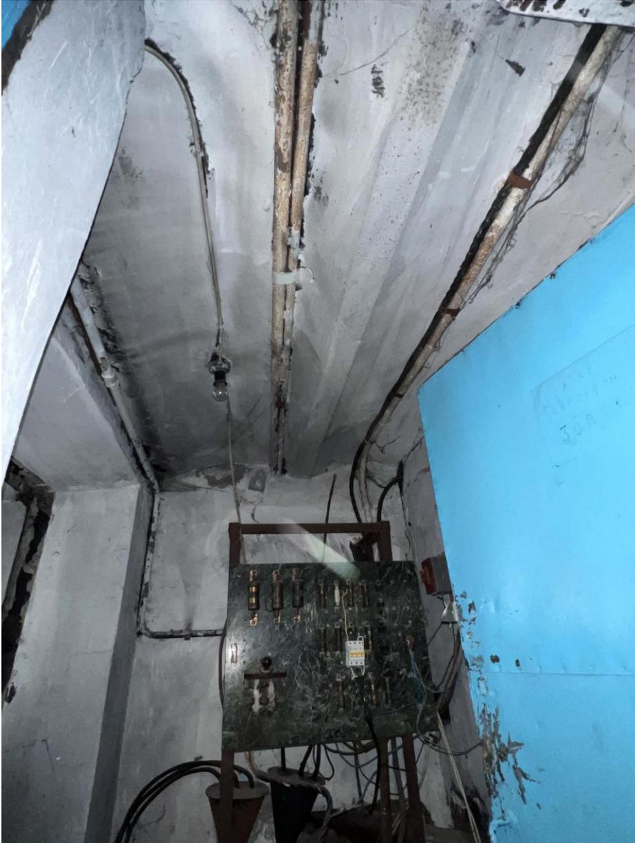
Фото 17. ЛК-3. ГРЩ в помещении 1-го этажа с левой стороны от входа. Прокладка электрокабелей в стальных трубах под перекрытием. Дата съемки: 19.05.2022 г. Автор съемки: Куваева Ю.П.
