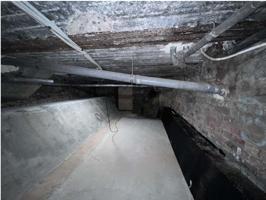
Фото 18. Пом. 5. Вид на северо-восточную часть помещения с юго-запада. Дата съемки: 19.05.2022 г. Автор съемки: Куваева Ю.П.
