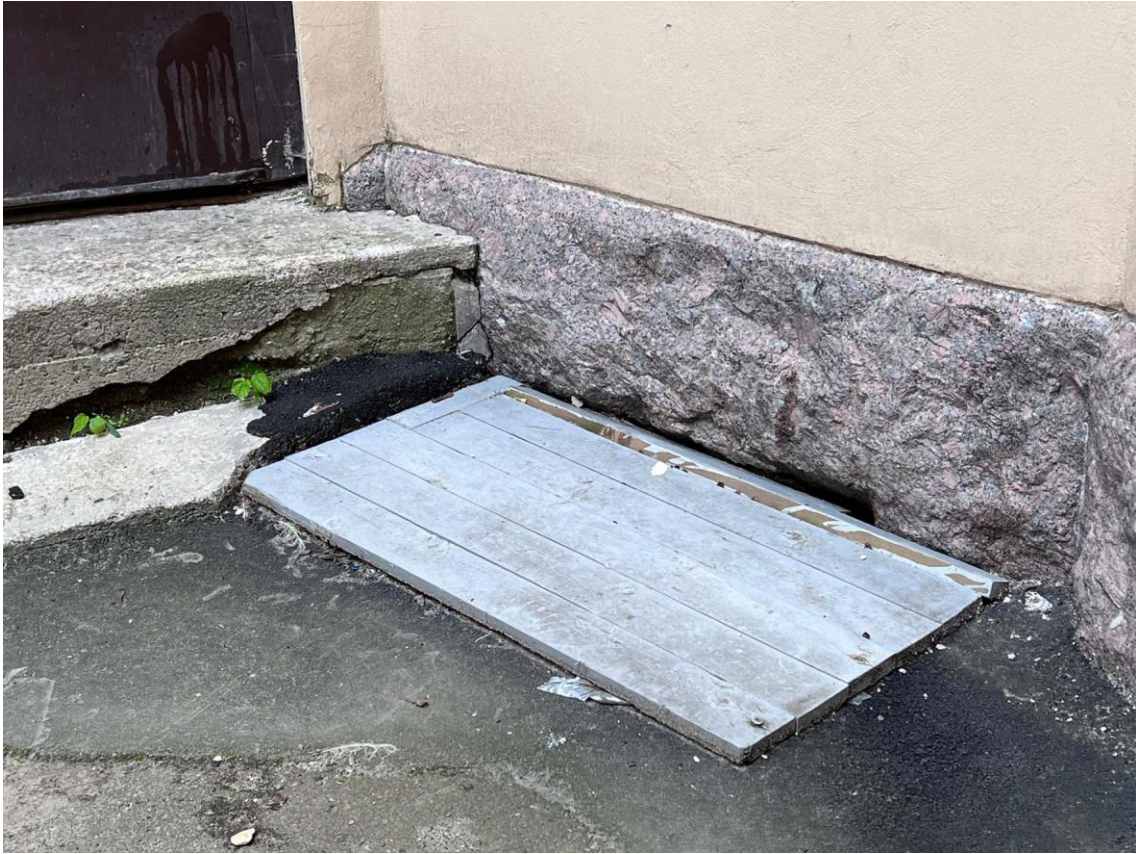
Фото 7. Зашитый приямок у западного угла дворовых фасадов юго-восточной части здания. Дата съемки: 19.05.2022 г. Автор съемки: Куваева Ю.П.
