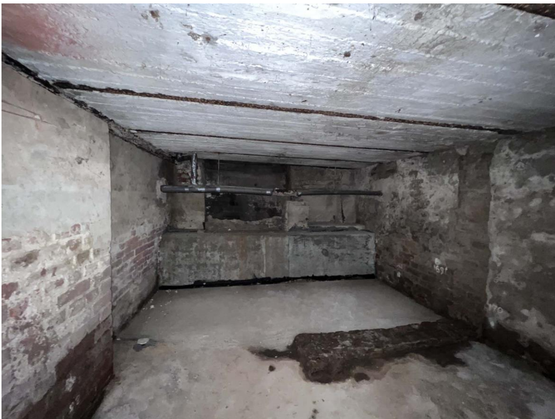
Фото 21. Пом. 7. Общий вид помещения с северо-востока. Дата съемки: 19.05.2022 г. Автор съемки: Куваева Ю.П.
