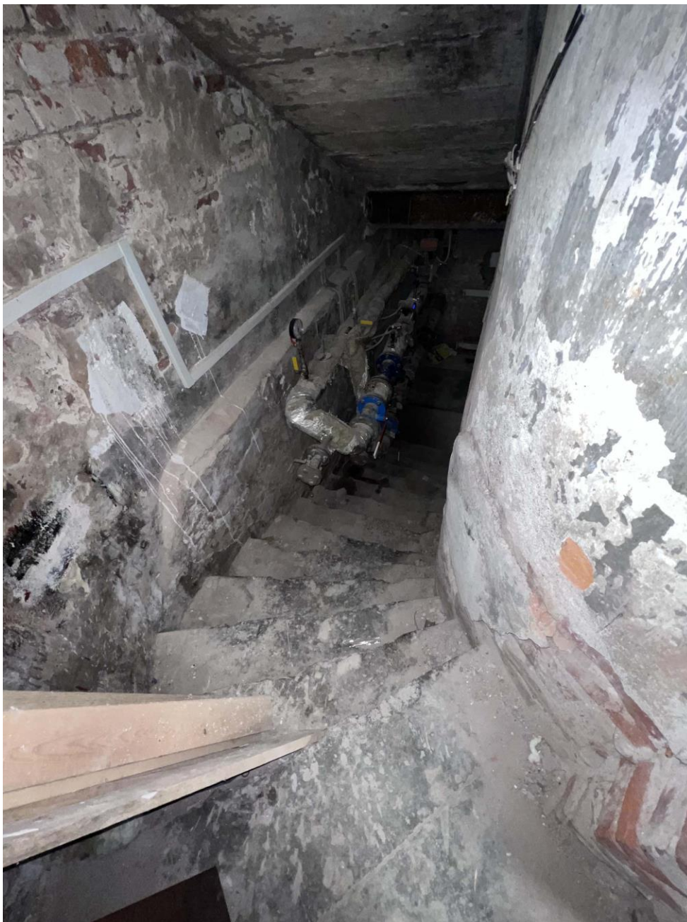
Фото 8. Спуск в подвал в центральной части здания. Дата съемки: 19.05.2022 г. Автор съемки: Куваева Ю.П.
