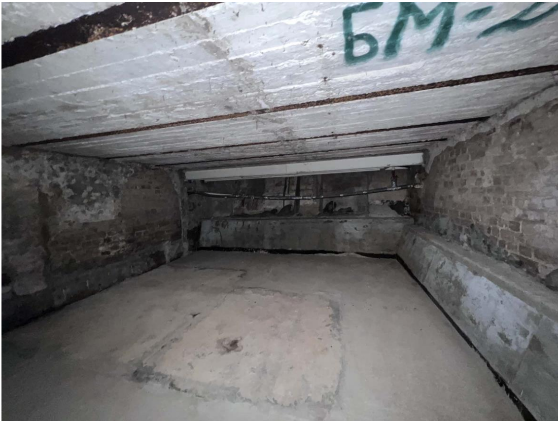
Фото 20. Пом. 6. Общий вид помещения с северо-востока. Дата съемки: 19.05.2022 г. Автор съемки: Куваева Ю.П.
