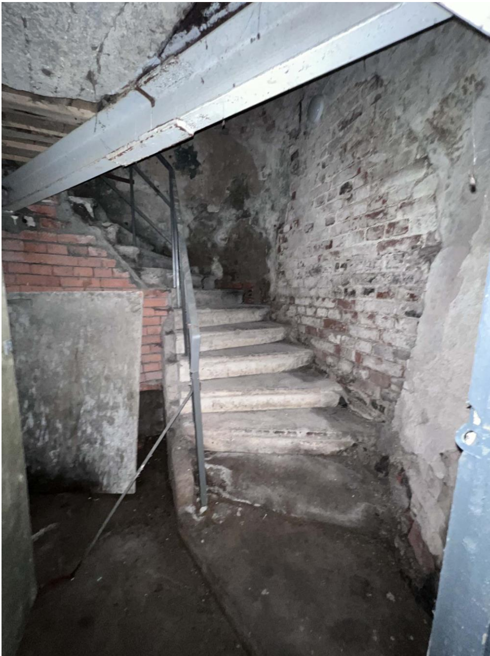
Фото 28. Помещение лестничной клетки за пом. 30. Общий вид лестницы с запада. Дата съемки: 19.05.2022 г. Автор съемки: Куваева Ю.П.
