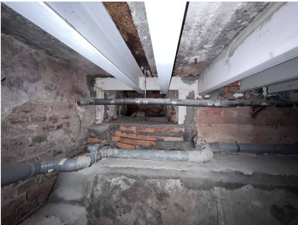
Фото 16. Пом. 4. Заложенный оконный проем в северном углу помещения. Фото с юго-запада. Дата съемки: 19.05.2022 г. Автор съемки: Куваева Ю.П.
