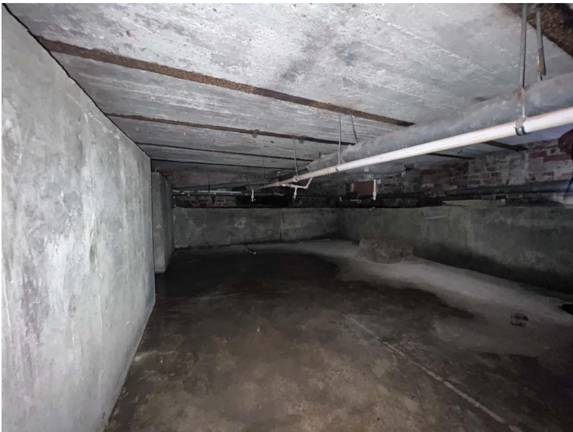
Фото 34. Пом. 20. Общий вид помещения с запада. Дата съемки: 19.05.2022 г. Автор съемки: Куваева Ю.П.
