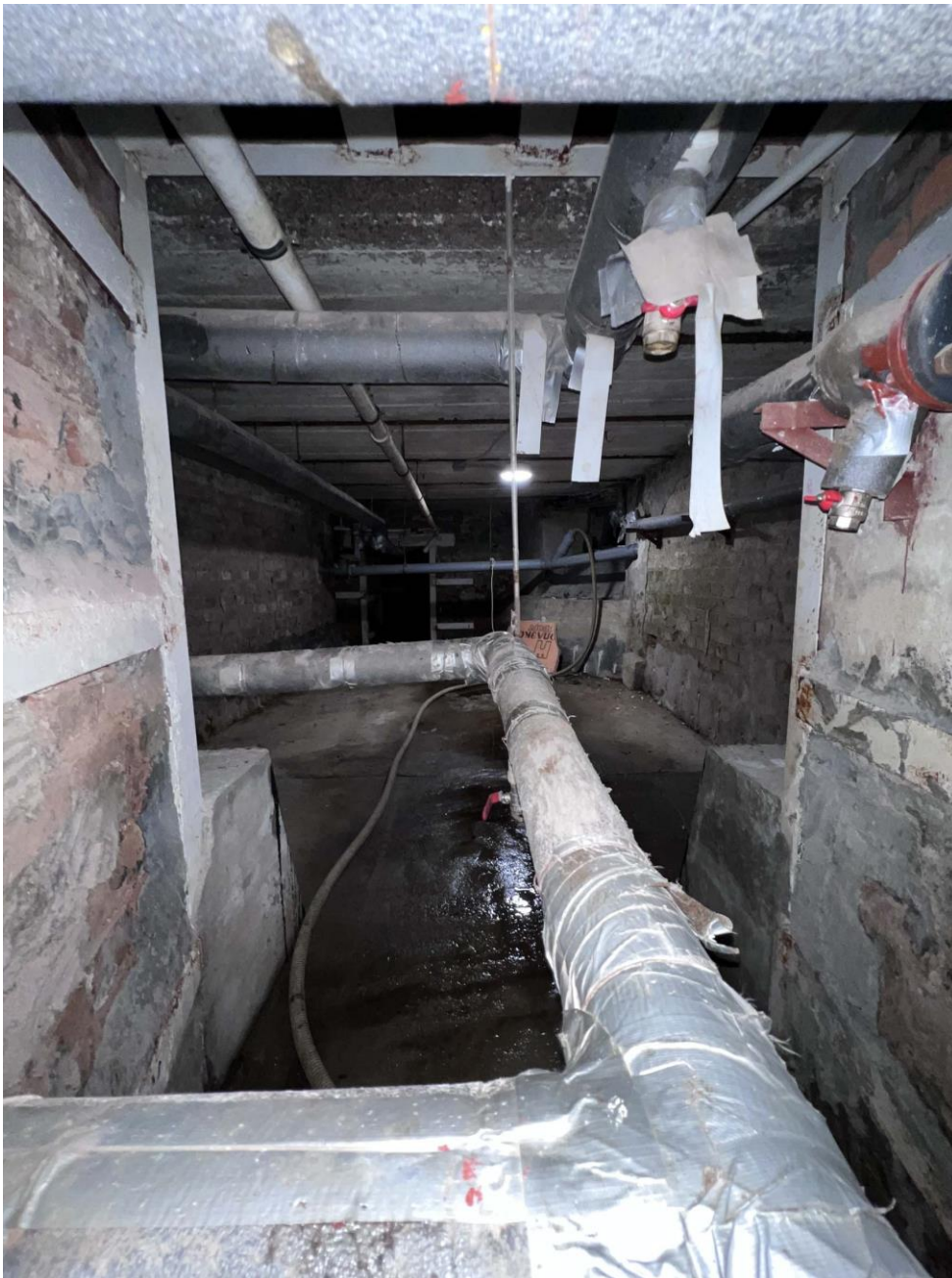
Фото 29. Вид на пом. 18 со стороны пом. 3. Фото с юго-запада. Дата съемки: 19.05.2022 г. Автор съемки: Куваева Ю.П.
