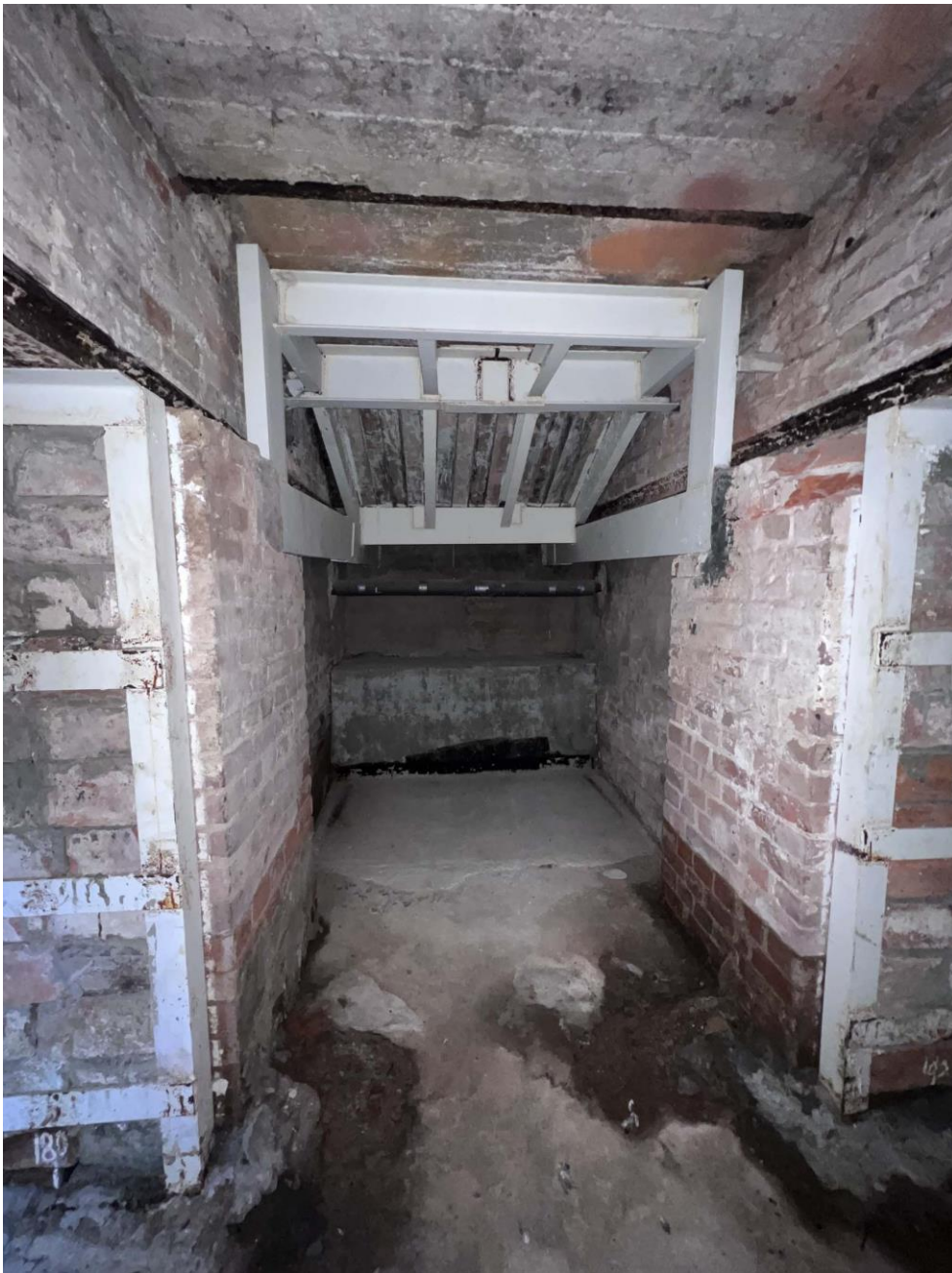
Фото 23. Пом. 8. Общий вид помещения с северо-востока. Дата съемки: 19.05.2022 г. Автор съемки: Куваева Ю.П.
