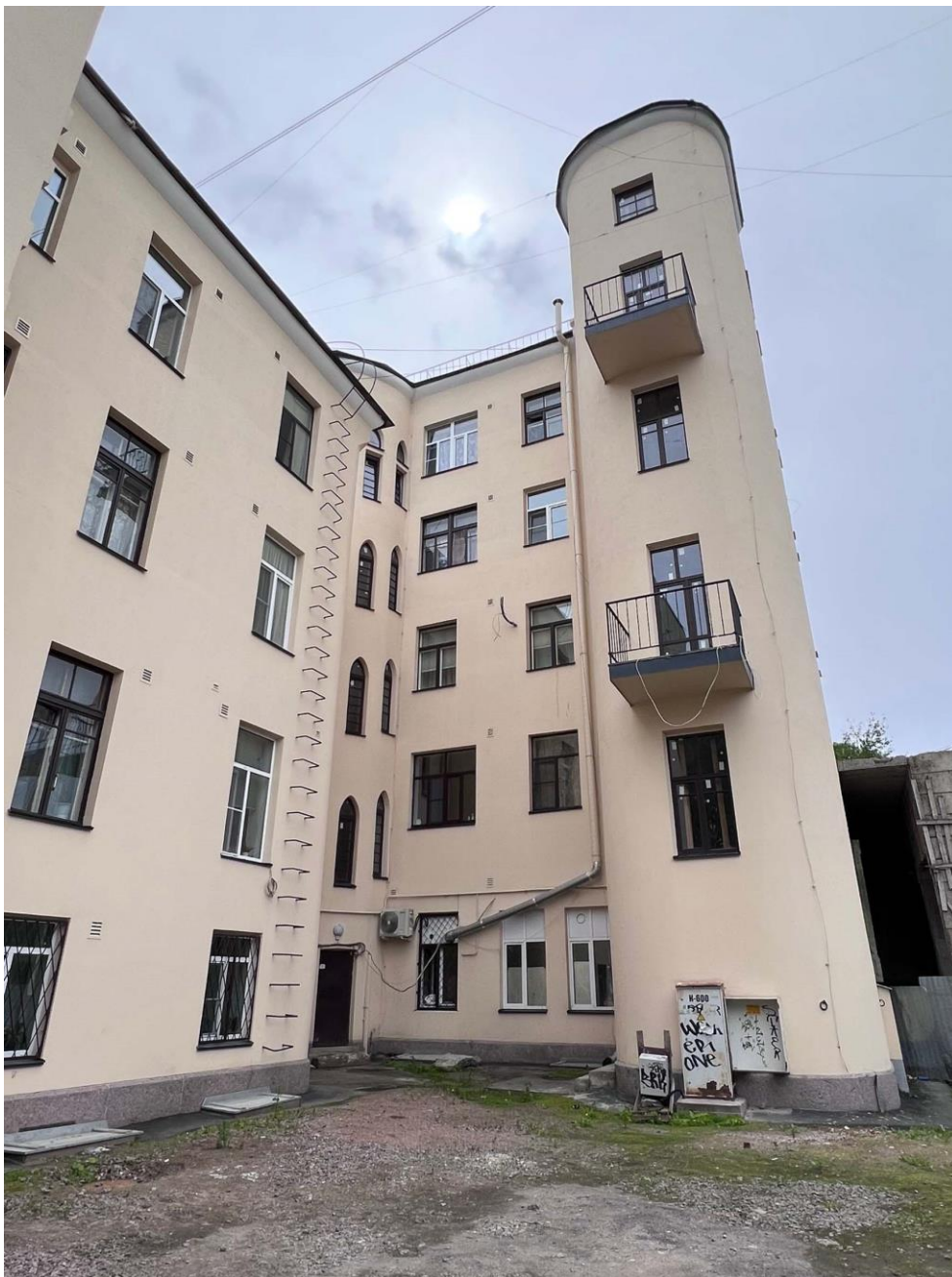
Фото 3. Общий вид дворовых фасадов северо-западной части здания. Дата съемки: 19.05.2022 г. Автор съемки: Куваева Ю.П.
