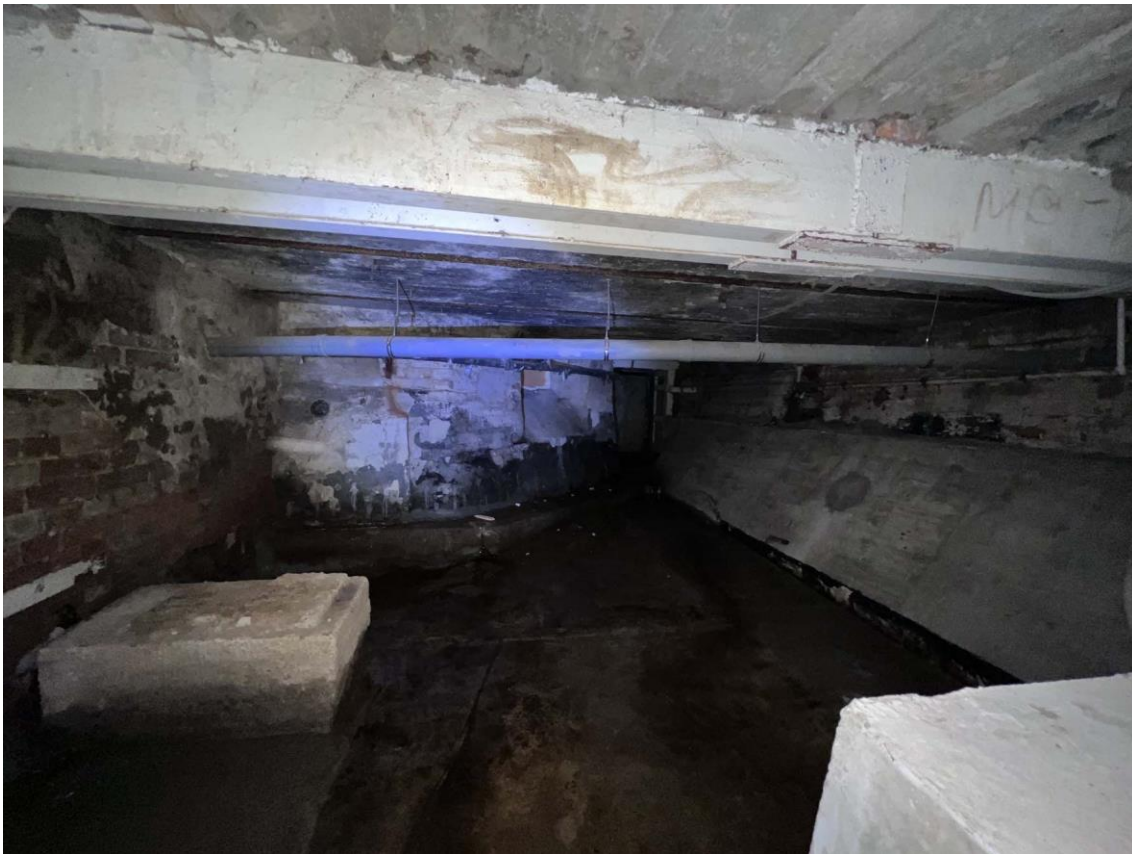
Фото 26. Пом. 15. Общий вид помещения с северо-востока. Дата съемки: 19.05.2022 г. Автор съемки: Куваева Ю.П.
