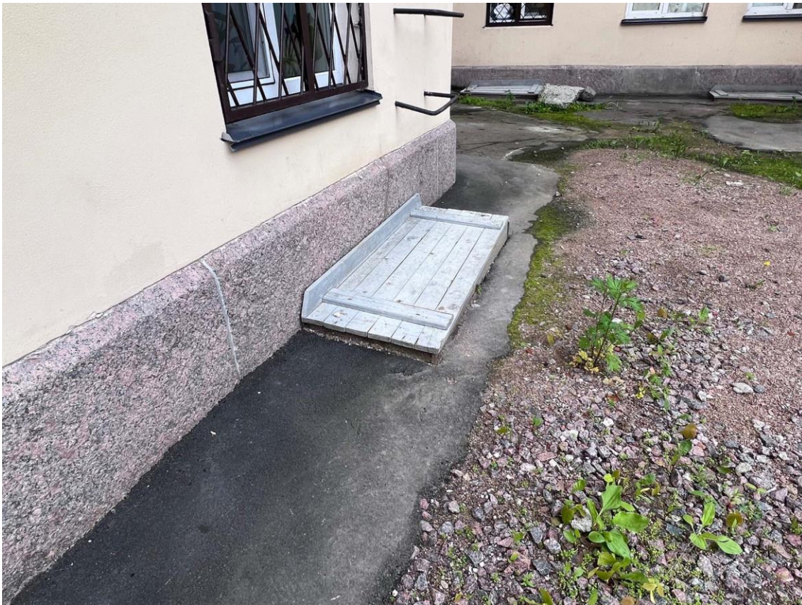
Фото 5. Защитный приямок у северо-западного фасада дворового крыла здания. Дата съемки: 19.05.2022 г. Автор съемки: Куваева Ю.П.
