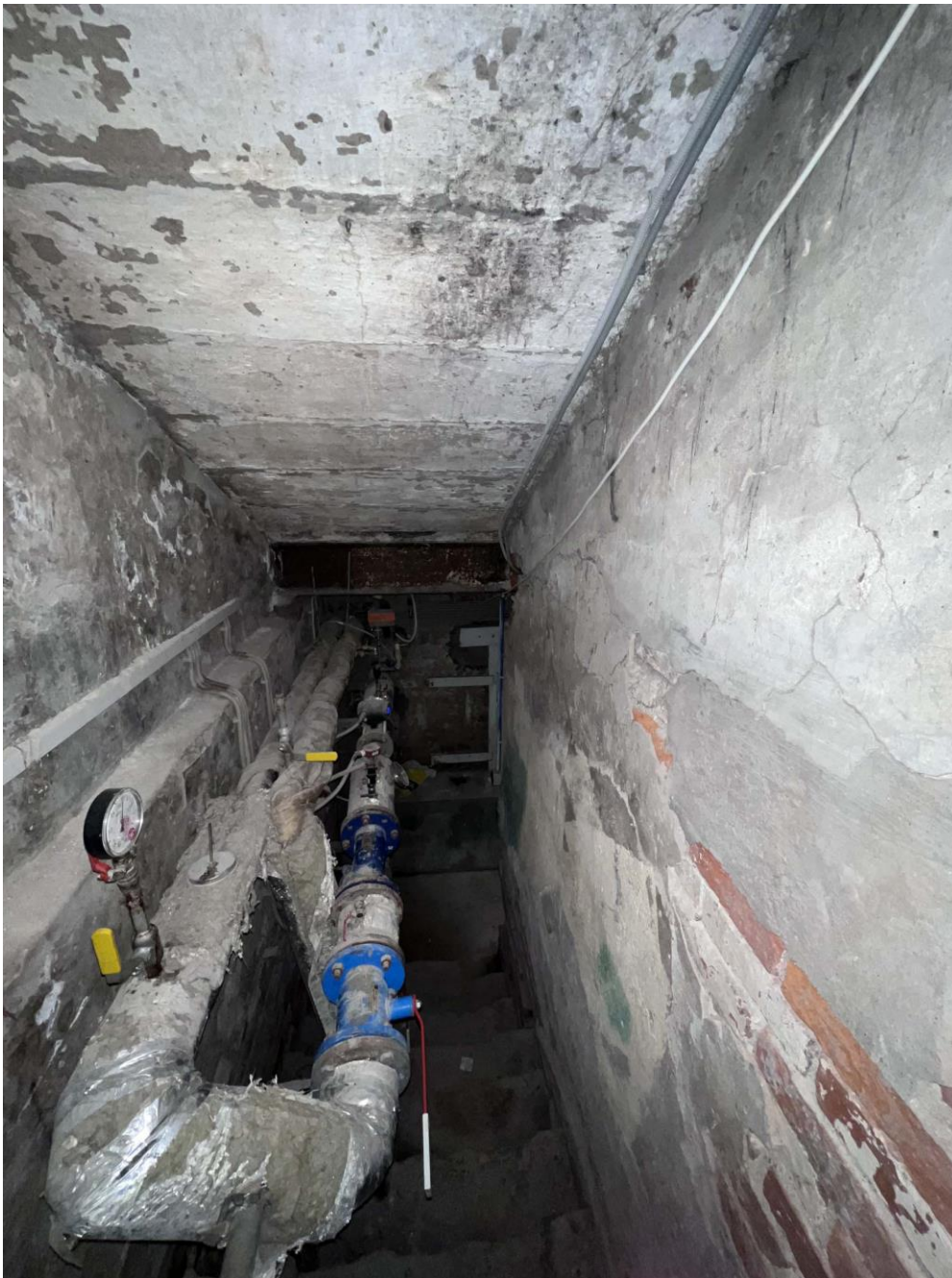
Фото 9. Пом. 1. Вид помещения под лестницей – спуска в подвал. Дата съемки: 19.05.2022 г. Автор съемки: Куваева Ю.П.
