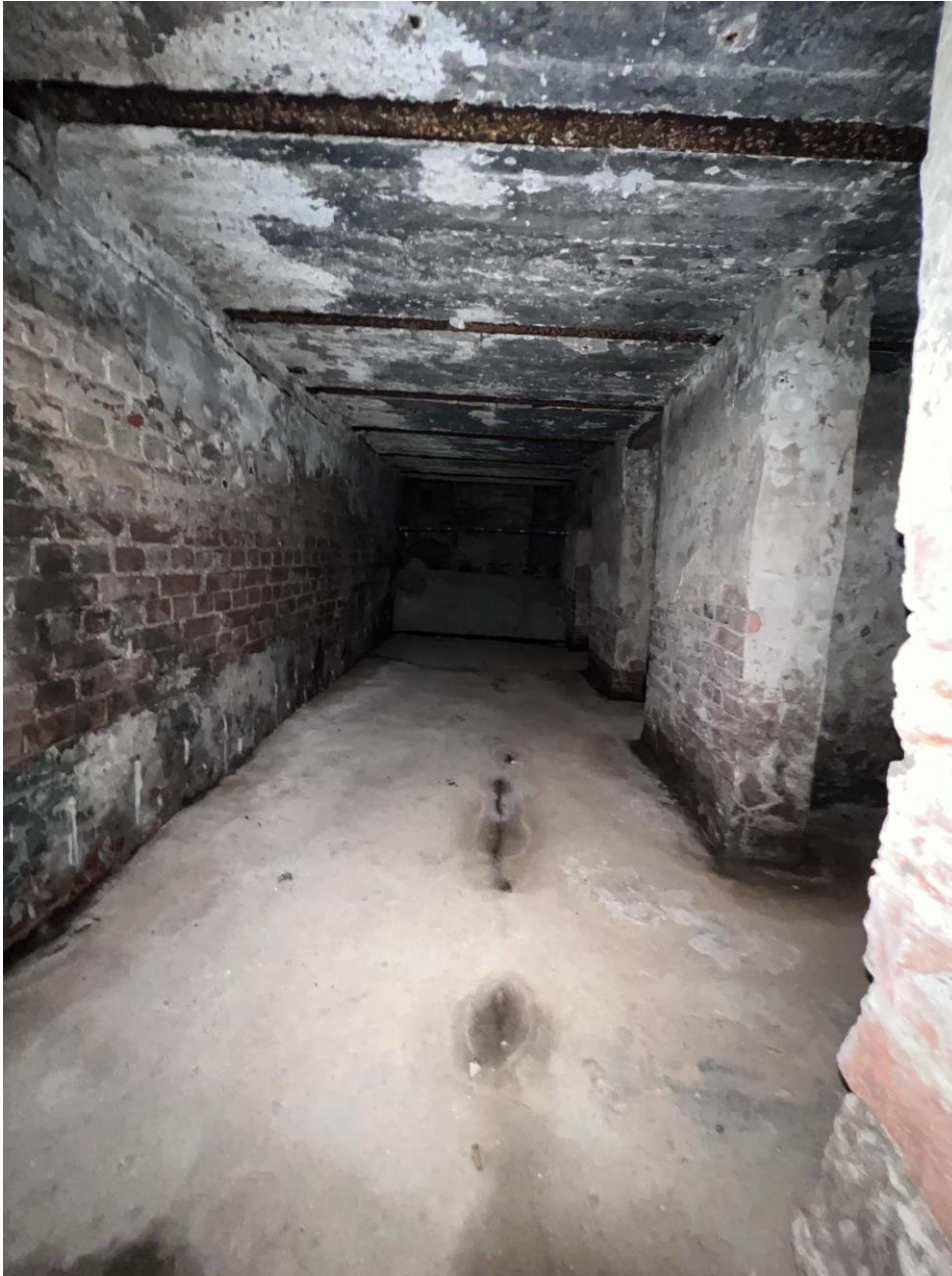
Фото 24. Пом. 11. Общий вид помещения с северо-востока. Дата съемки: 19.05.2022 г. Автор съемки: Куваева Ю.П.
