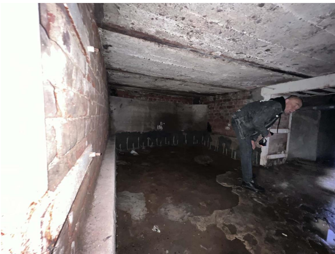
Фото 33. Пом. 19. Общий вид помещения с юга. Дата съемки: 19.05.2022 г. Автор съемки: Куваева Ю.П.
