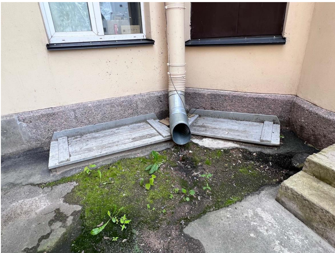
Фото 6. Защитные приямки в западном углу у северо-восточного дворового фасада северо-западной части здания. Дата съемки: 19.05.2022 г. Автор съемки: Куваева Ю.П.
