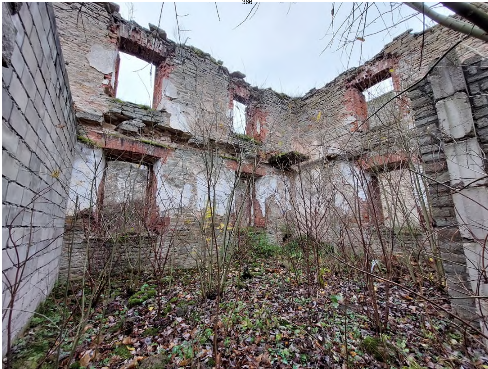
27 Выявленный ОКН «Большой Амбар» в составе ОКН федерального значения «Ансамбль Ивангородской крепости» по адресу: Ленинградская область, Кингисеппский район, г. Ивангород, Девичья Гора, литера Ж. Интерьер. Вид на южную и западную наружные стены. Дата съемки: 14.10.2022 г.
