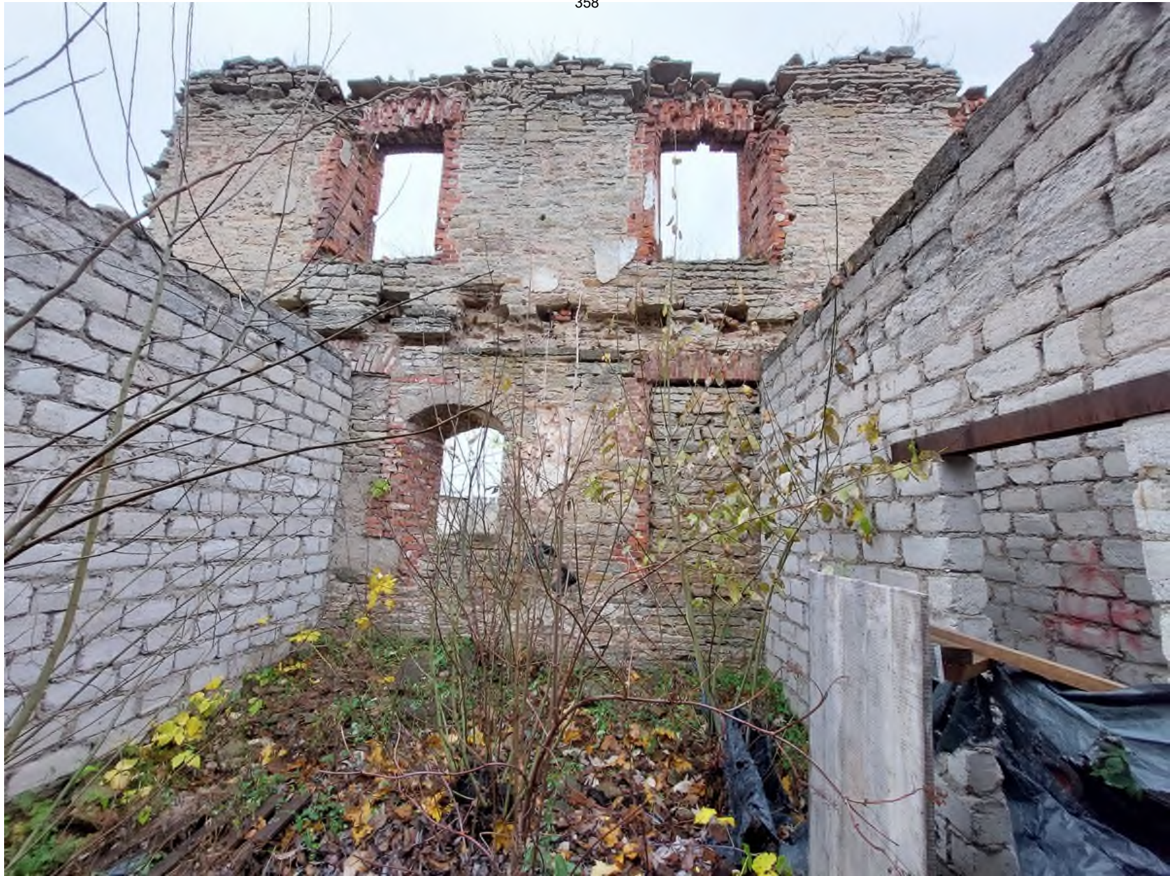
19 Выявленный ОКН «Большой Амбар» в составе ОКН федерального значения «Ансамбль Ивангородской крепости» по адресу: Ленинградская область, Кингисеппский район, г. Ивангород, Девичья Гора, литера Ж. Интерьер. Вид на северную наружную стену. Дата съемки: 14.10.2022 г.
