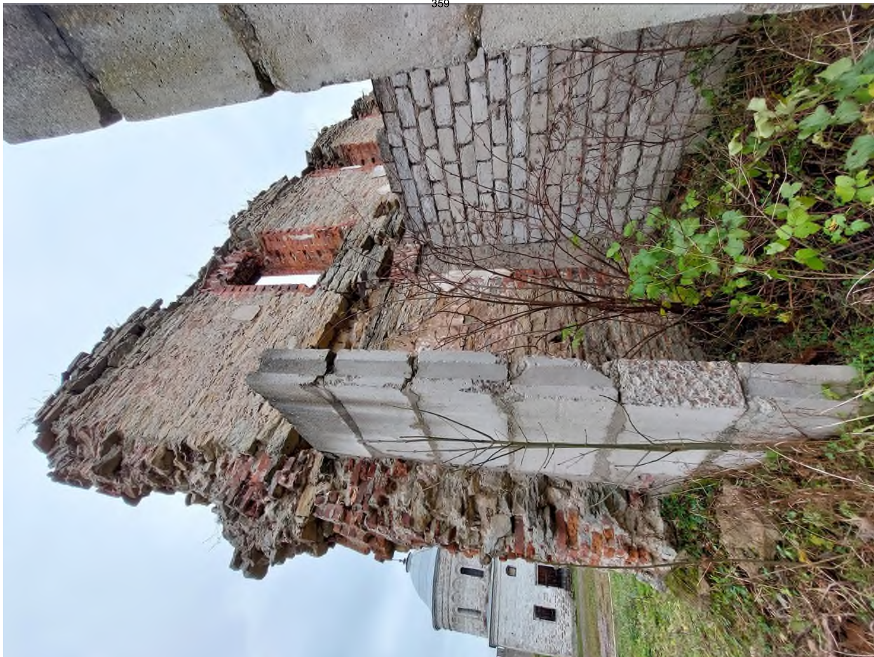
20 Выявленный ОКН «Большой Амбар» в составе ОКН федерального значения «Ансамбль Ивангородской крепости» по адресу: Ленинградская область, Кингисеппский район, г. Ивангород, Девичья Гора, литера Ж. Интерьер. Вид на северную наружную стену. Дата съемки: 14.10.2022 г.
