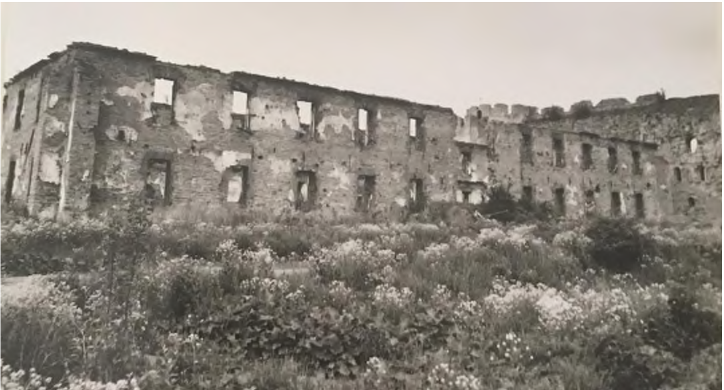
Илл. 49. Ивангород. Вид на северный фасад. 1985 г. [1.1.2]
