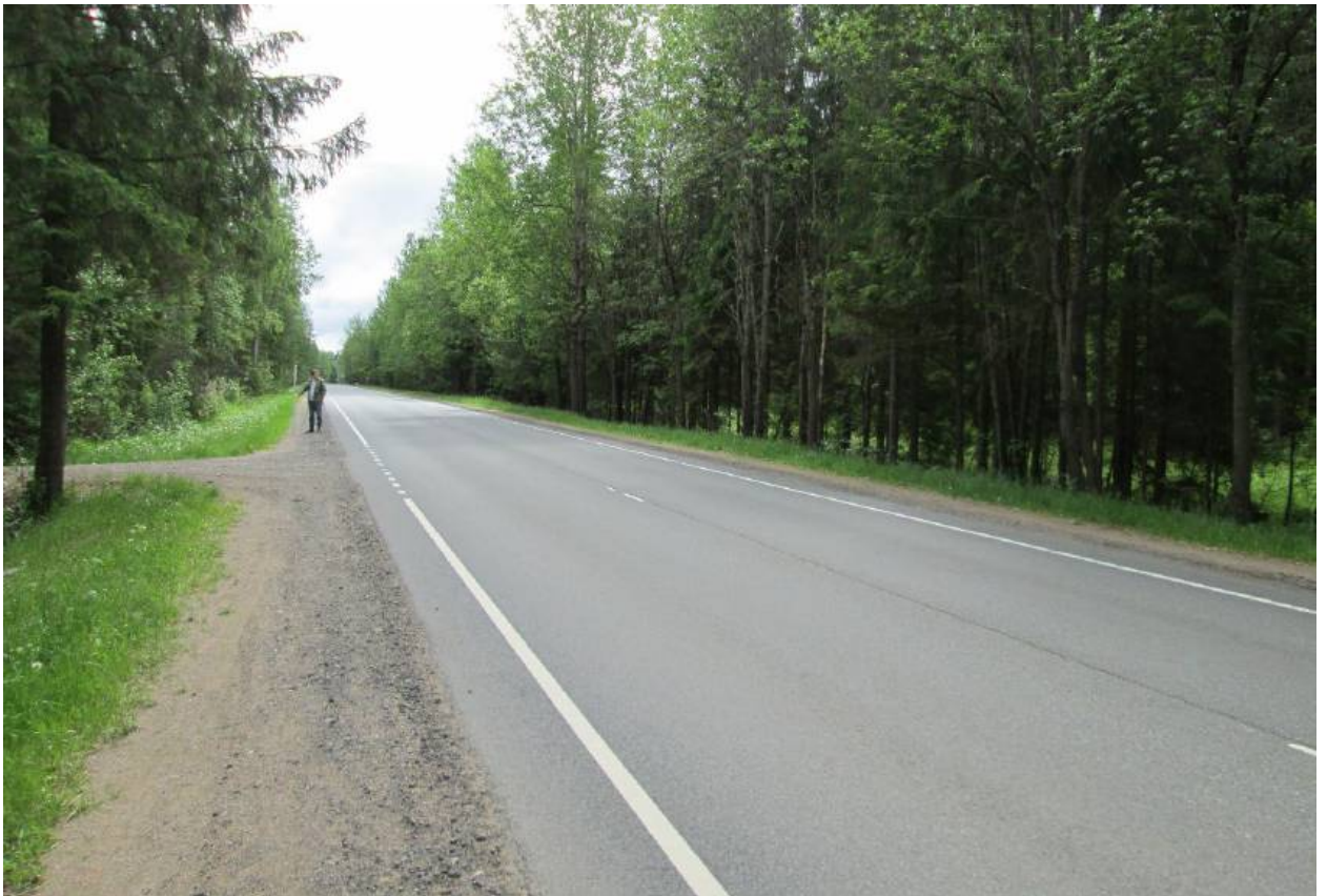
Илл. 27. Ленинградская область, Всеволожский район. Трасса проектируемой реконструкции автомобильной дороги А-181. Точка фотофиксации ФЗ. Вид с северо-запада. Для масштаба использована нивелировочная рейка длиной 2 м.
