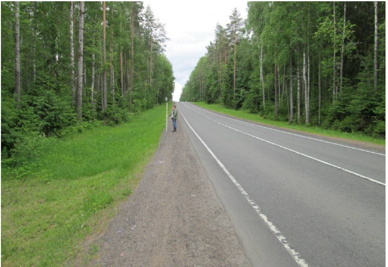
Илл. 67. Ленинградская область, Всеволожский район. Трасса проектируемой реконструкции автомобильной дороги А-181. Точка фотофиксации Ф18. Вид с северо-запада. Для масштаба использована нивелировочная рейка длиной 2 м.
