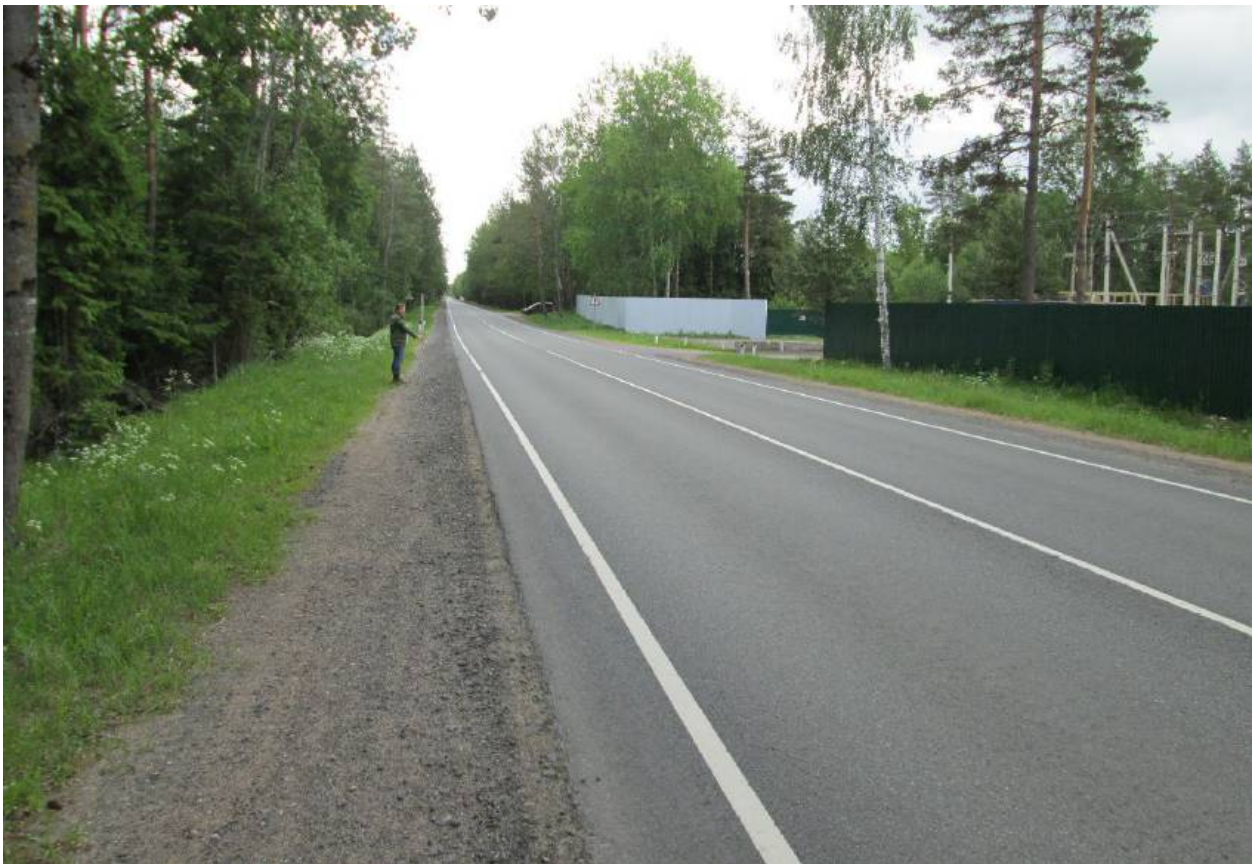
Илл. 34. Ленинградская область, Всеволожский район. Трасса проектируемой реконструкции автомобильной дороги А-181. Точка фотофиксации Ф4. Общий вид с северо-запада.
