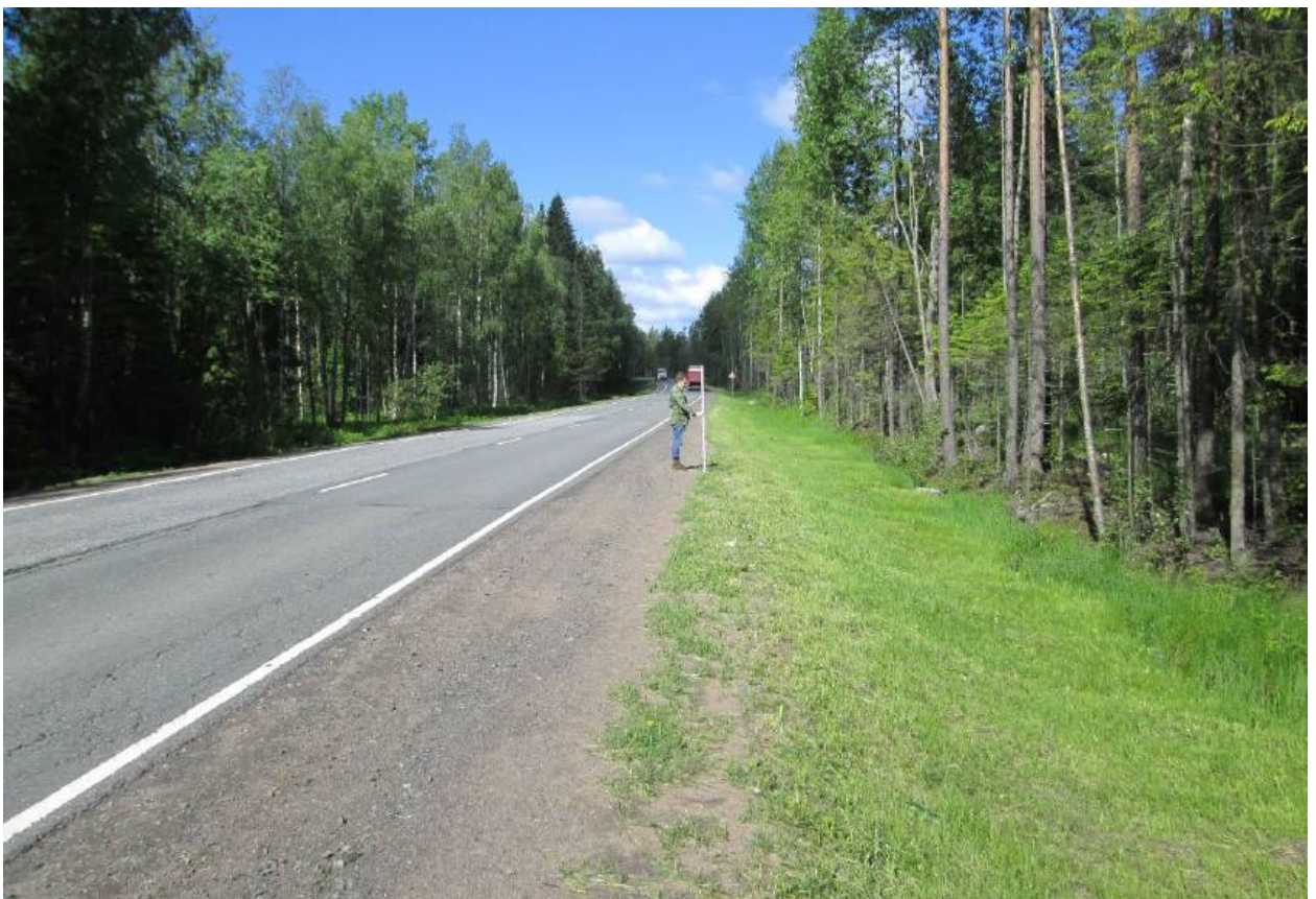
Илл. 128. Ленинградская область, Всеволожский район. Трасса проектируемой реконструкции автомобильной дороги А-181. Точка фотофиксации Ф33. Вид с востока. Для масштаба использована нивелировочная рейка длиной 2 м.
