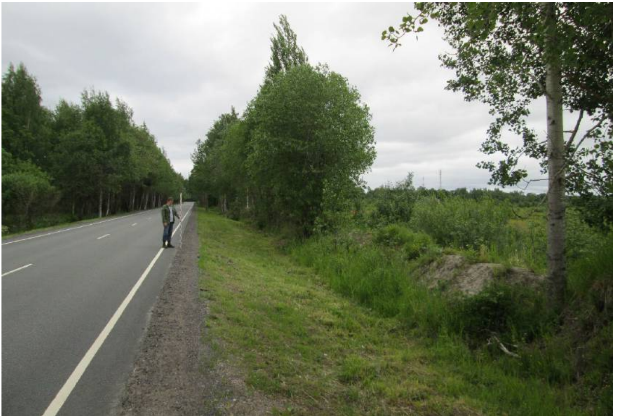
Илл. 17. Ленинградская область, Всеволожский район. Трасса проектируемой реконструкции автомобильной дороги А-181. Точка фотофиксации Ф1. Вид с востока. Для масштаба использована рейка длиной 2 м.
