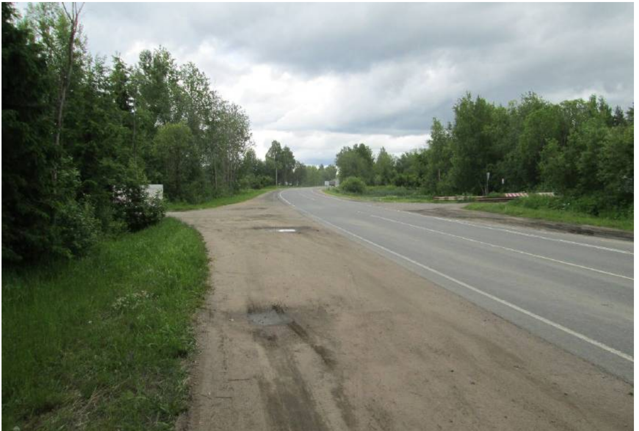
Илл. 63. Ленинградская область, Всеволожский район. Трасса проектируемой реконструкции автомобильной дороги А-181. Точка фотофиксации Ф16. Общий вид с северо-востока.
