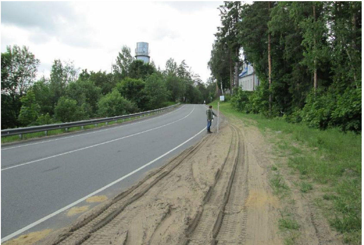
Илл. 53. Ленинградская область, Всеволожский район. Трасса проектируемой реконструкции автомобильной дороги А-181. Точка фотофиксации 11. Вид с востока. Для масштаба использована нивелировочная рейка длиной 2 м.
