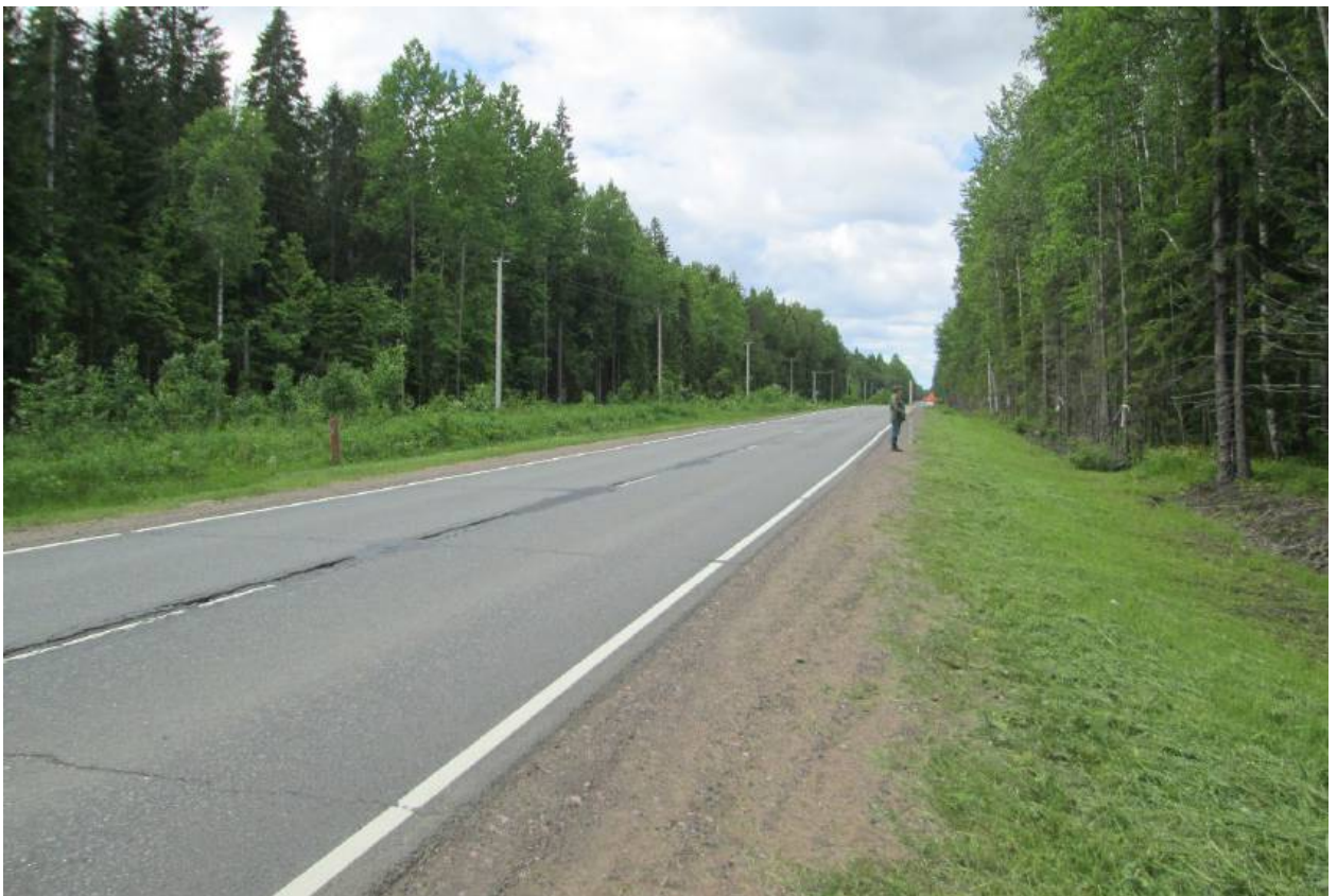
Илл. 150. Ленинградская область, Всеволожский район. Трасса проектируемой реконструкции автомобильной дороги А-181. Точка фотофиксации Ф36. Вид с востока. Для масштаба использована нивелировочная рейка длиной 2 м.
