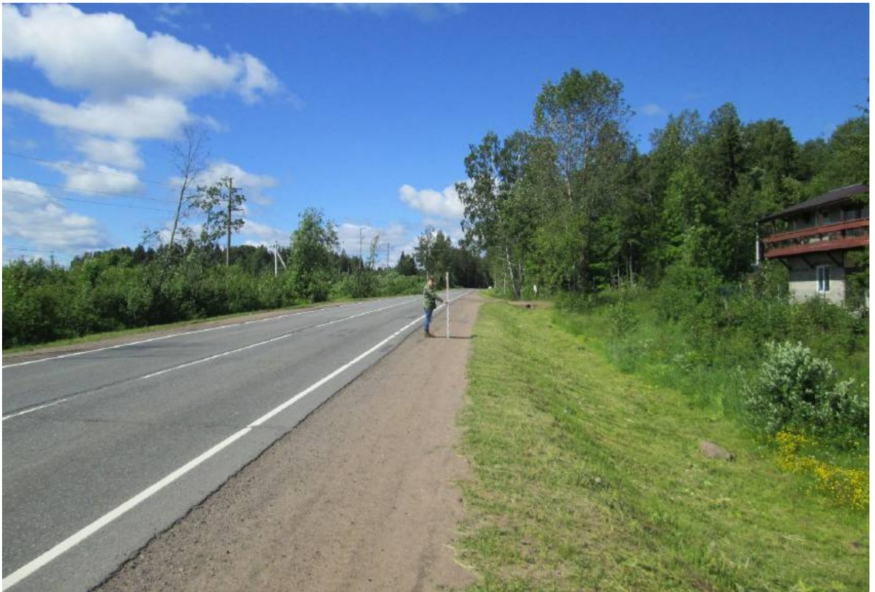
Илл. 119. Ленинградская область, Всеволожский район. Трасса проектируемой реконструкции автомобильной дороги А-181. Точка фотофиксации 31. Вид с северо-востока. Для масштаба использована нивелировочная рейка длиной 2 м.
