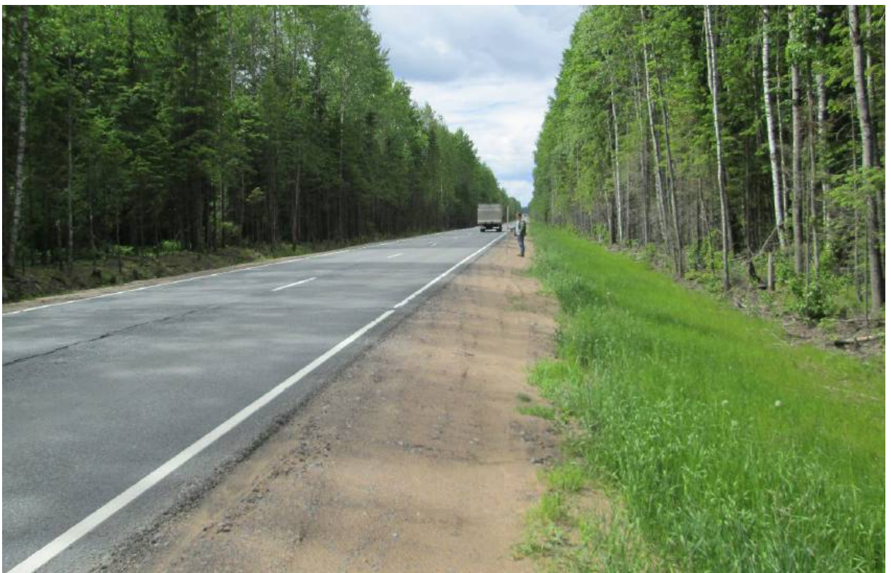
Илл. 156. Ленинградская область, Всеволожский район. Трасса проектируемой реконструкции автомобильной дороги А-181. Точка фотофиксации Ф37. Вид с востока. Для масштаба использована нивелировочная рейка длиной 2 м.
