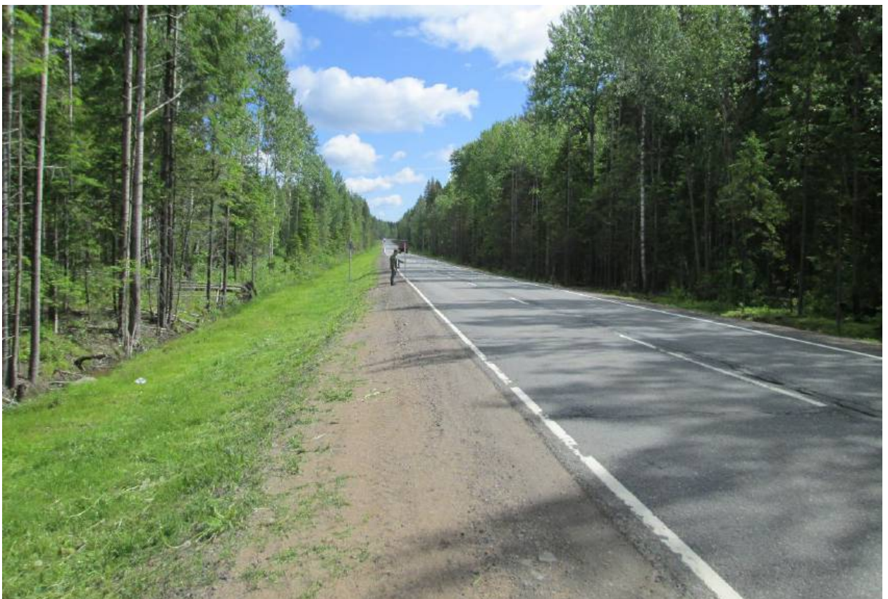
Илл. 136. Ленинградская область, Всеволожский район. Трасса проектируемой реконструкции автомобильной дороги А-181. Точка фотофиксации Ф34. Вид с запада. Для масштаба использована нивелировочная рейка длиной 2 м.
