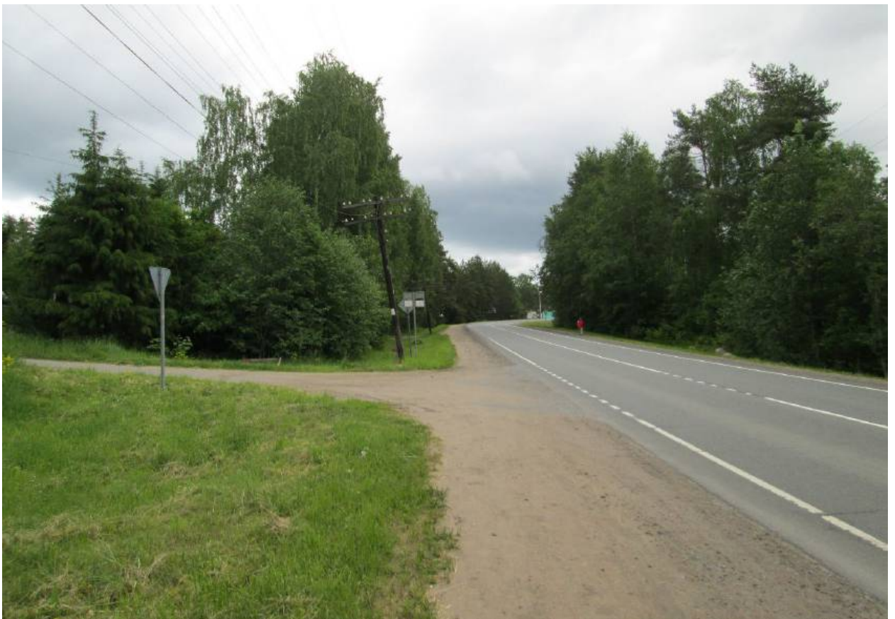
Илл. 102. Ленинградская область, Всеволожский район. Трасса проектируемой реконструкции автомобильной дороги А-181. Точка фотофиксации Ф23. Общий вид с запада.
