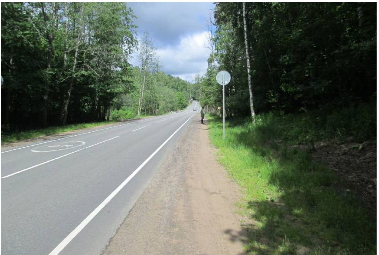
Илл. 42. Ленинградская область, Всеволожский район. Трасса проектируемой реконструкции автомобильной дороги А-181. Точка фотофиксации Ф6. Для масштаба использована нивелировочная рейка длиной 2 м.
