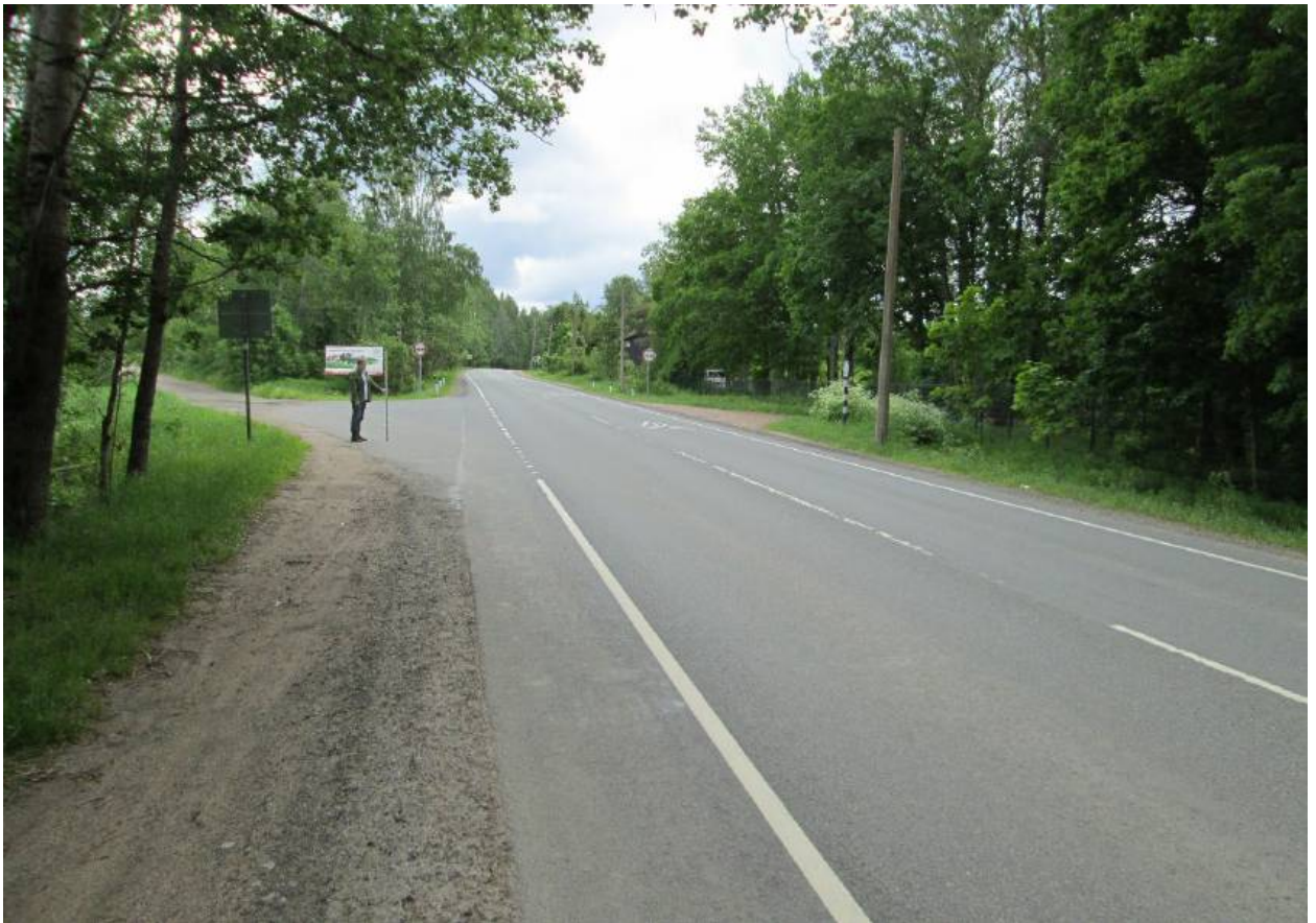
Илл. 47. Ленинградская область, Всеволожский район. Трасса проектируемой реконструкции автомобильной дороги А-181. Точка фотофиксации Ф8. Вид с северо-запада. Для масштаба использована нивелировочная рейка длиной 2 м.
