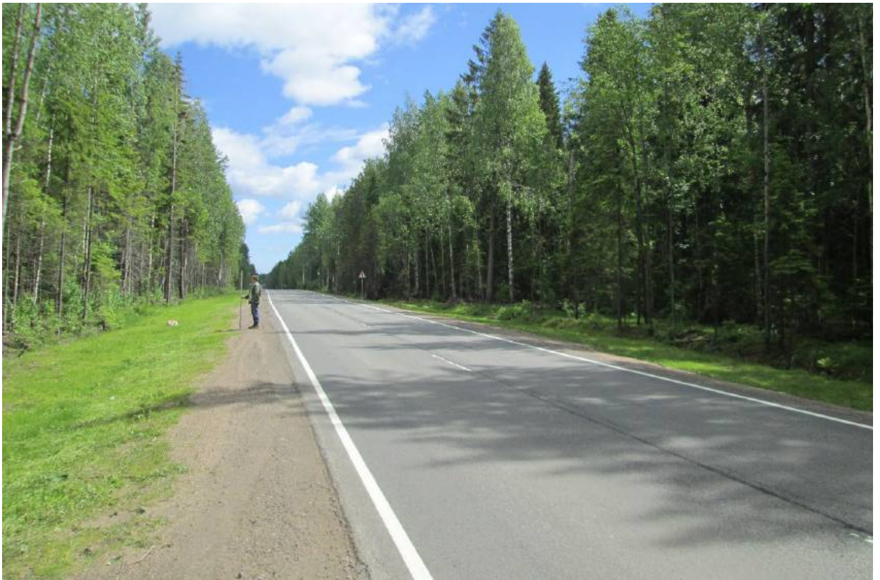
Илл. 143. Ленинградская область, Всеволожский район. Трасса проектируемой реконструкции автомобильной дороги А-181. Точка фотофиксации Ф35. Вид с запада. Для масштаба использована нивелировочная рейка длиной 2 м.
