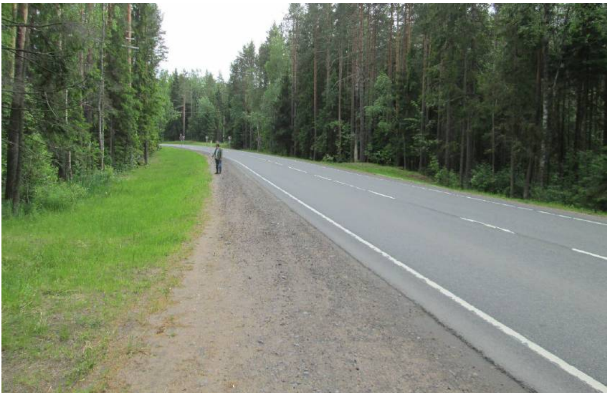
Илл. 74. Ленинградская область, Всеволожский район. Трасса проектируемой реконструкции автомобильной дороги А-181. Точка фотофиксации Ф19. Вид с северо-запада. Для масштаба использована нивелировочная рейка длиной 2 м.
