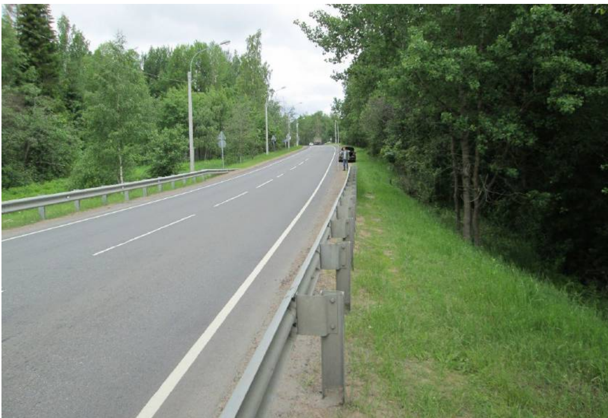
Илл. 23. Ленинградская область, Всеволожский район. Трасса проектируемой реконструкции автомобильной дороги А-181. Точка фотофиксации Ф2. Вид трассы обследования в районе перехода р. Авлога. Вид с юго-востока. Для масштаба использована нивелировочная рейка длиной 2 м.
