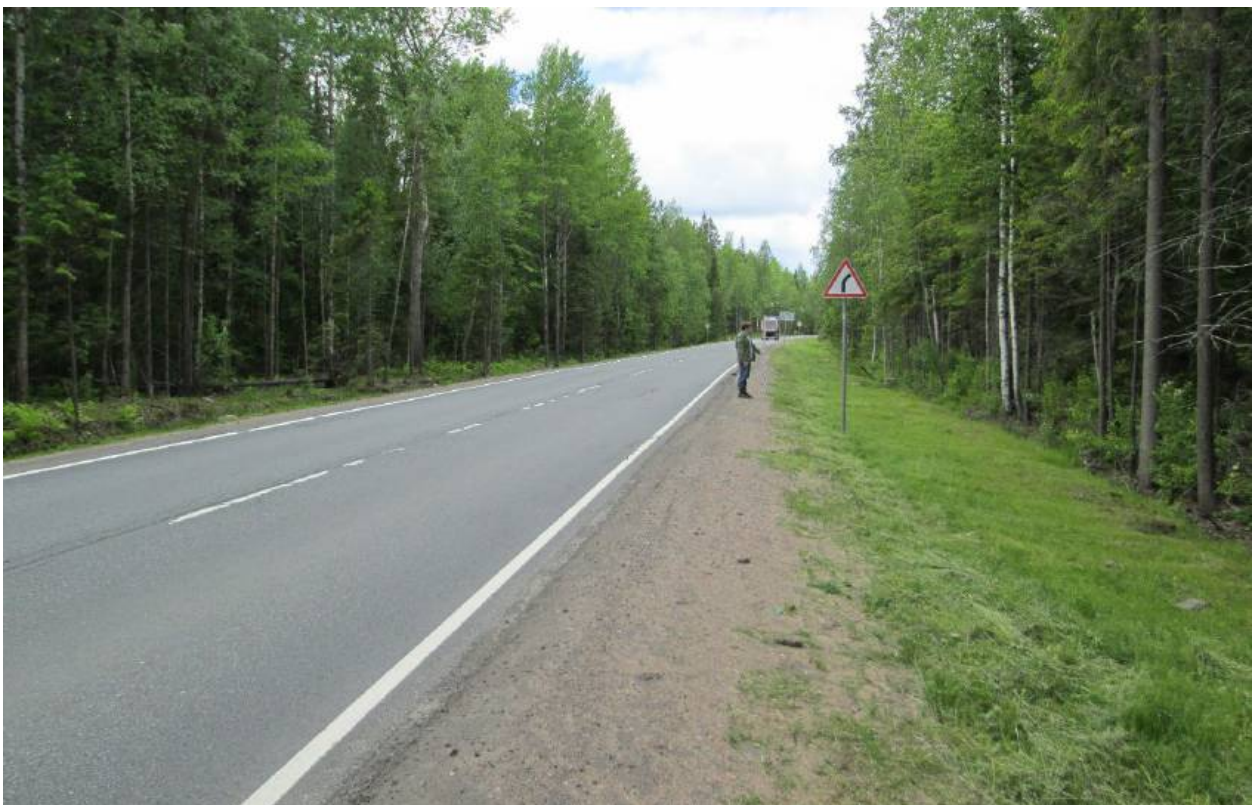
Илл. 142. Ленинградская область, Всеволожский район. Трасса проектируемой реконструкции автомобильной дороги А-181. Точка фотофиксации Ф35. Вид с востока. Для масштаба использована нивелировочная рейка длиной 2 м.
