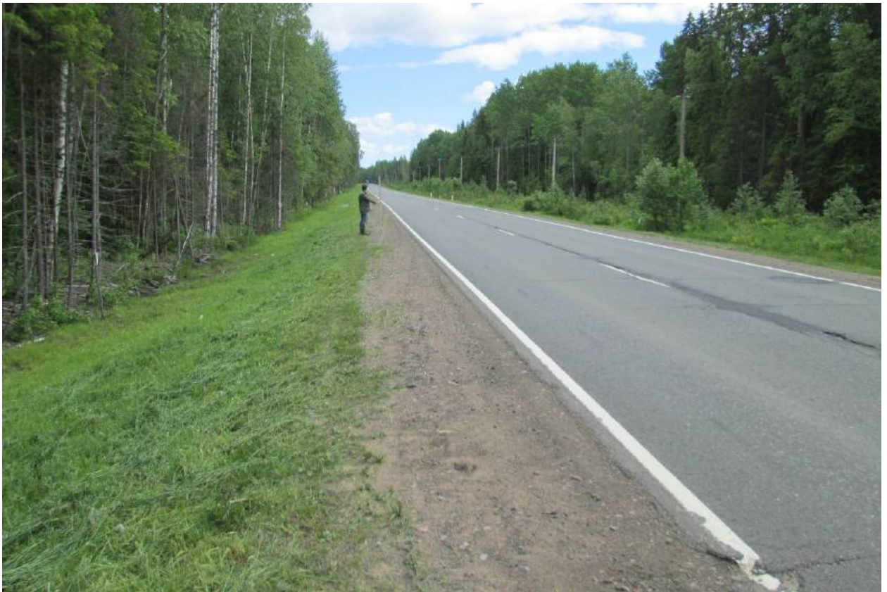
Илл. 149. Ленинградская область, Всеволожский район. Трасса проектируемой реконструкции автомобильной дороги А-181. Точка фотофиксации Ф36. Вид с запада. Для масштаба использована нивелировочная рейка длиной 2 м.
