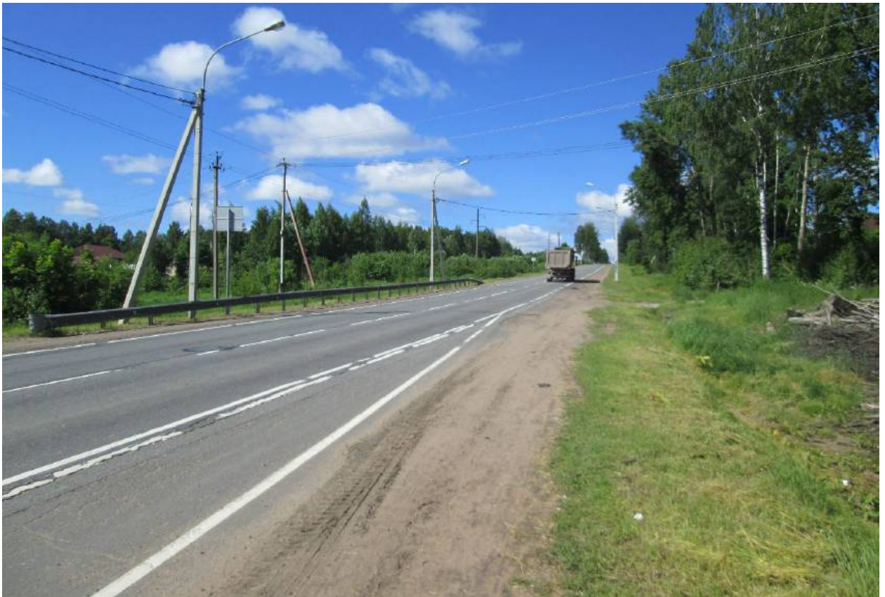
Илл. 117. Ленинградская область, Всеволожский район. Трасса проектируемой реконструкции автомобильной дороги А-181. Точка фотофиксации Ф30. Общий вид с северо-востока.
