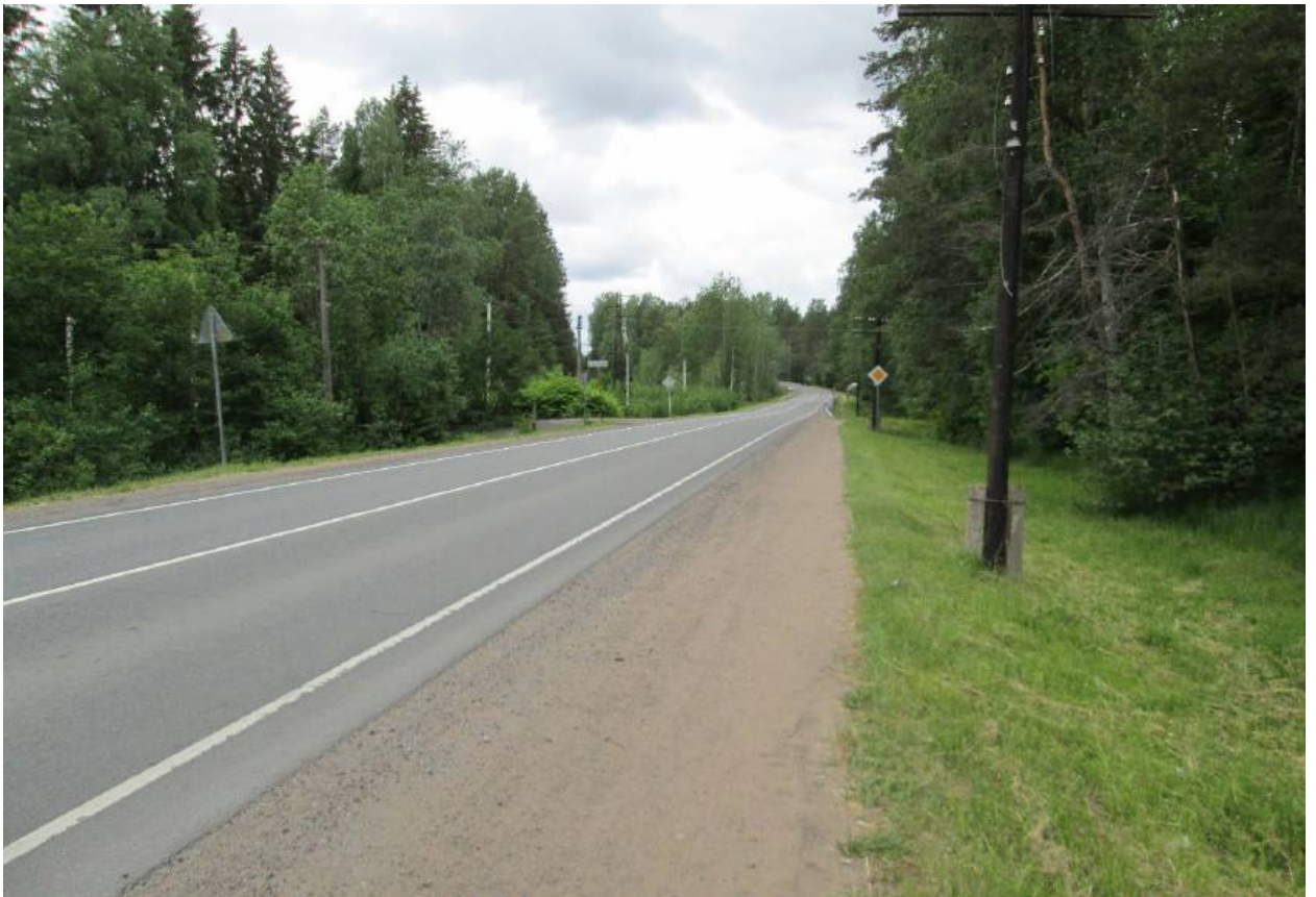
Илл. 101. Ленинградская область, Всеволожский район. Трасса проектируемой реконструкции автомобильной дороги А-181. Точка фотофиксации Ф23. Общий вид с востока.
