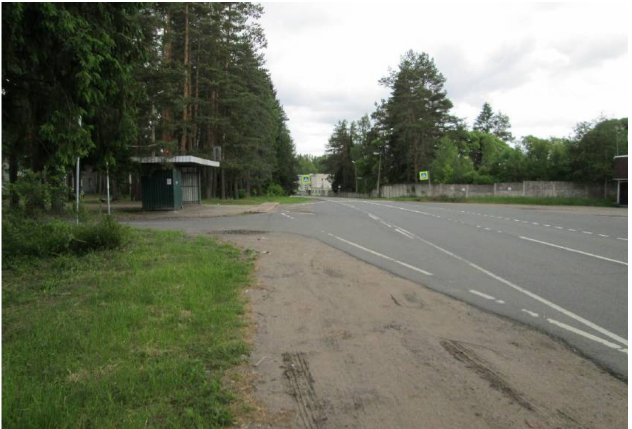
Илл. 85. Ленинградская область, Всеволожский район. Трасса проектируемой реконструкции автомобильной дороги А-181. Точка фотофиксации Ф20. Вид с северо-запада. Для масштаба использована нивелировочная рейка длиной 2 м.
