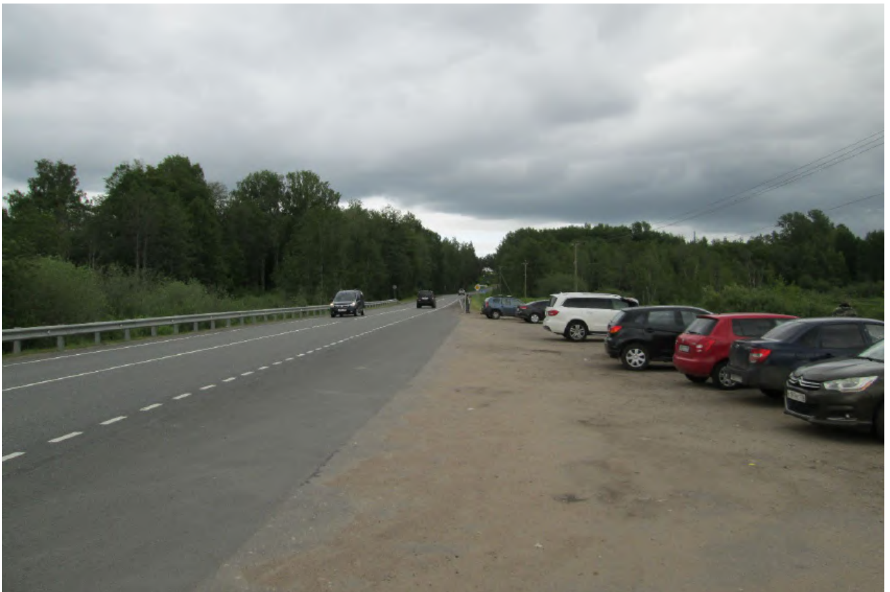
Илл. 106. Ленинградская область, Всеволожский район. Трасса проектируемой реконструкции автомобильной дороги А-181. Точка фотофиксации Ф25. Вид с юго-запада. Для масштаба использована нивелировочная рейка длиной 2 м.
