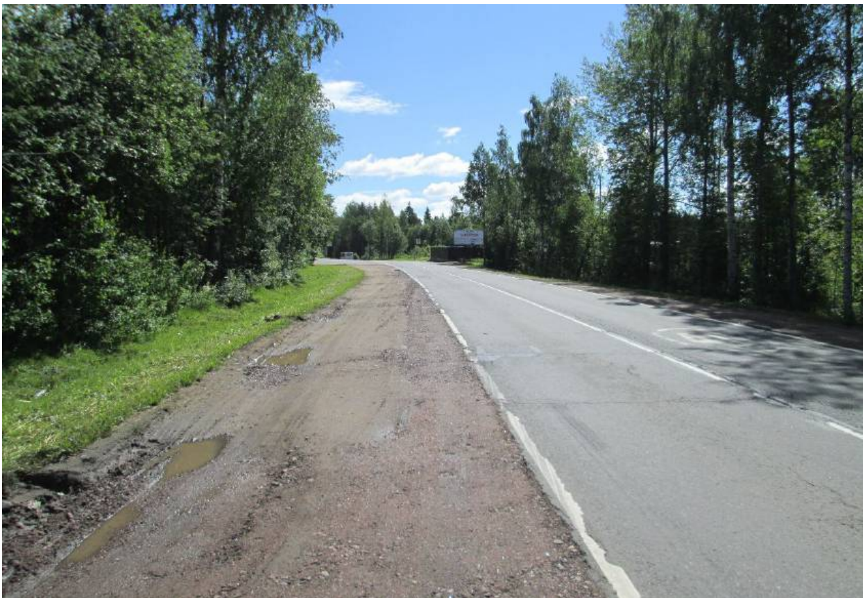
Илл. 121. Ленинградская область, Всеволожский район. Трасса проектируемой реконструкции автомобильной дороги А-181. Точка фотофиксации Ф32. Общий вид с северо-запада.
