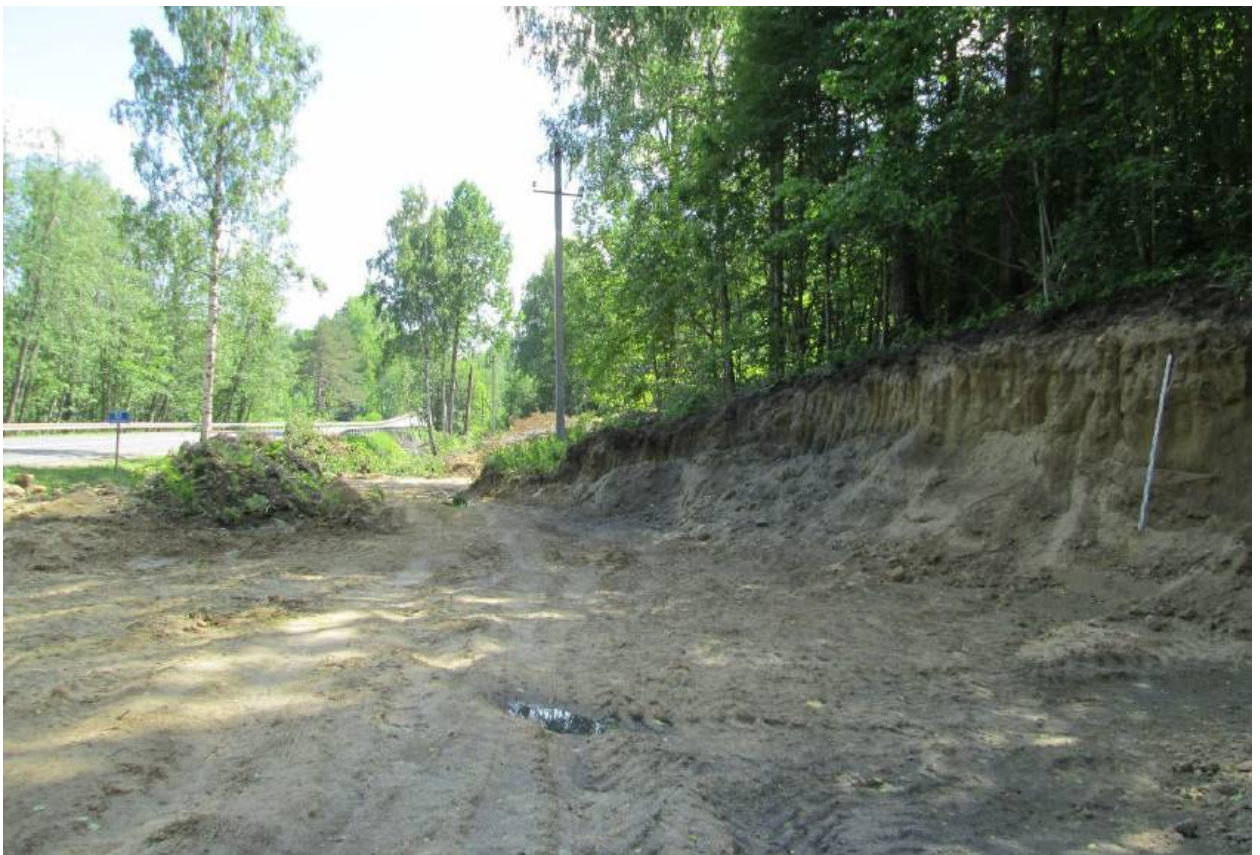
Илл. 44. Ленинградская область, Всеволожский район. Трасса проектируемой реконструкции автомобильной дороги А-181. Точка фотофиксации Ф7. Для масштаба использована нивелировочная рейка длиной 2 м.
