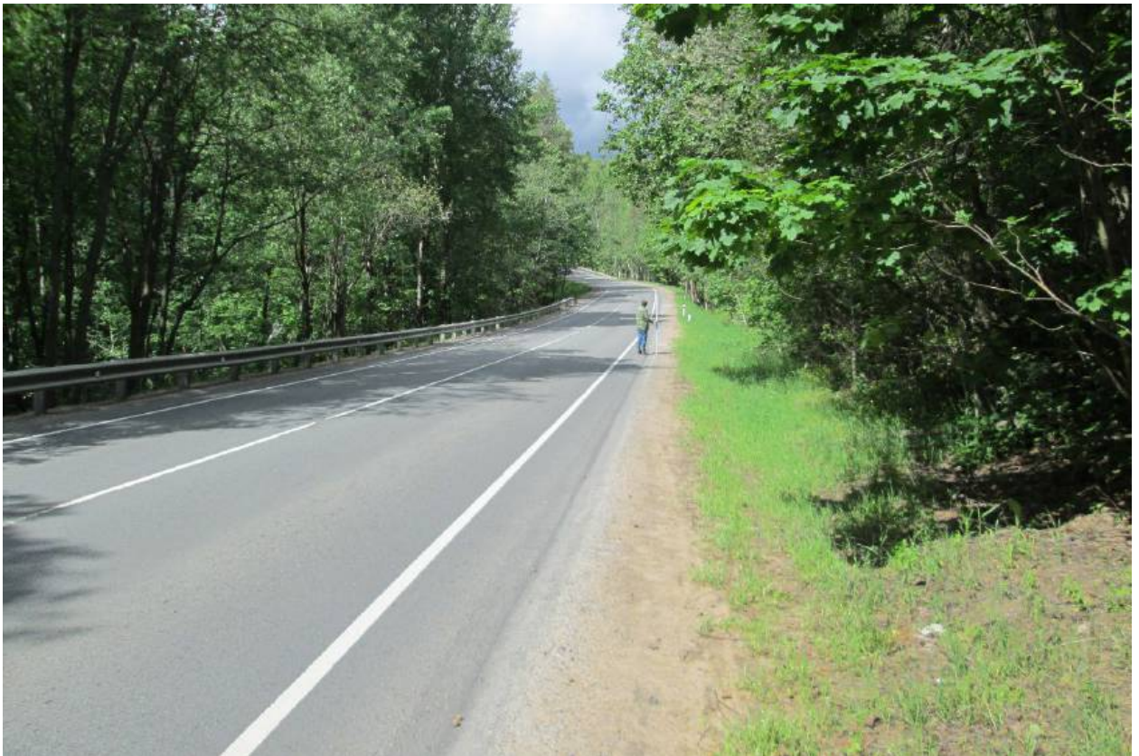
Илл. 51. Ленинградская область, Всеволожский район. Трасса проектируемой реконструкции автомобильной дороги А-181. Точка фотофиксации Ф10. Вид с востока. Для масштаба использована нивелировочная рейка длиной 2 м.
