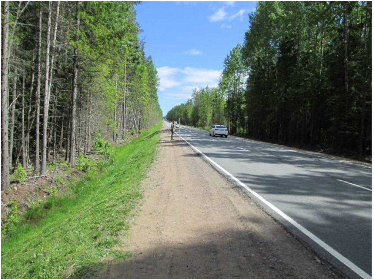
Илл. 163. Ленинградская область, Всеволожский район. Трасса проектируемой реконструкции автомобильной дороги А-181. Точка фотофиксации Ф38. Вид с запада. Для масштаба использована нивелировочная рейка длиной 2 м.
