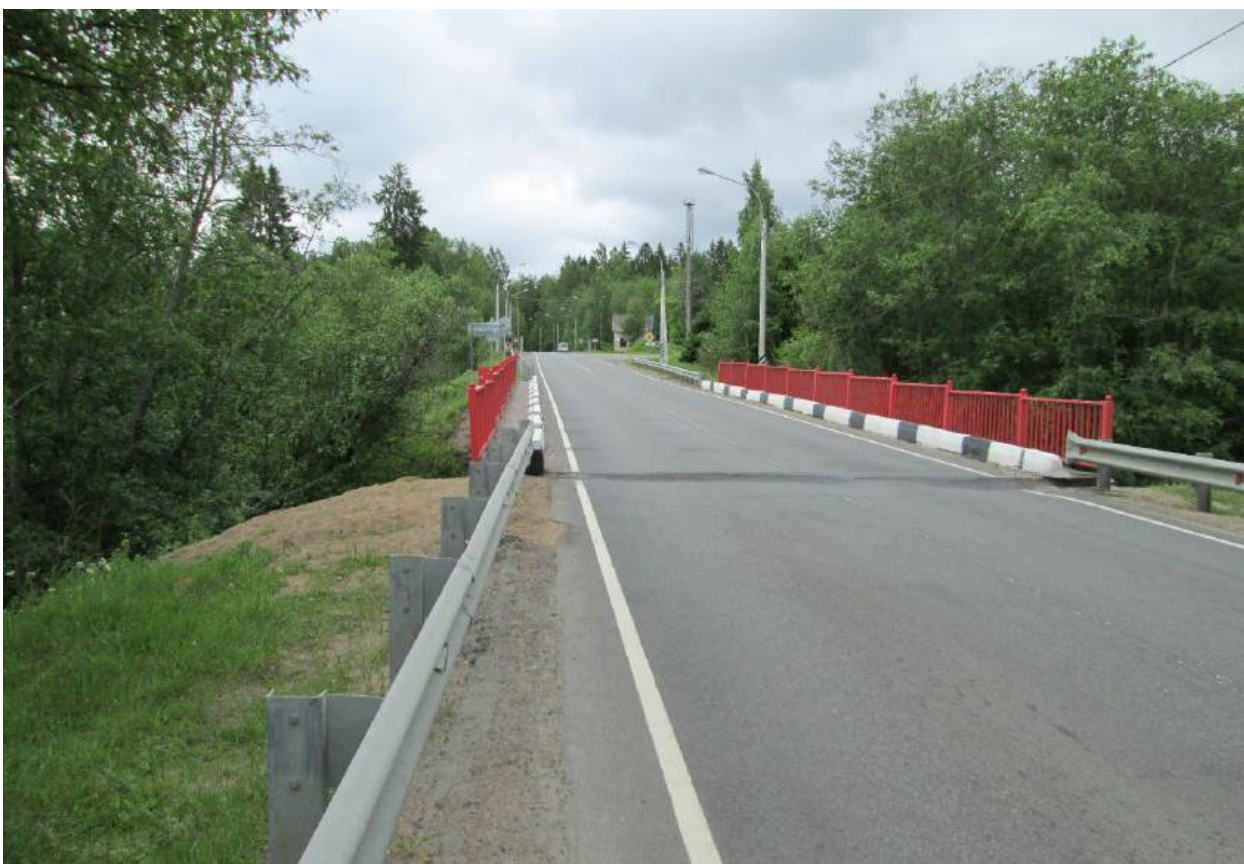
Илл. 24. Ленинградская область, Всеволожский район. Трасса проектируемой реконструкции автомобильной дороги А-181. Точка фотофиксации Ф2. Вид трассы обследования в районе перехода р. Авлога. Общий вид с северо-запада.
