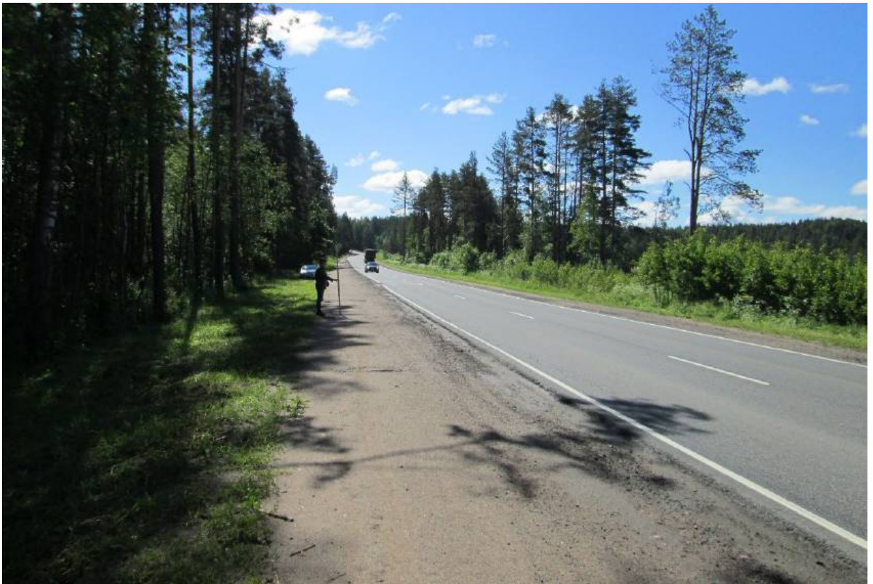
Илл. 115. Ленинградская область, Всеволожский район. Трасса проектируемой реконструкции автомобильной дороги А-181. Точка фотофиксации Ф29. Вид с северо-запада. Для масштаба использована нивелировочная рейка длиной 2 м.
