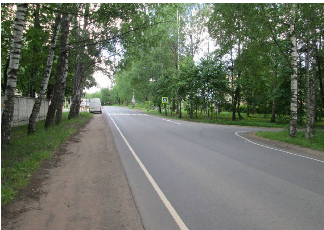
Илл. 56. Ленинградская область, Всеволожский район. Трасса проектируемой реконструкции автомобильной дороги А-181. Точка фотофиксации Ф12. Общий вид с запада.
