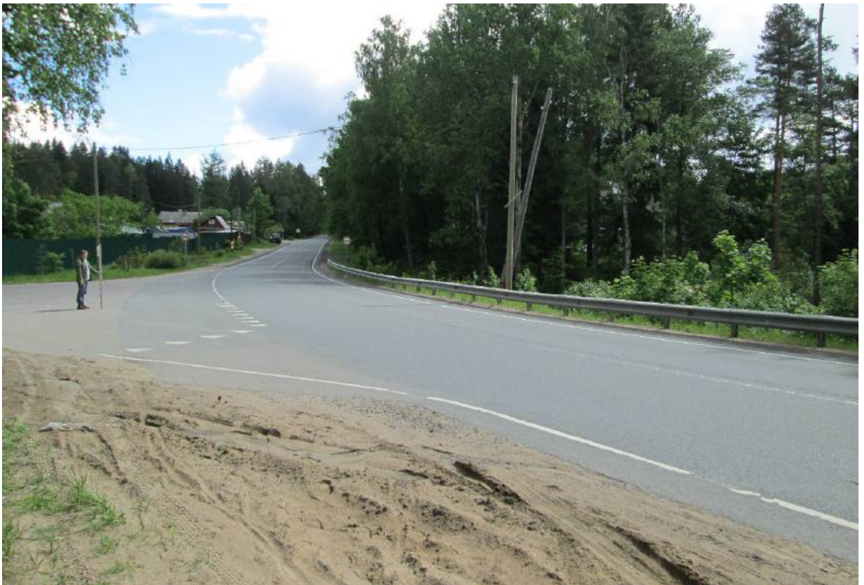
Илл. 54. Ленинградская область, Всеволожский район. Трасса проектируемой реконструкции автомобильной дороги А-181. Точка фотофиксации Ф11. Вид с запада. Для масштаба использована нивелировочная рейка длиной 2 м.
