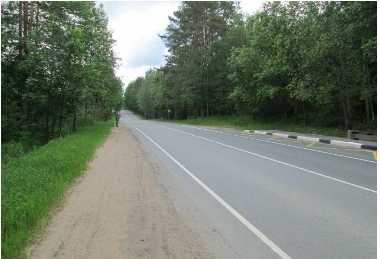
Илл. 49. Ленинградская область, Всеволожский район. Трасса проектируемой реконструкции автомобильной дороги А-181. Точка фотофиксации Ф9. Вид с северо-запада.
