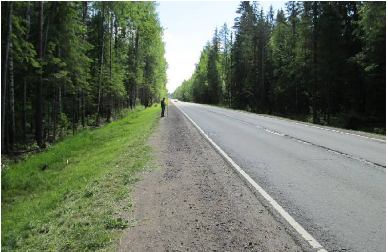
Илл. 129. Ленинградская область, Всеволожский район. Трасса проектируемой реконструкции автомобильной дороги А-181. Точка фотофиксации Ф33. Вид с запада. Для масштаба использована нивелировочная рейка длиной 2 м.
