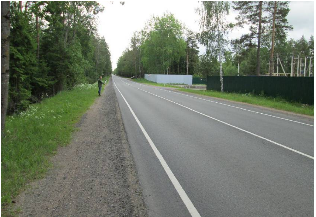
Илл. 43. Ленинградская область, Всеволожский район. Трасса проектируемой реконструкции автомобильной дороги А-181. Точка фотофиксации Ф6. Для масштаба использована нивелировочная рейка длиной 2 м.
