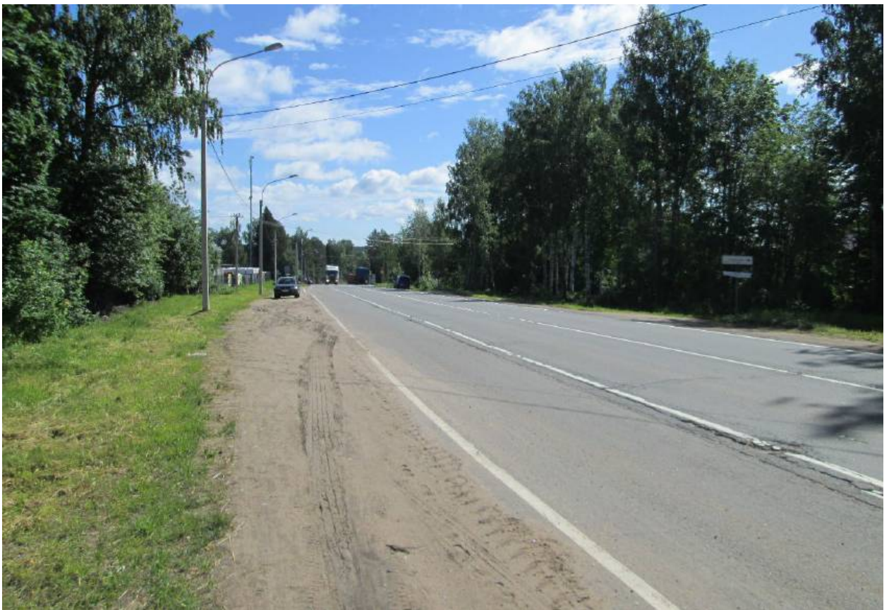
Илл. 118. Ленинградская область, Всеволожский район. Трасса проектируемой реконструкции автомобильной дороги А-181. Точка фотофиксации Ф30. Общий вид с юго-запада.
