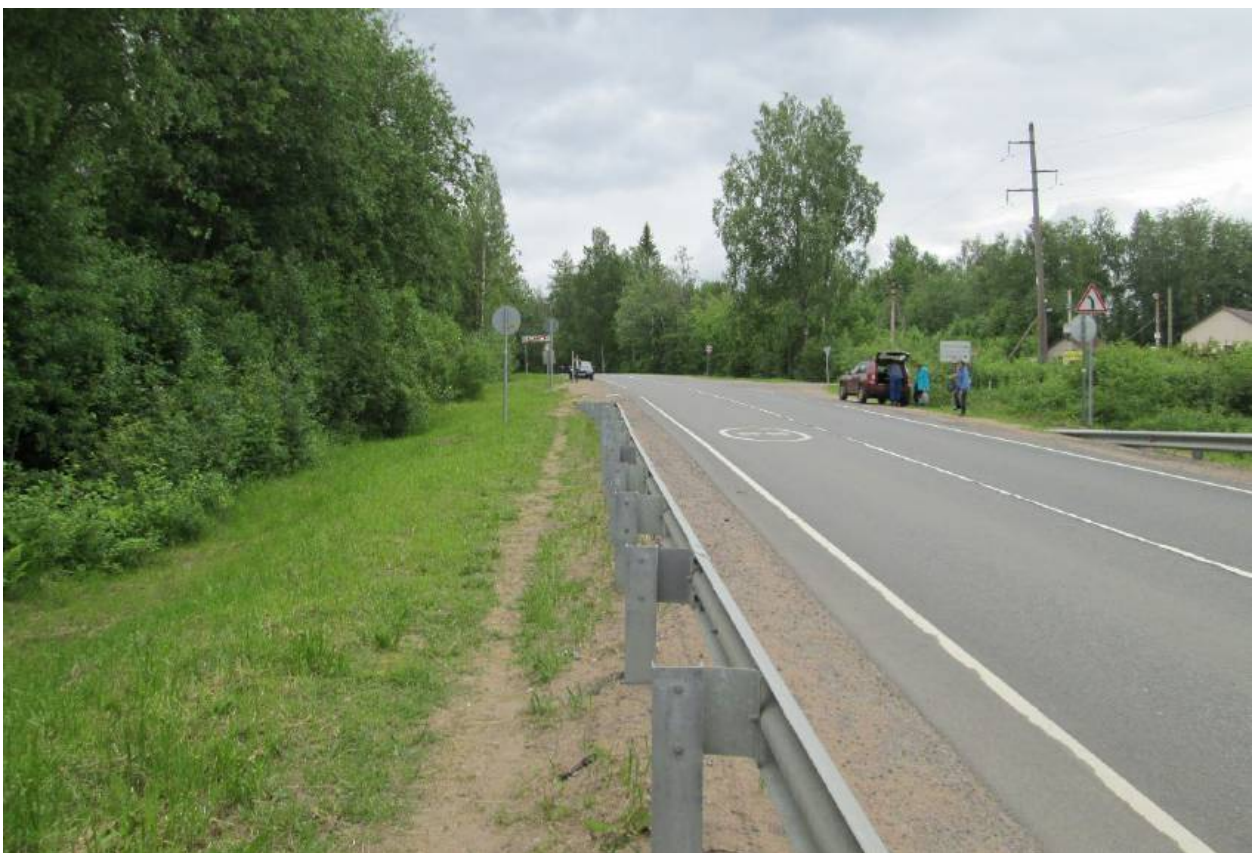
Илл. 96. Ленинградская область, Всеволожский район. Трасса проектируемой реконструкции автомобильной дороги А-181. Точка фотофиксации Ф21. Общий вид с северо-запада.
