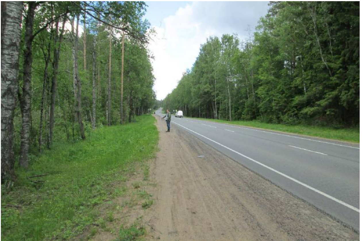
Илл. 60. Ленинградская область, Всеволожский район. Трасса проектируемой реконструкции автомобильной дороги А-181. Точка фотофиксации Ф14. Вид с юго-запада. Для масштаба использована нивелировочная рейка длиной 2 м.
