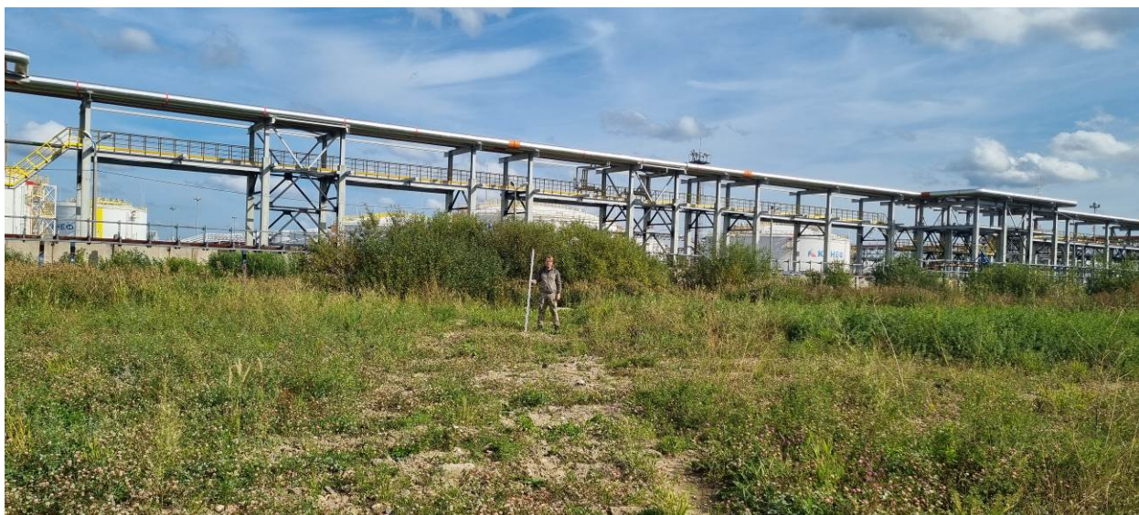
Рис. 10. Ленинградская область-2022. Киришский район. Участок обследования. Точка фотофиксации 1. Вид с юго-запада.
