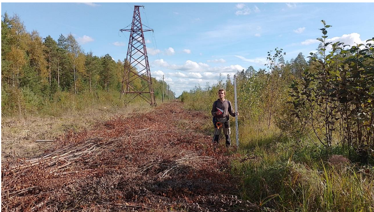
Рис. 14. Ленинградская область-2022. Киришский район. Участок обследования. Точка фотофиксации 3. Вид с юго-запада.
