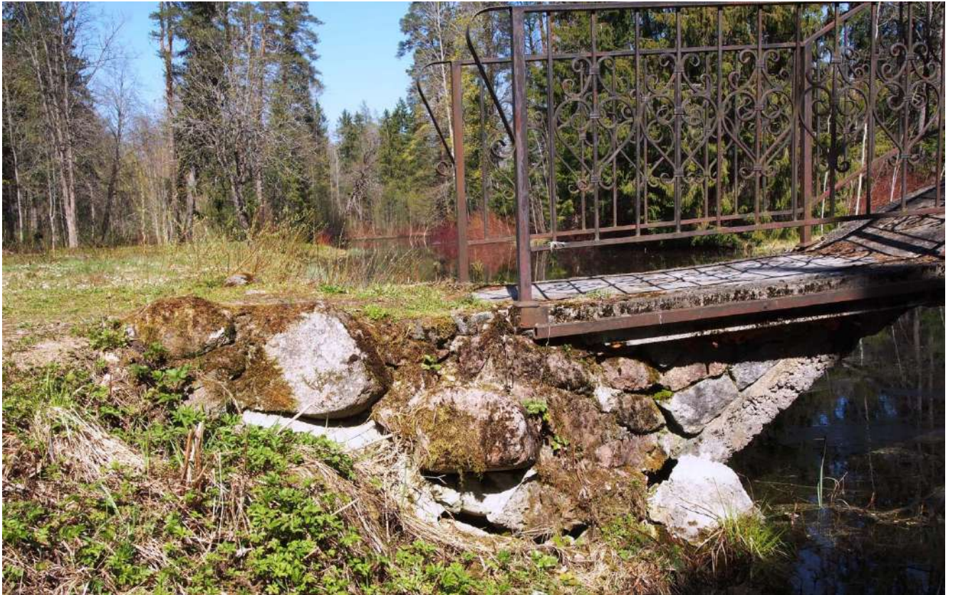
9. Фрагмент валунной кладки в опоре мостика. Вид с юга.
