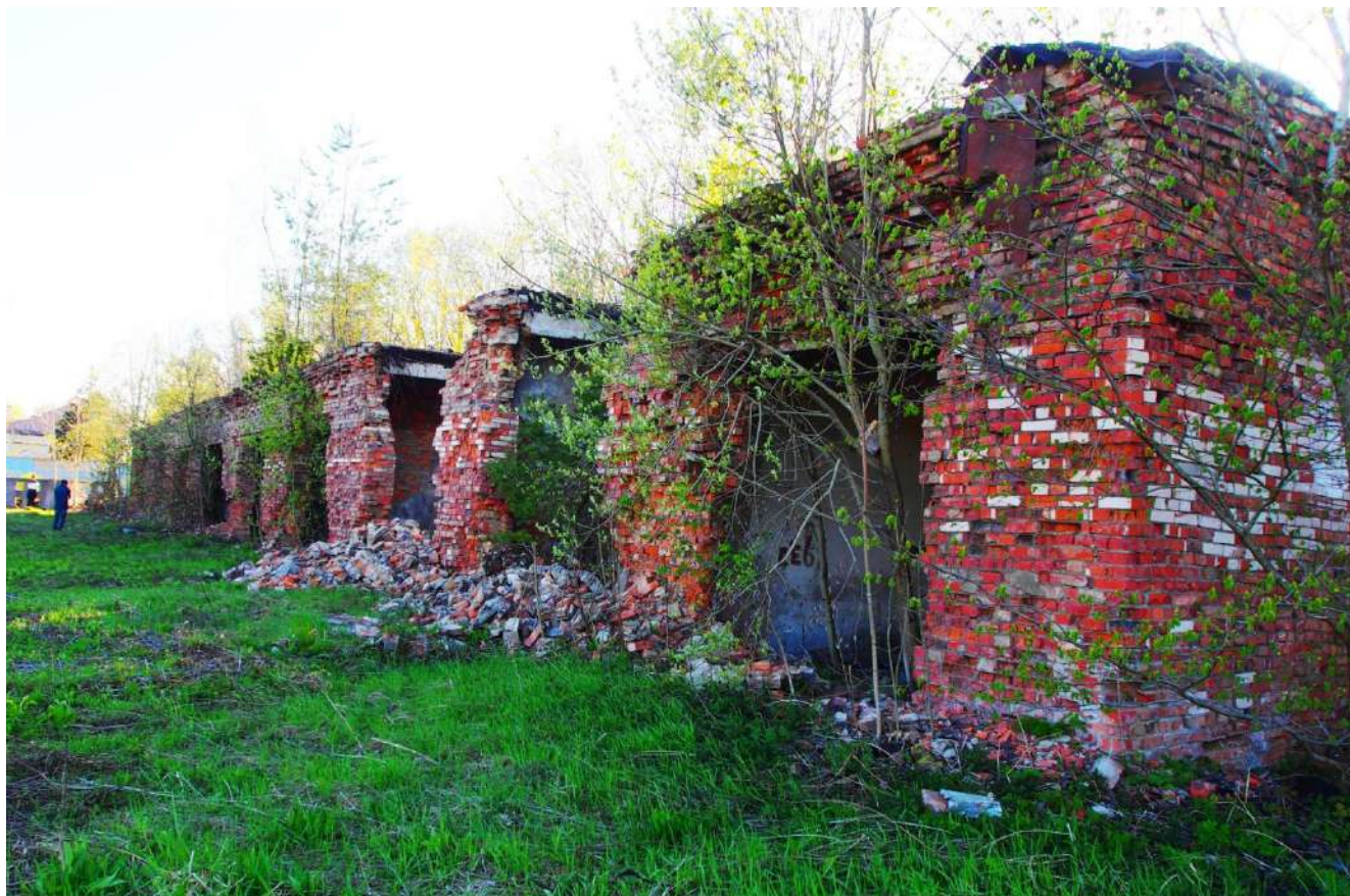
39. Конюшня. Вид с северо-востока.
