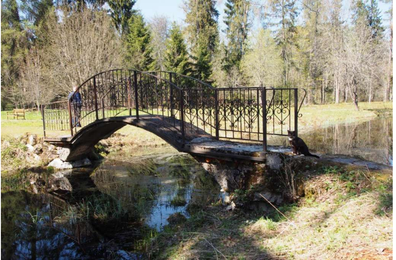
5. Мостик-горбатка в усадебном парке. Вид с юго-востока с острова.
