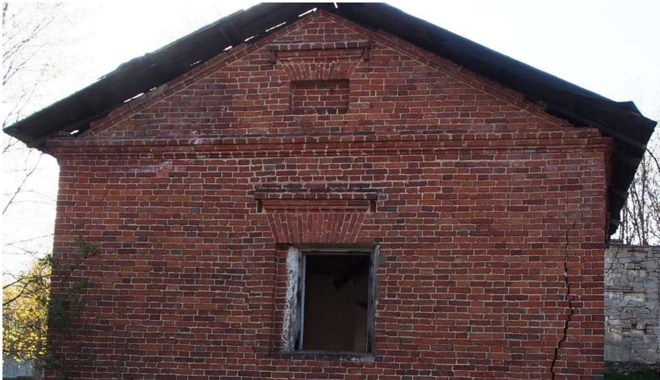
31. Баня (молочная). Фрагмент восточного фасада.
