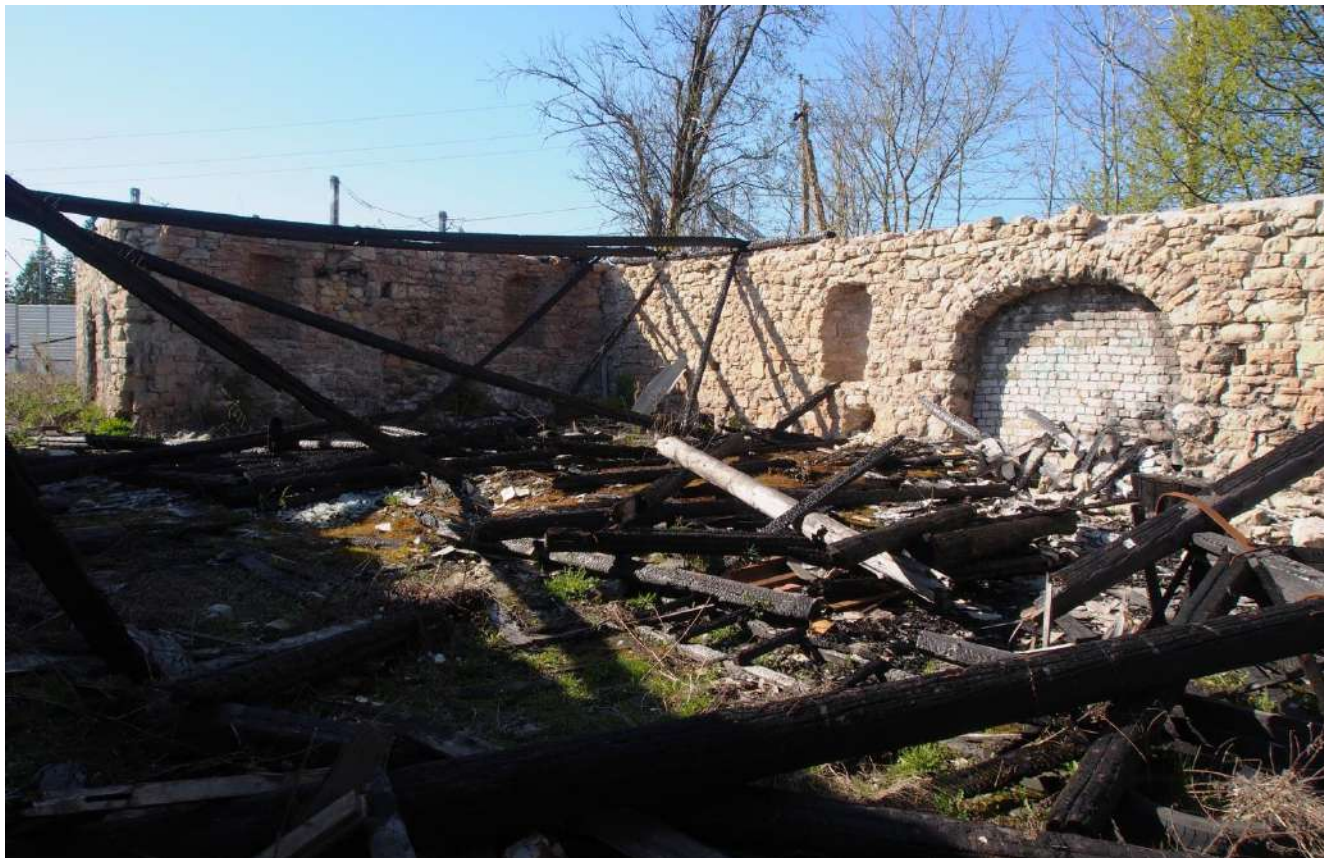
59. Рига. Проем ворот с лучковой перемычкой в стене северного фасада.
