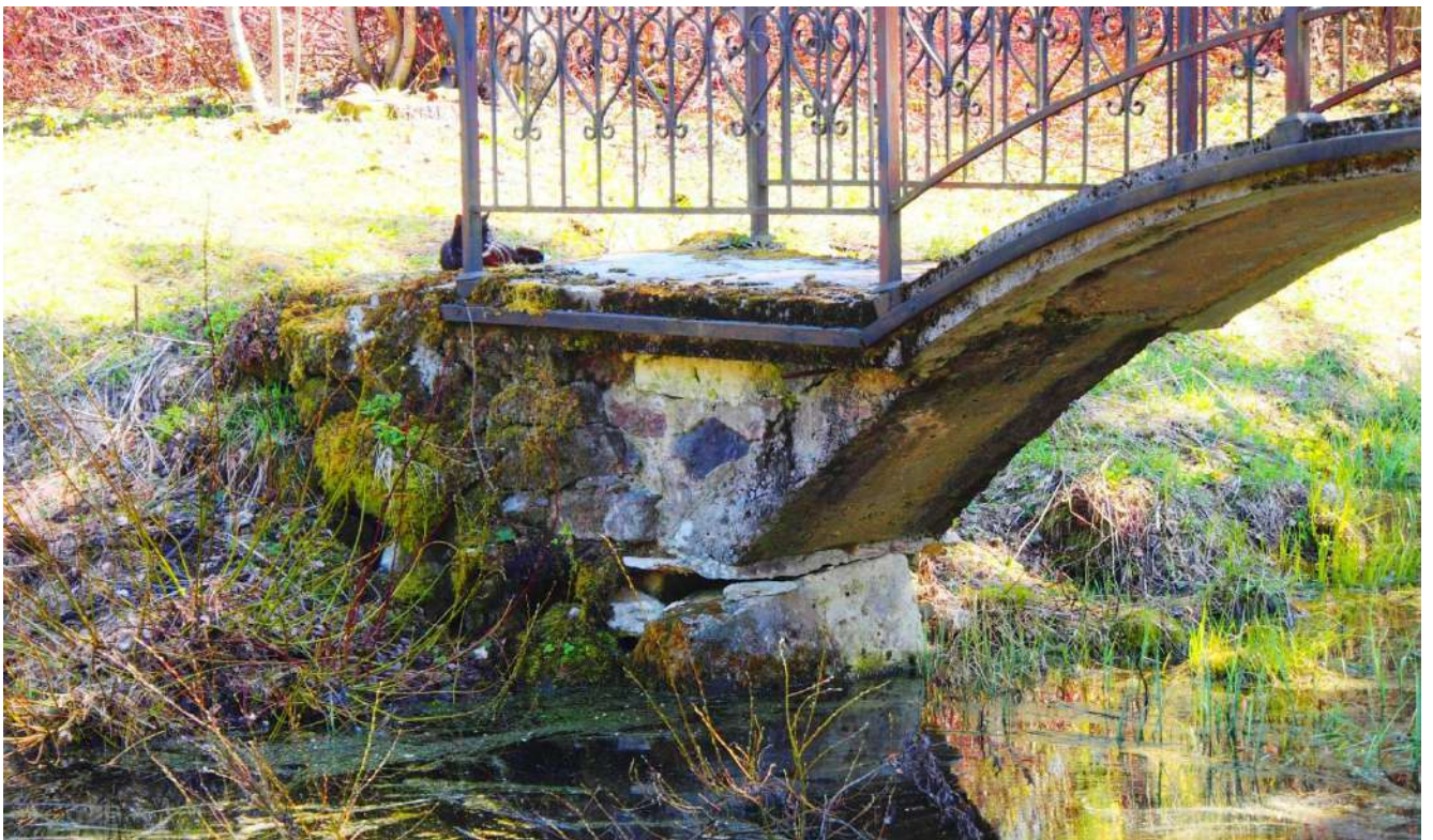
10. Фрагмент валунной кладки в опоре мостика. Вид с северо-запада.
