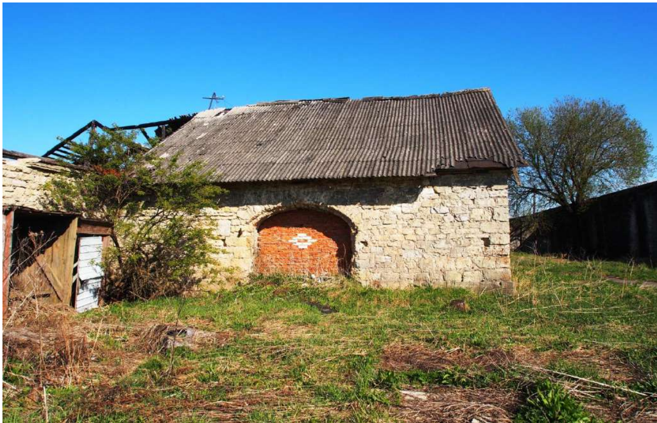
55. Рига. Ризалит южного фасада с лучковым проемом ворот. Вид с запада.
