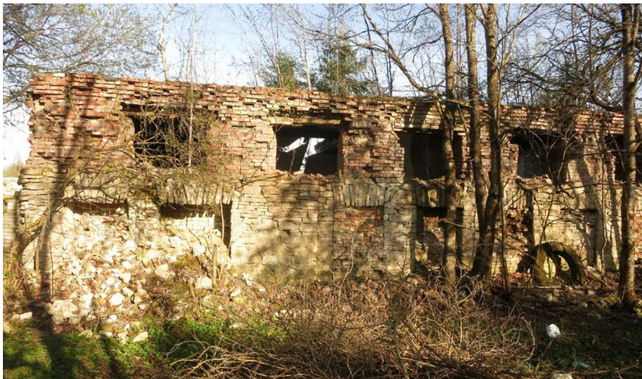
43. Конюшня. Вид с северо-запада.
