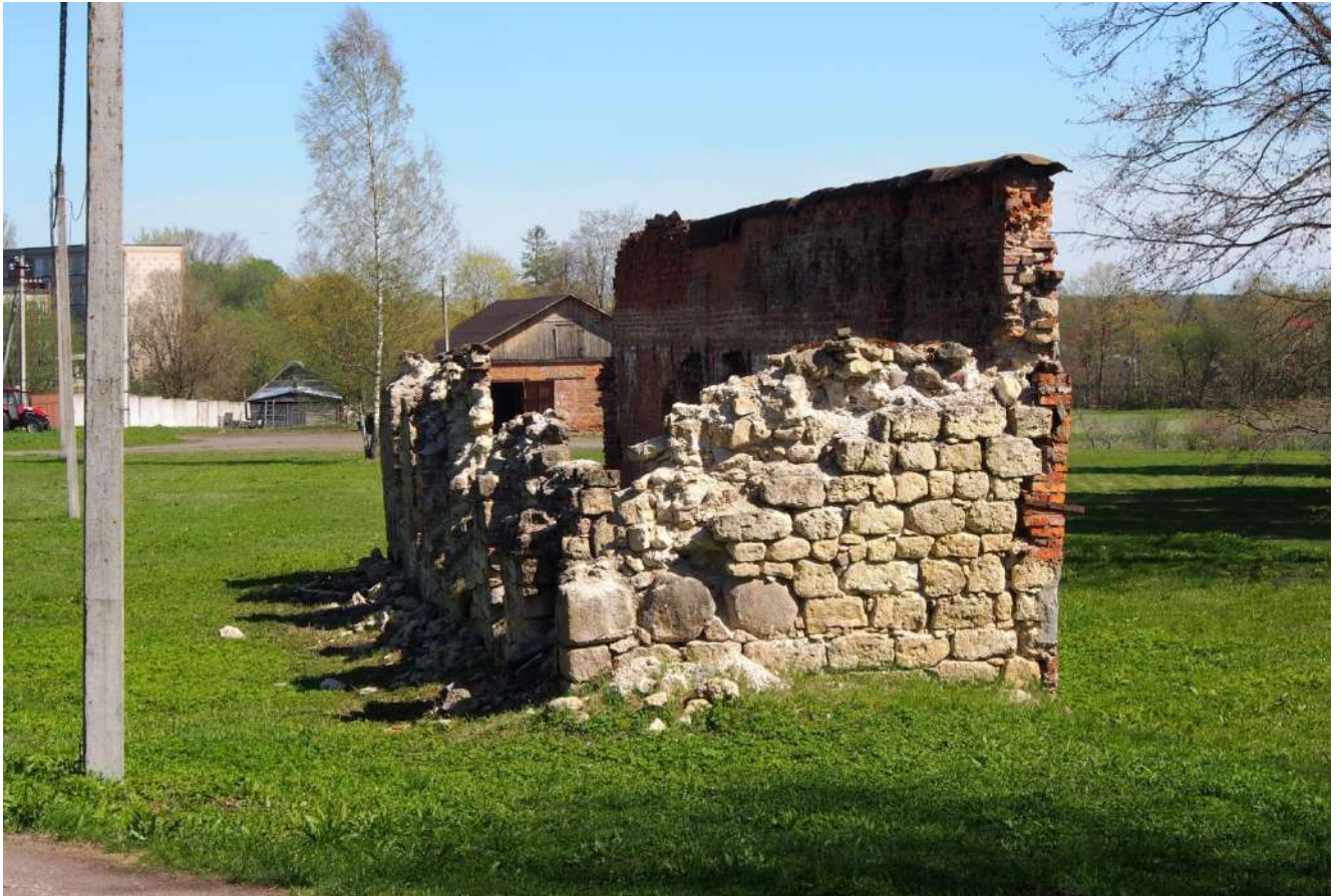
13. Руины оранжереи в усадебном парке. Вид с запада.
