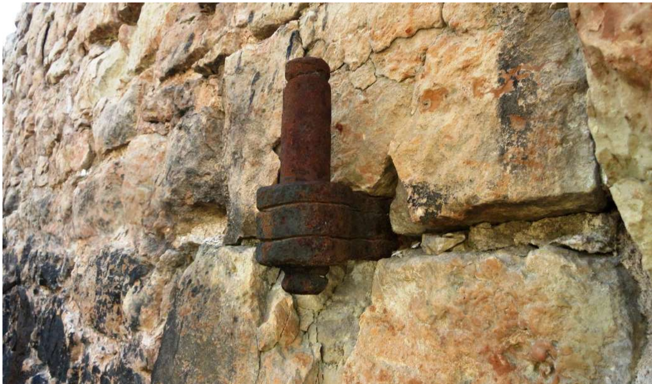
60. Рига. Металлический подстав ворот в стене проема западного фасада.
