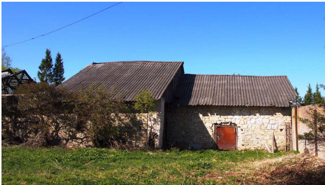
51. Рига. Восточное крыло. Вид с юга.
