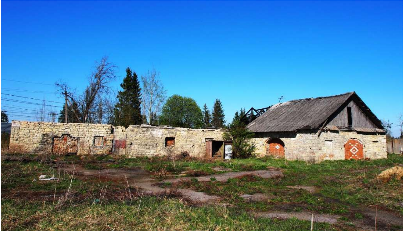
45. Рига. Западное крыло. Вид с юго-запада.
