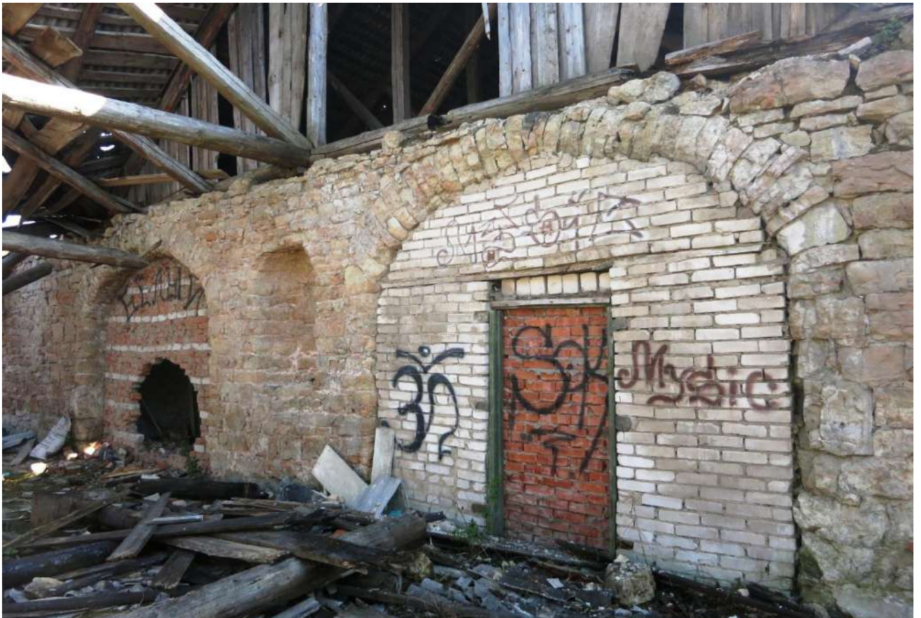
58. Рига. Заложенные проемы ворот с лучковыми перемычками в ризалите южного фасада.
