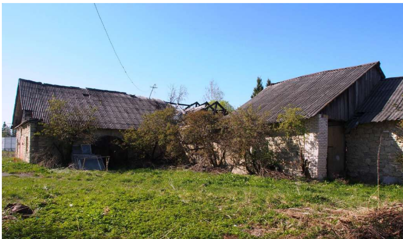
52. Рига. Ризалит южного фасада с лучковым проемом ворот. Вид с юго-востока.
