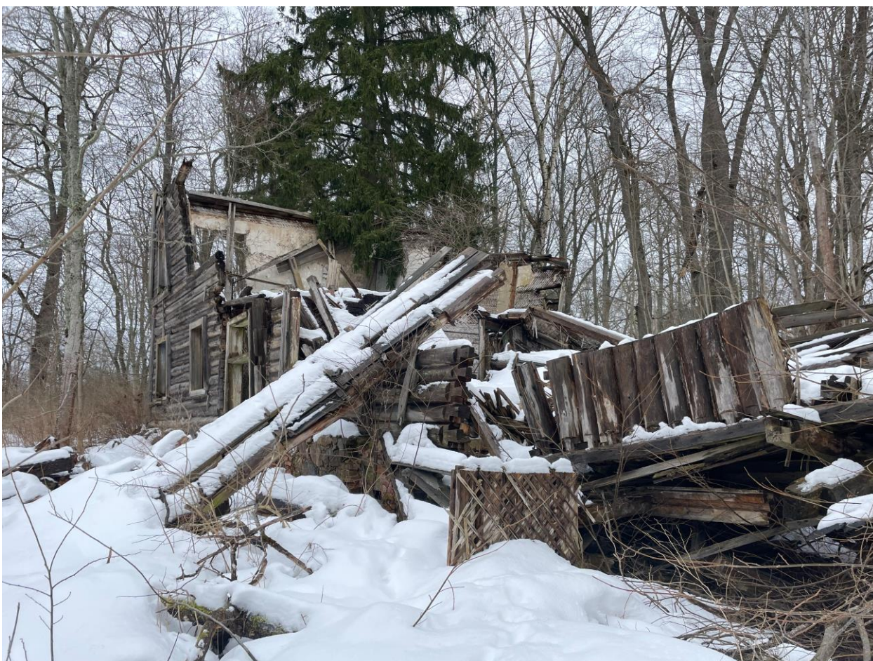
Фото 34. Объект культурного наследия регионального значения «Флигель (деревянный)»
