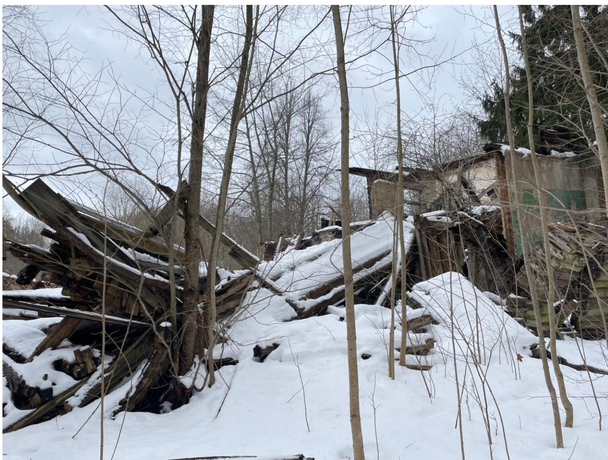
Фото 32. Объект культурного наследия регионального значения «Флигель (деревянный)»
