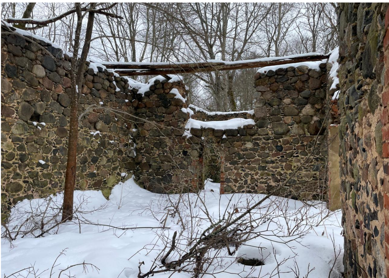
Фото 25. Объект культурного наследия регионального значения «Каретный сарай (каменный)». Интерьер.
