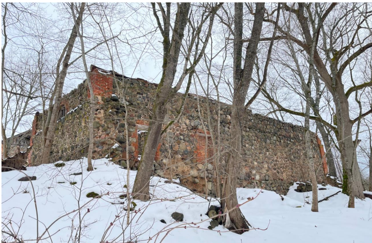
Фото 23. Объект культурного наследия регионального значения «Каретный сарай (каменный)»
