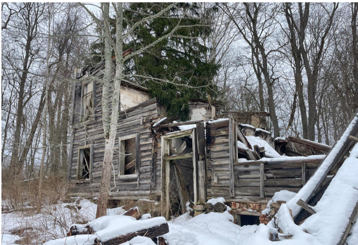
Фото 35. Объект культурного наследия регионального значения «Флигель (деревянный)»
