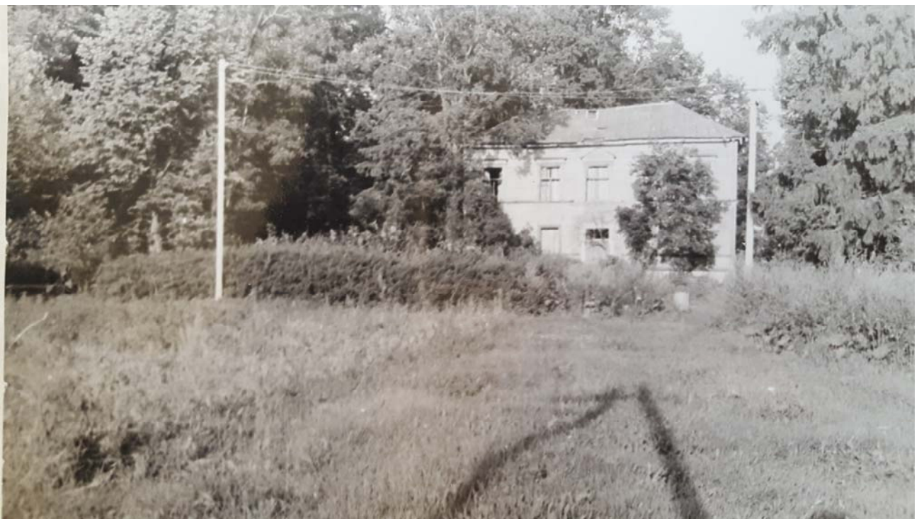
Илл. 42. Фото 1988 г. Вид на здание флигеля с востока.
