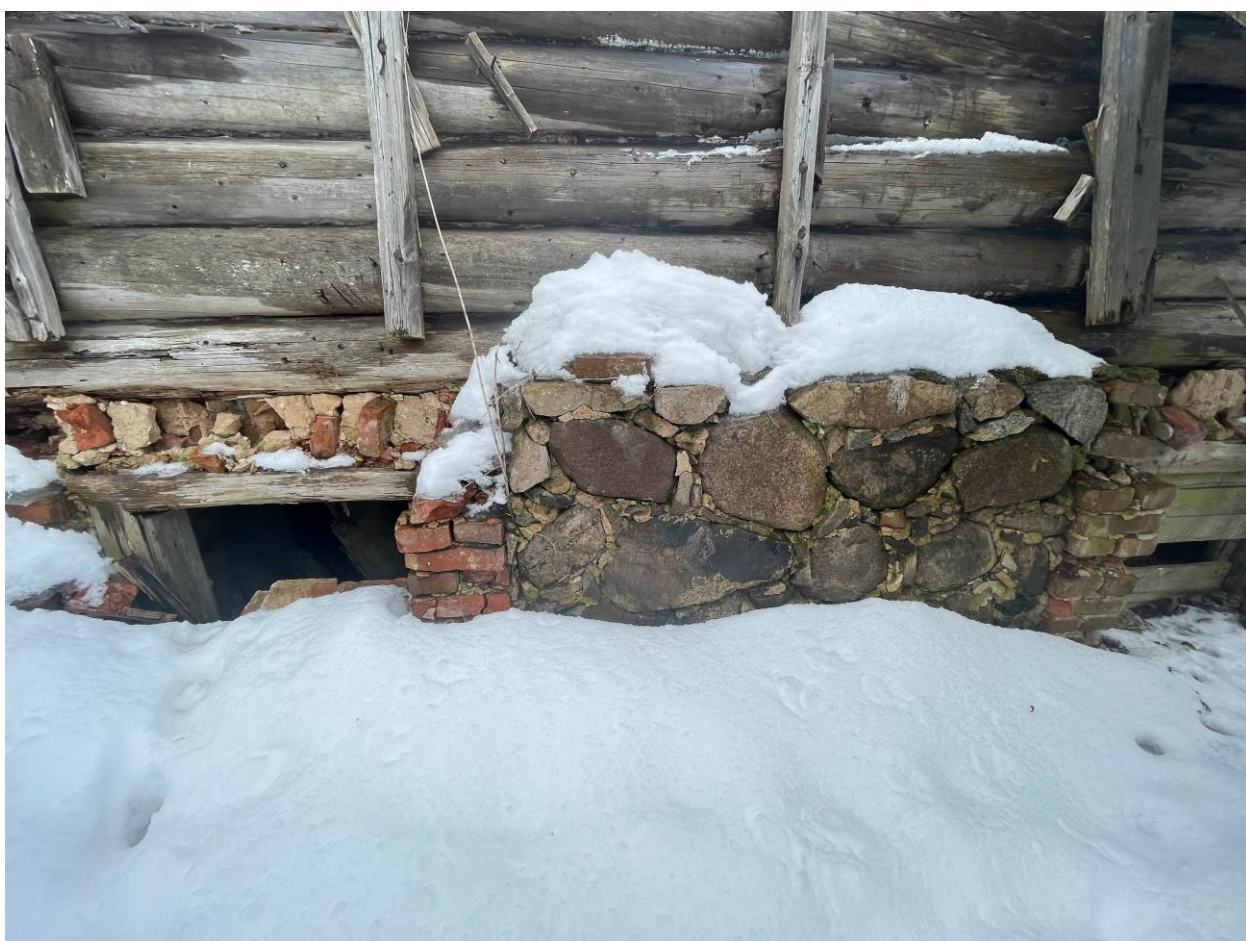
Фото 36. Объект культурного наследия регионального значения «Флигель (деревянный)»
