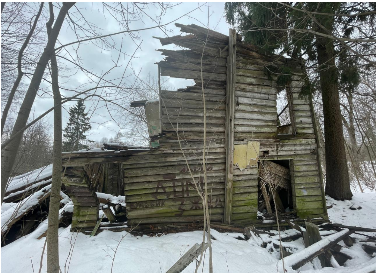
Фото 30. Объект культурного наследия регионального значения «Флигель (деревянный)»
