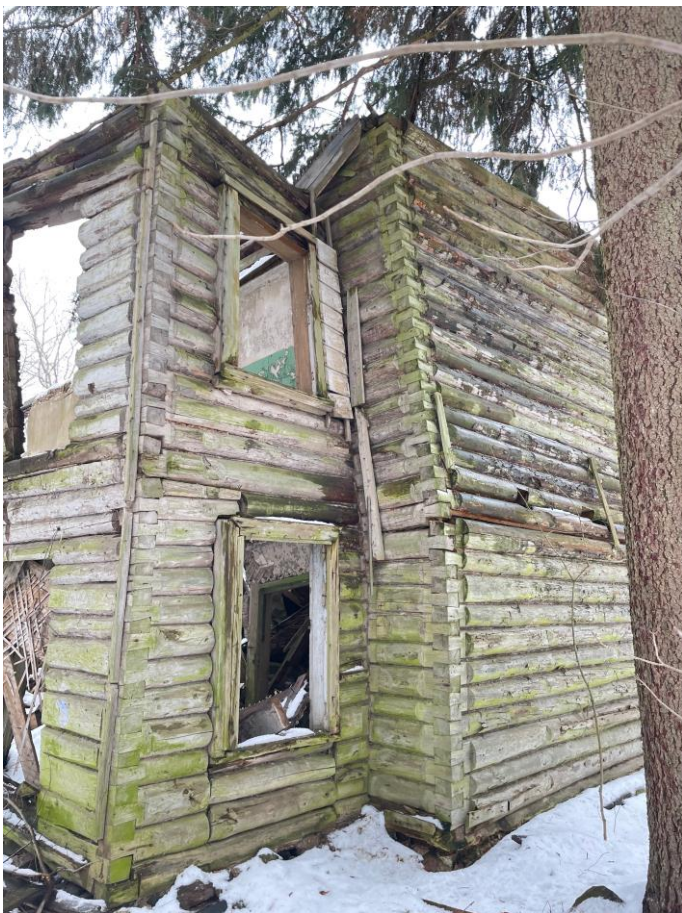
Фото 29. Объект культурного наследия регионального значения «Флигель (деревянный)»
