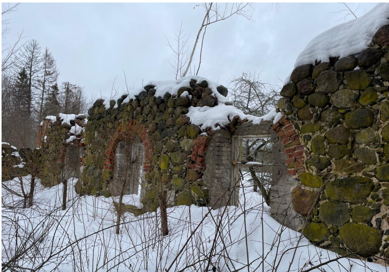
Фото 19. Объект культурного наследия регионального значения «Конюшня (каменная)». Интерьер.
