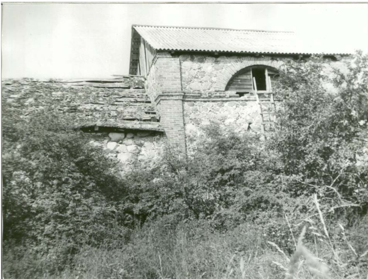
Илл. 62. Здание конюшни. Фотография 1992 г.
