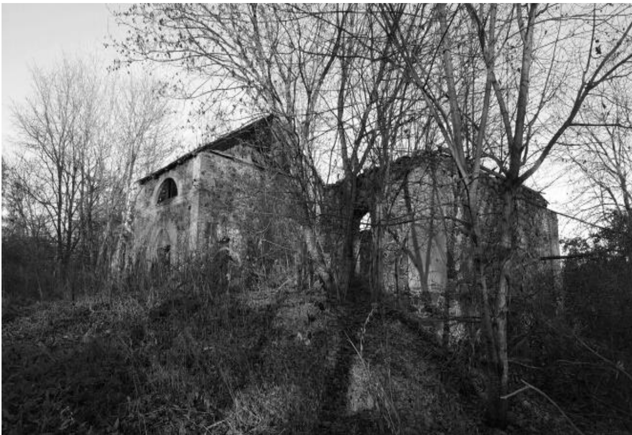
Илл. 66. Здание конюшни. Фотография 1990 г.
