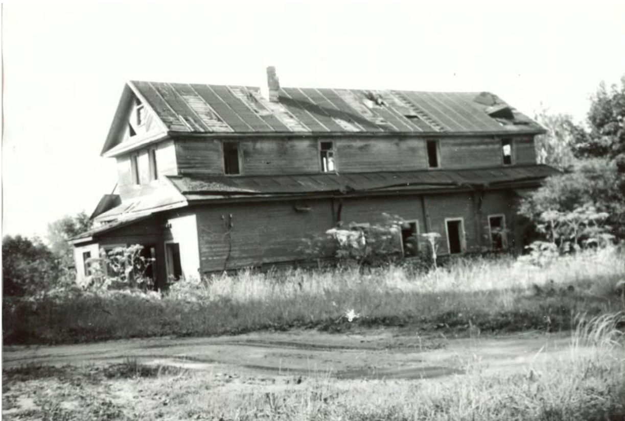
Илл. 60. Здание школы. Фотография 1992 г.
