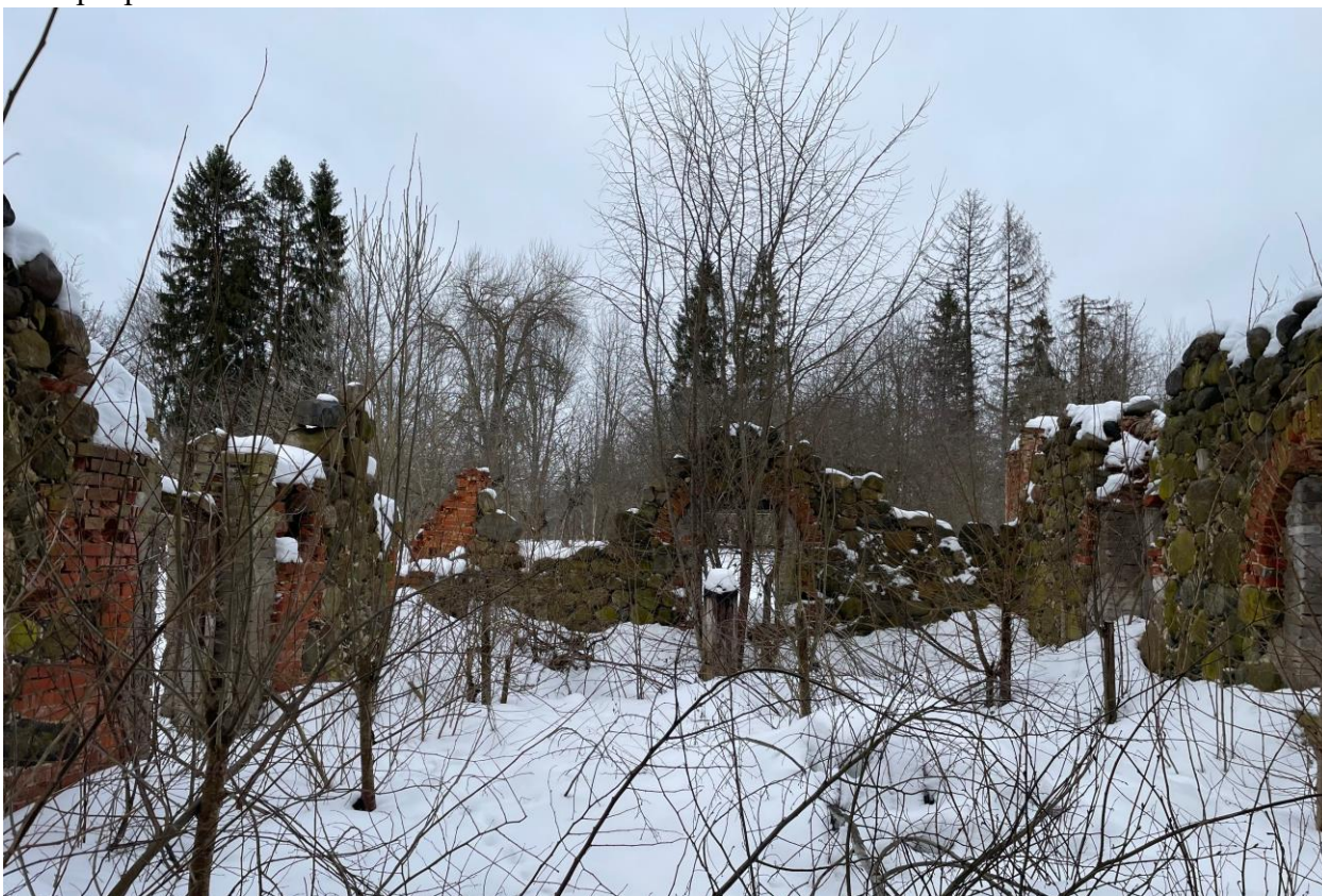
Фото 18. Объект культурного наследия регионального значения «Конюшня (каменная)». Интерьер.
