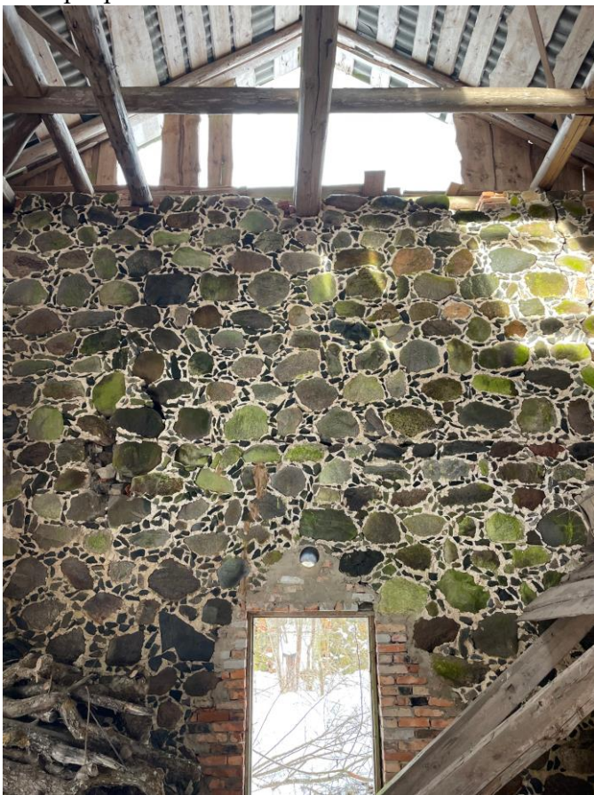
Фото 16. Объект культурного наследия регионального значения «Конюшня (каменная)». Интерьер.
