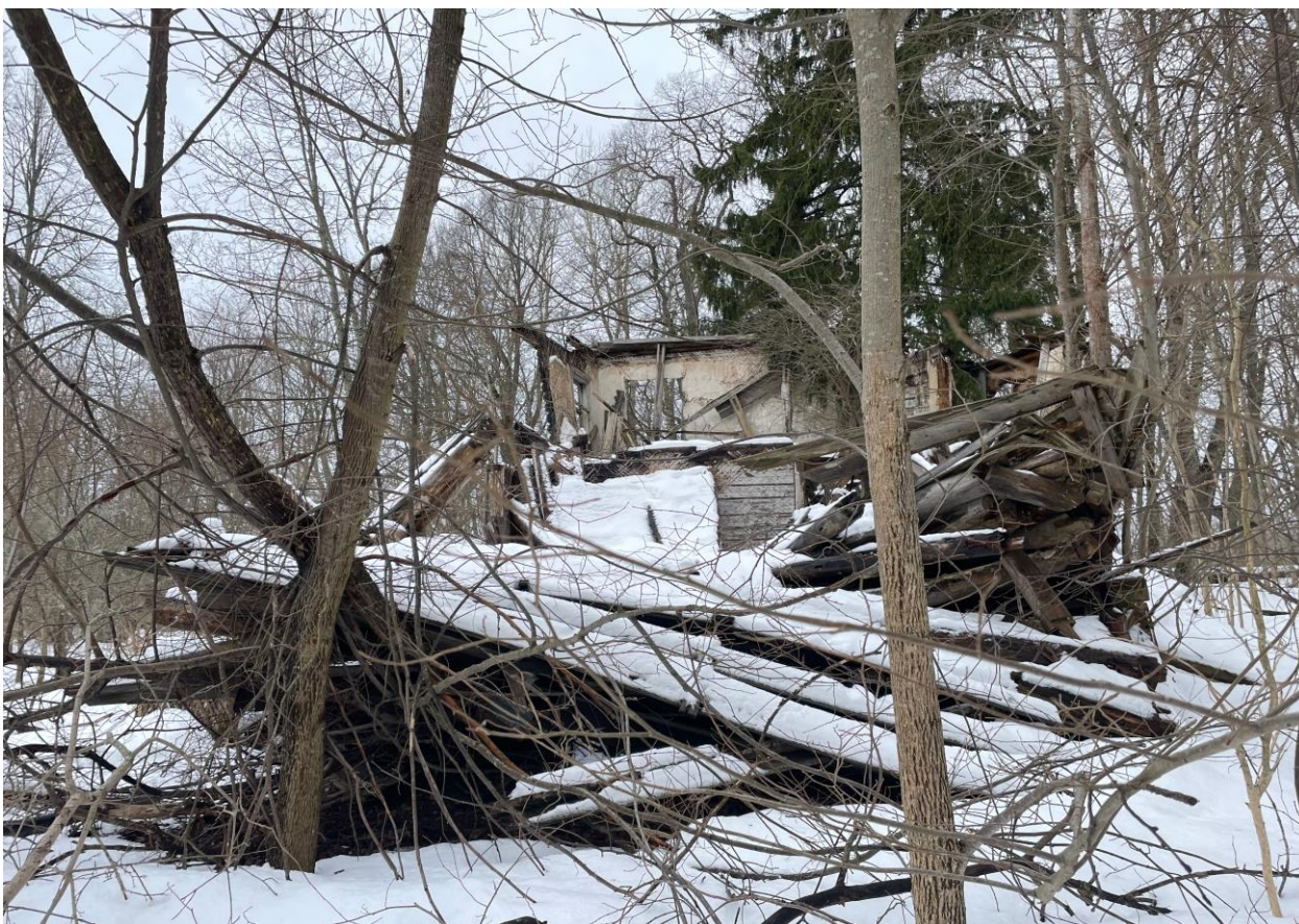
Фото 33. Объект культурного наследия регионального значения «Флигель (деревянный)»
