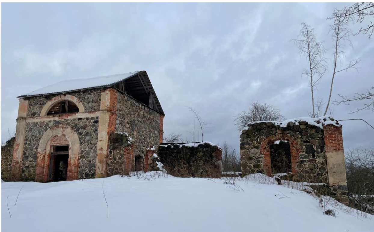
Фото 11. Вид на объект культурного наследия регионального значения «Конюшня (каменная)»
