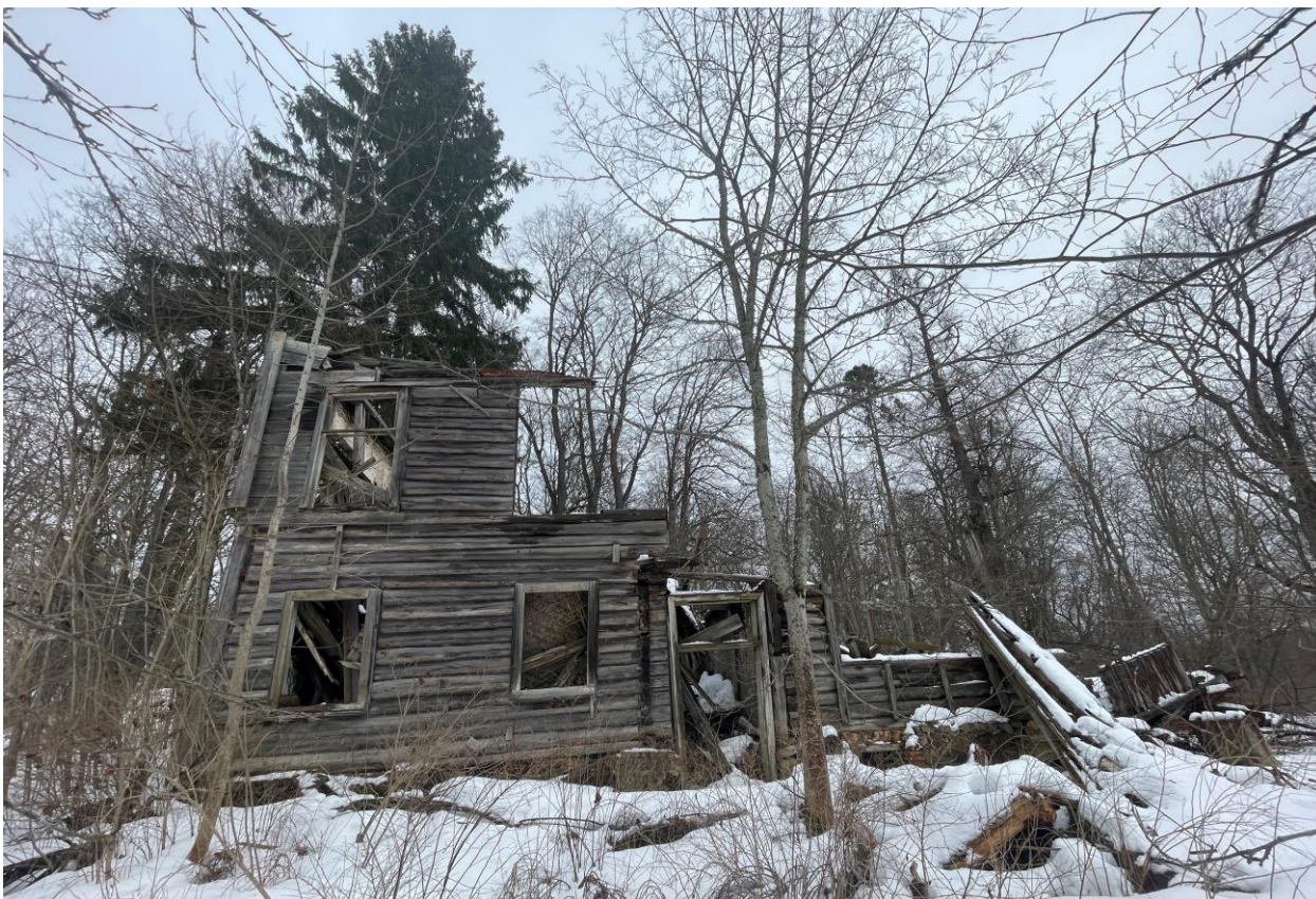
Фото 38. Объект культурного наследия регионального значения «Флигель (деревянный)»
