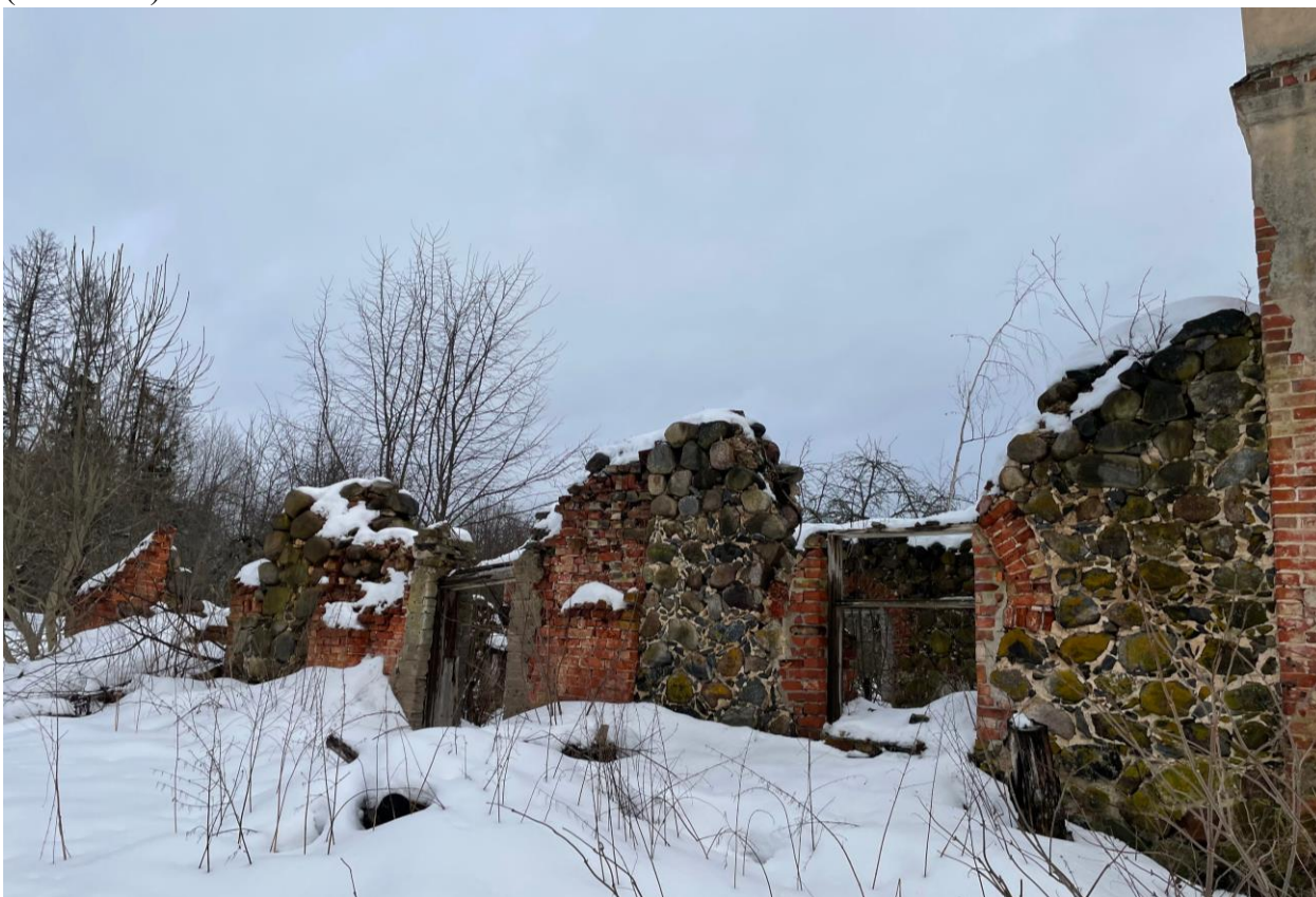
Фото 10. Вид на объект культурного наследия регионального значения «Конюшня (каменная)»
