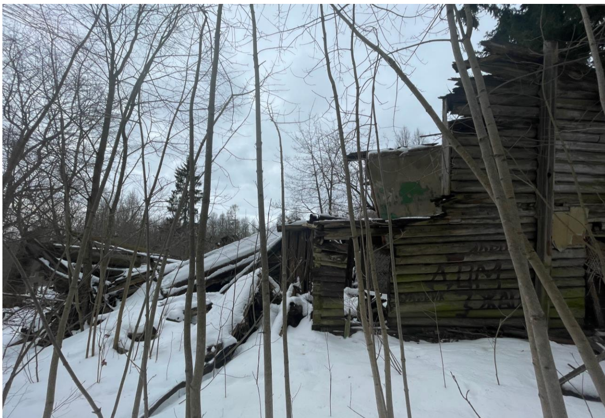
Фото 31. Объект культурного наследия регионального значения «Флигель (деревянный)»
