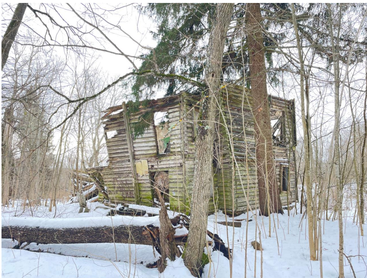
Фото 28. Объект культурного наследия регионального значения «Флигель (деревянный)»
