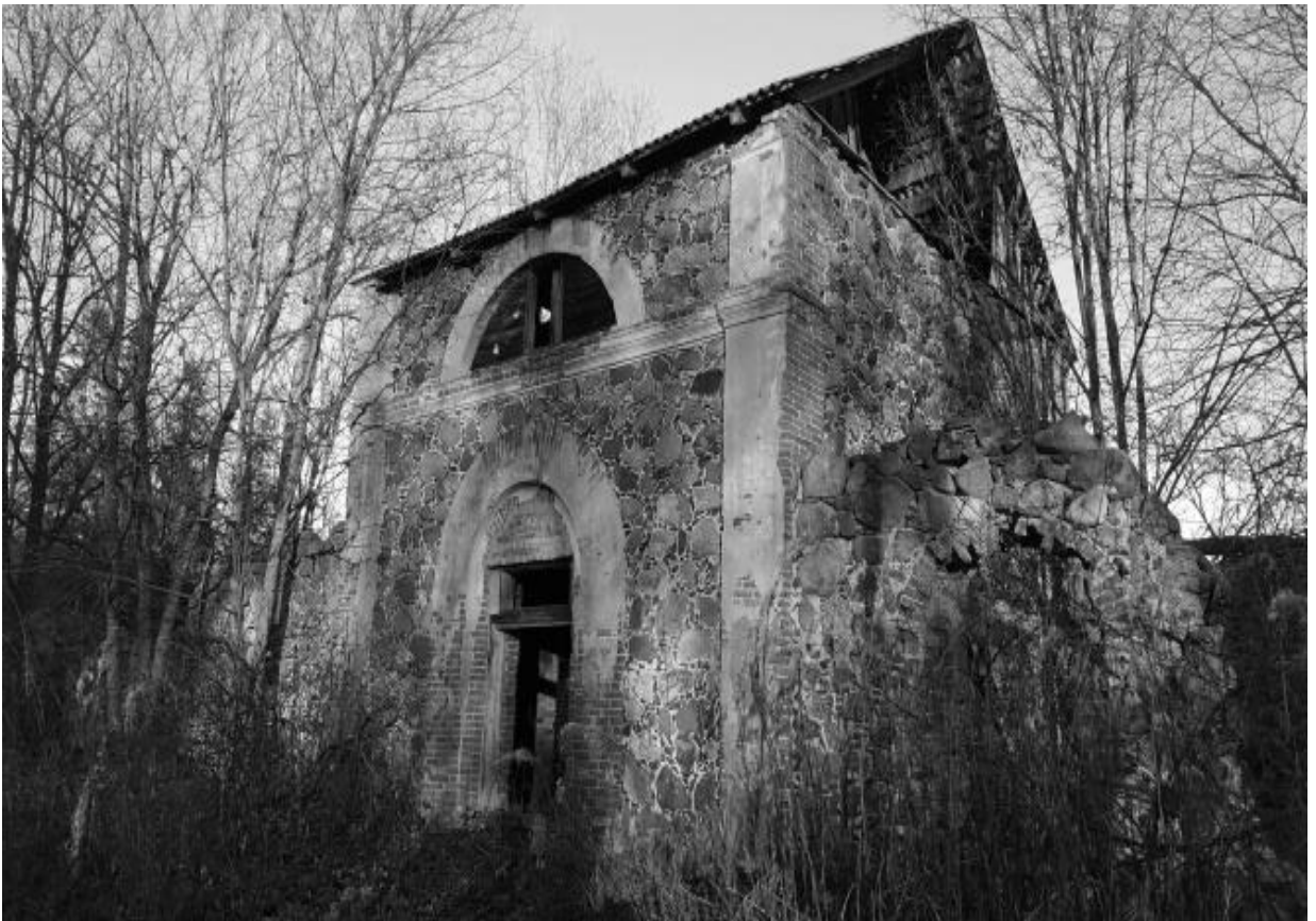
Илл. 65. Здание конюшни. Фотография 1990 г.
