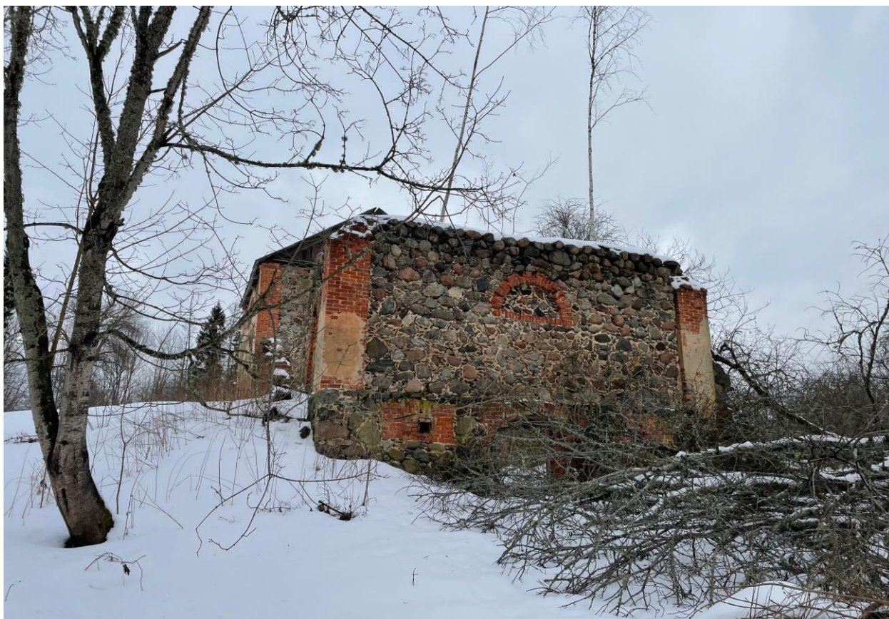
Фото 13. Вид на объект культурного наследия регионального значения «Конюшня (каменная)»
