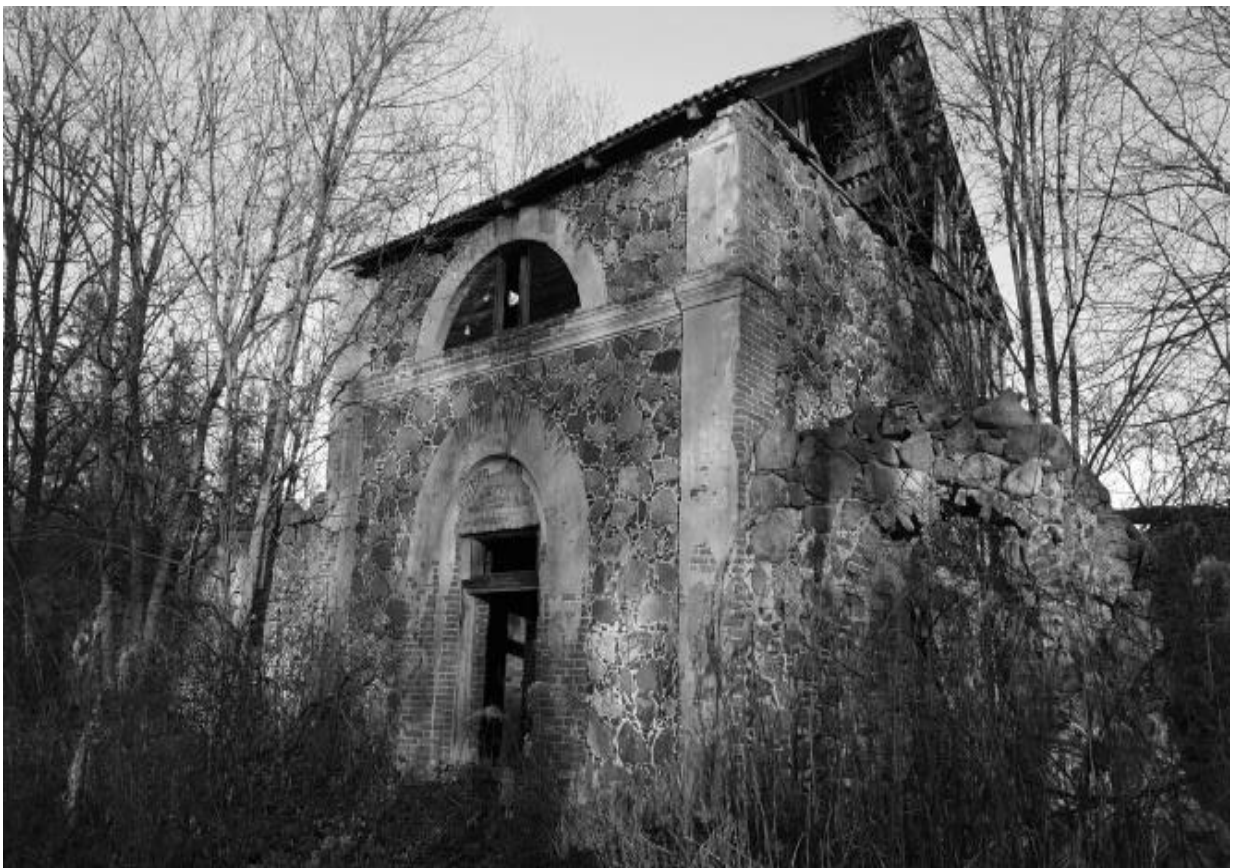
Илл. 41. Здание конюшни. Фотография 1990 г.
