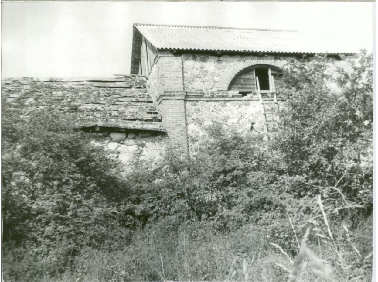
Илл. 38. Здание конюшни. Фотография 1992 г.
