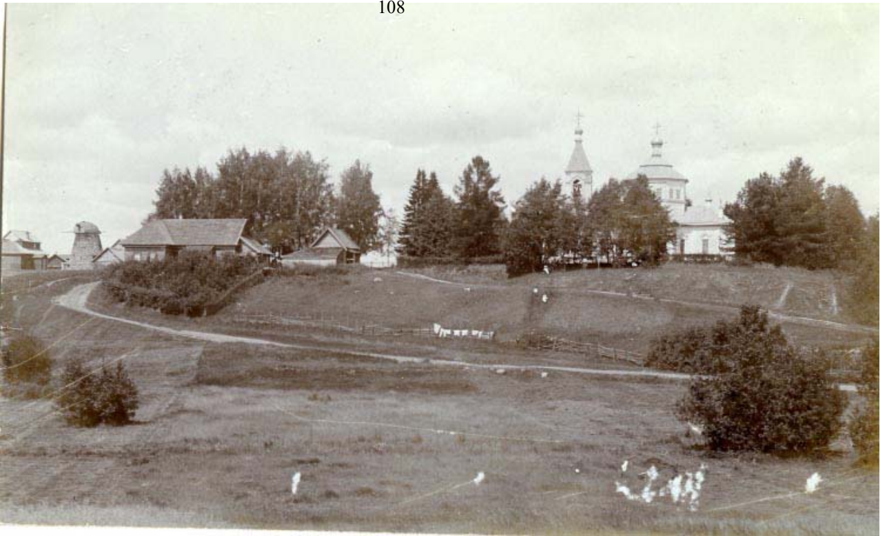
Илл. 55 Фото территории объекта культурного наследия регионального значения «Усадьба Муравьевых-Шереметьевых «Сырец» (общий вид) (фото из архива Катаева А.А.)
