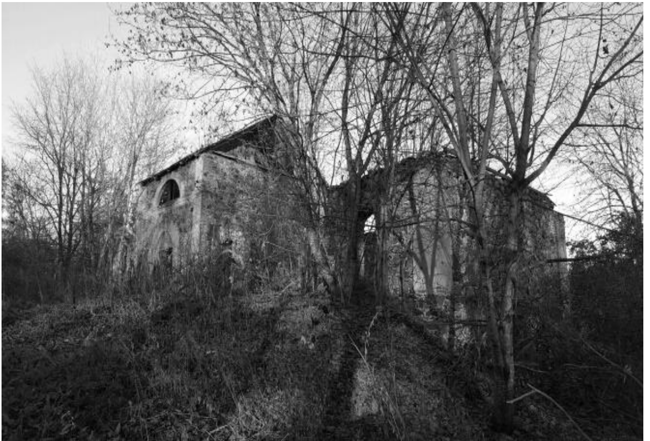
Илл. 42. Здание конюшни. Фотография 1990 г.
