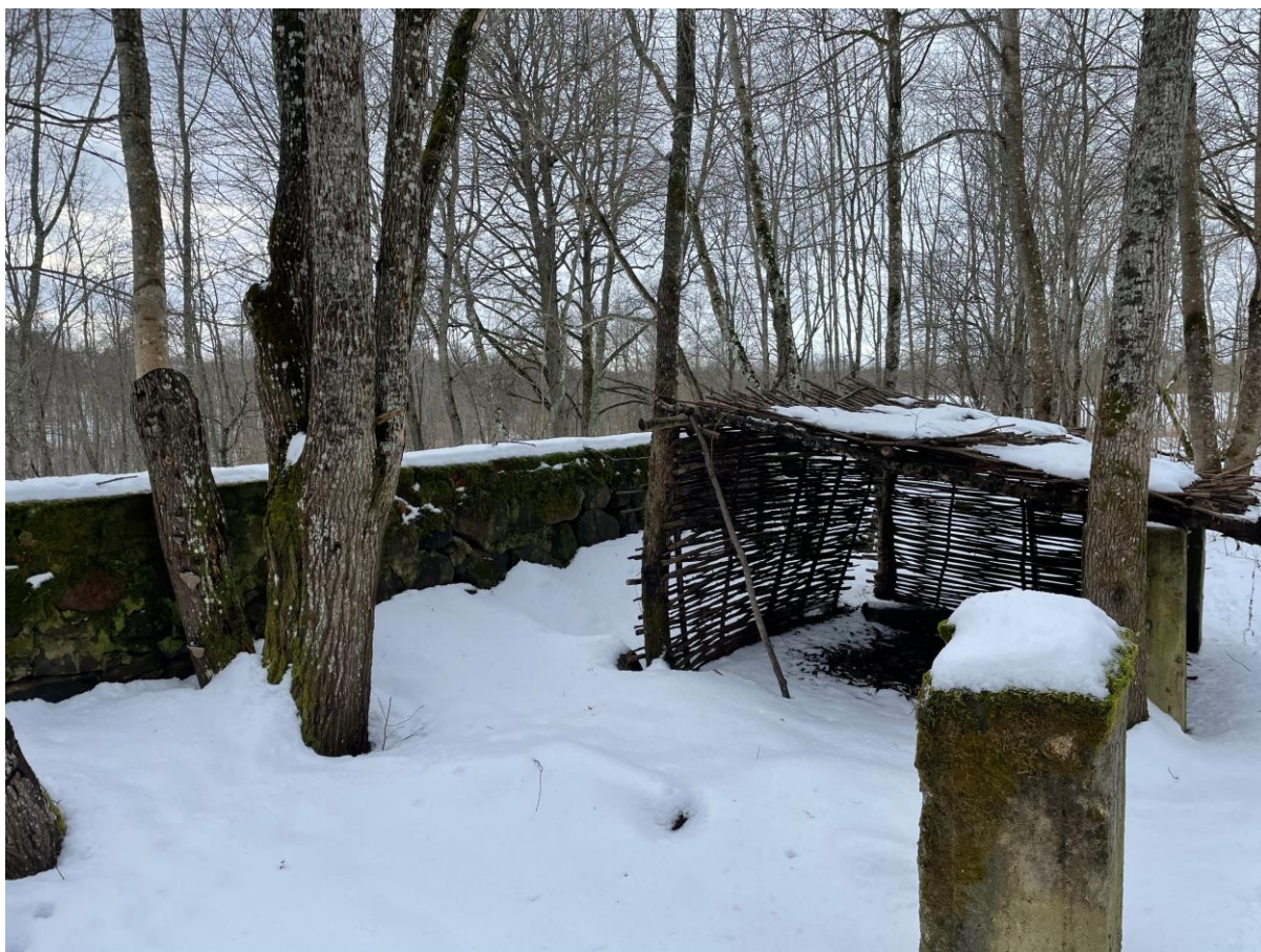
Фото 5. Фундамент школы южнее фундаментов церкви.
