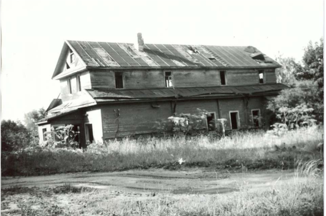
Илл. 36 Здание школы. Фотография 1992 г.
