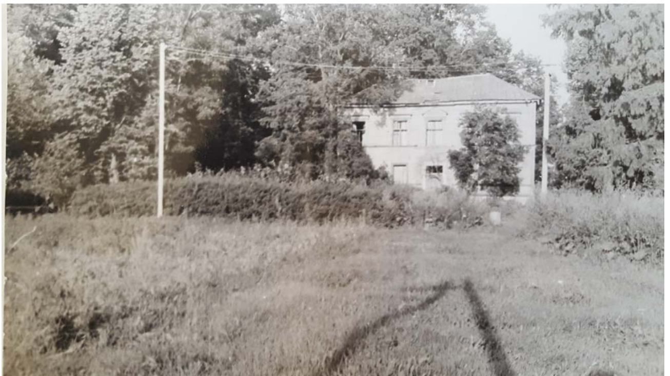
Илл. 18. Фото 1988 г. Вид на здание флигеля с востока.
